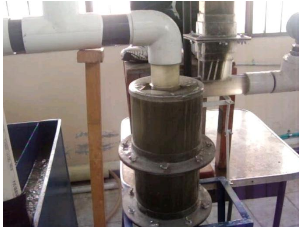
Figura 6.13 hidrociclón en funcionamiento
