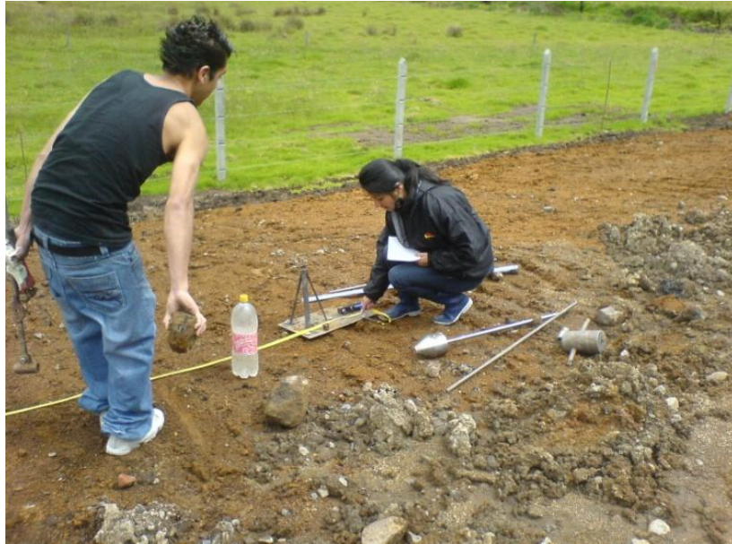
Fotografía 36: Medida del punto donde comienza el ensayo.
