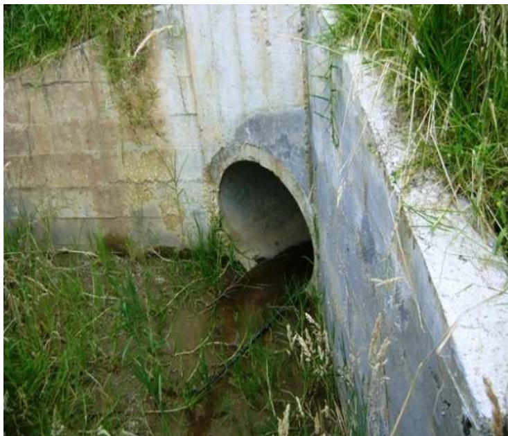
Fotografía N° 17: K3+0000, Salida de alcantarilla de 36" nueva, en buen estado, N1 30.545 W77 07.563
