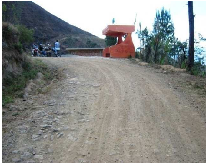
Fotografía N° 4 PR 0+0000 A 3,3km del parque de Berruecos Intersección Berruecos - Santa Rosa, paradero de Bus. N1 29.078 W77 08.618
