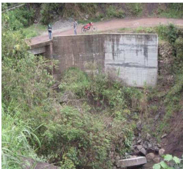
Fotografía N° 44: K6+0650, N1 35.620 W77 06.232, Muro de contención.
