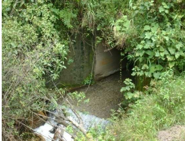
Fotografía N° 83: K2+0350, salida de box culvert, N1 31.664 W77 05.107
