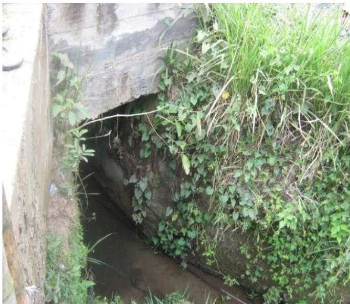
Fotografía N° 66: K1+0750, pontón, N1 38.000 W77 09.467.
