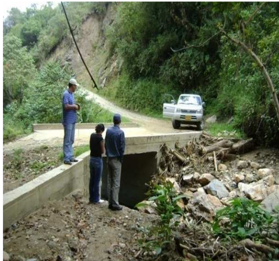
Fotografía N° 78: K8+0500, finaliza jurisdicción municipal de San Pedro de Cartago e inicia San Bernardo, N1 32.359 W77 03.465
