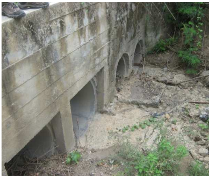
Fotografía N° 67: K17+0000, Alcantarillas gemelas antiguas y nuevas, N1 39.435 W77 12.716.
