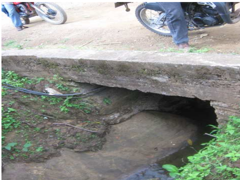
Fotografía N° 61: K3+0100, pontón, N1 37.546 W77 07.062.
