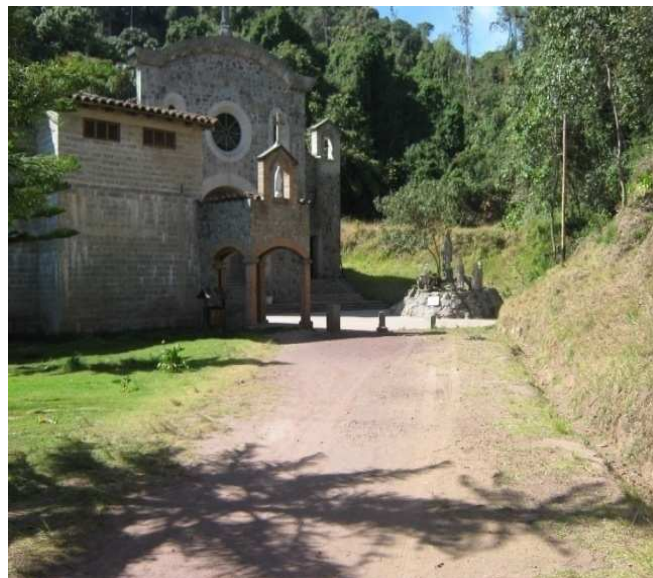
Fotografía N° 20: La Hermita Santa María Magdalena, ubicada en la vereda San Francisco, N1 32.010 W77 09.401
