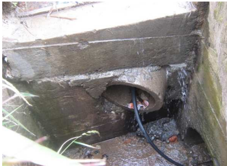
Fotografía N° 58: K0+0900, Caja de entrada de alcantarilla diagonal, N1 36.812 W77 07.249
