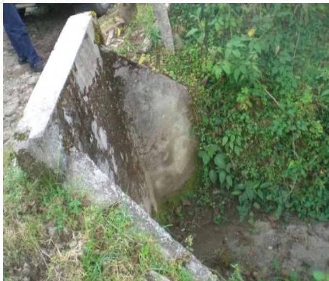
Fotografía N° 33: K8+0800, Caja de salida de alcantarilla, N1 34.325 W77 08.017
