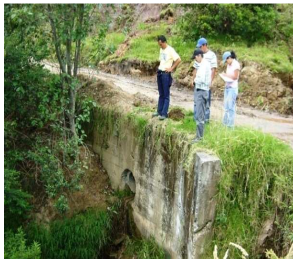
Fotografía N° 14: K4+0100, alcantarilla, fin de jurisdicción municipal de Arboleda e inicia San Pedro De Cartago. N1 30.772 W77 07.115
