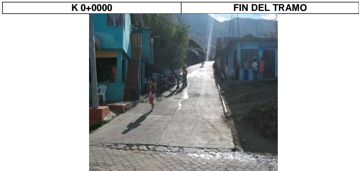
Fotografía N° 13: K0+0000, a 100m del parque de Berruecos, N1 30.152 W77 08.144
