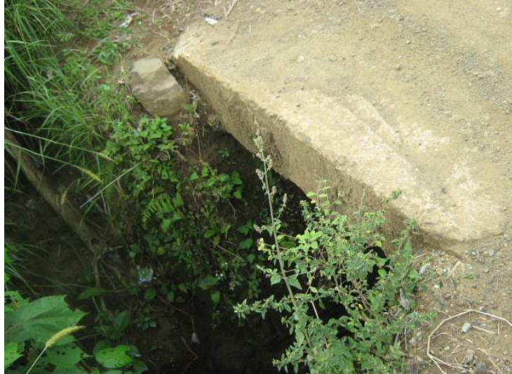
Fotografía N° 59: K2+0000, pontón, N1 37.101 W77 07.150
