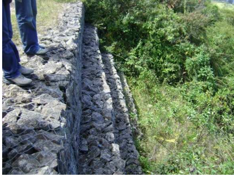
Fotografía N° 81: K0+0430, muro en gaviones, N1 31.469 W77 05.473
