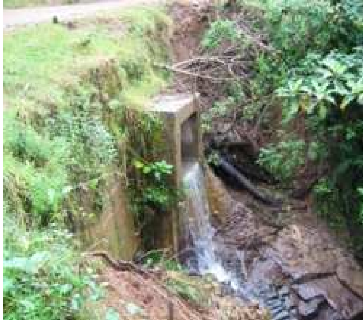
Fotografía N° 32: K5+0200, Salida de Box culvert, de 1m*1m, N1 33.477 W77 08.600.
