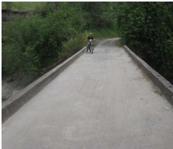
Fotografía N° 63: K18+0850, puente Los Olivos, N1 39.407 W77 13.517.
