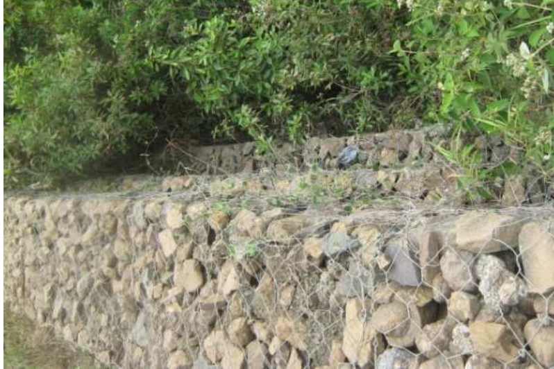
Fotografía N° 49: K2+0450, muro en gaviones, N1 38.865 W77 09.054
