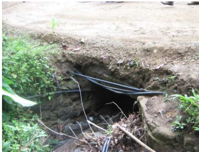
Fotografía N° 60: K2+0500, alcantarilla en piedra con tubo de 16", se necesita una nueva, N1 37.251 W77 07.061.
