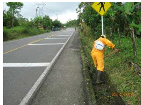
RUTA: 1001 TUMACO – JUNÍN PR 82+0700, MAYO 12 DE 2009 LIMPIEZA DE CUNETAS
