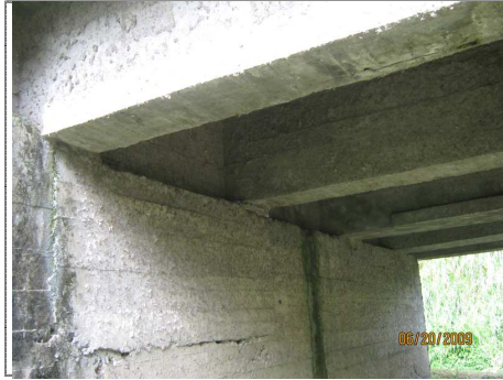
FOTO 7 LOSA, VIGAS Y ESTRIBO No 2
