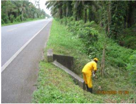
RUTA: 1001 TUMACO – JUNÍN PR 33+0200, MAYO 27 DE 2009. LIMPIEZA DE ALCANTARILLAS
