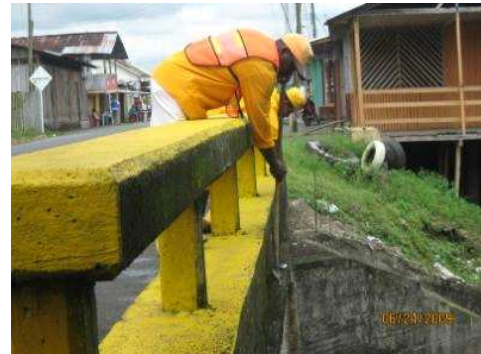
RUTA: 1001 TUMACO – JUNÍN JUNIO 24 DE 2009 LIMPIEZA DE PUENTES Y BARANDAS
