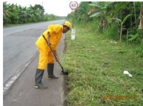
RUTA: 1001 TUMACO – JUNÍN PR 16+0000 MAYO 14 DE 2009. PROTECCION DE BERMAS.
