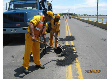
Fotografía 28. Bacheo Puente el Morro. Cooperativa el Mira Ltda.
