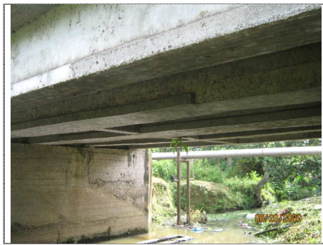
FOTO 15 VIGAS Y LOSA
