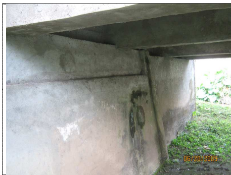
FOTO 5 VISTA DE LOSA , VIGAS Y ESTRIBO No. 1
