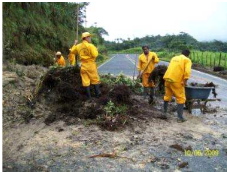
RUTA: 1001 TUMACO – JUNÍN PR 117+0700 JUNIO 9 y 10 DE 2009. REMOCIÓN DE DERRUMBES. ANTES
