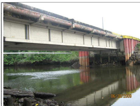
FOTO 11 VISTA LATERAL DE SUPERESTRUCTURA
