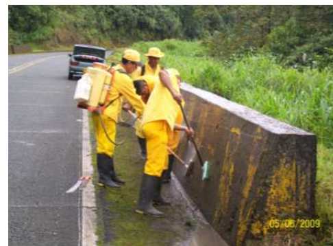
RUTA: 1001 TUMACO – JUNÍN PR115+0200. JUNIO 6 DE 2009. LIMPIEZA DE MUROS.
