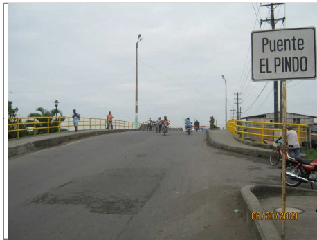
FOTO 1 BARANDAS, ANDENES Y ACCESO No. 1
