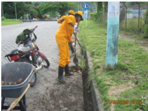
RUTA: 1001 TUMACO – JUNÍN JUNIO 11 DE 2009. PR 0+0150. LIMPIEZA DE ALCANTARILLAS , CANALES Y SUMIDEROS
