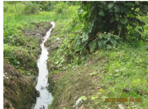
RUTA: 1001 TUMACO – JUNÍN MAYO 27 DE 2009 LIMPIEZA DE DESCOLES. DESPUES
