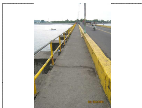
FOTO 10 ANDENES Y BORDILLOS LADO DERECHO
