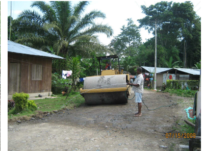
Fotografía 26. Compactación de afirmado vía Cajapí-Pena Colorada PR 4+0500
