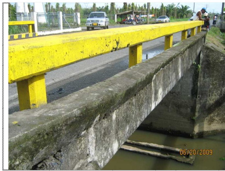
FOTO 16 BARANDA LADO IZQUIERDO Y VIGA
