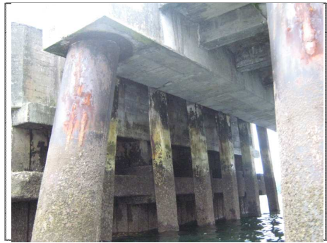
FOTO 2 PILA Y VISTA ESTRIBO No 1
