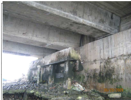
FOTO 3 VISTA ESTRIBO No 1 Y LOSA
