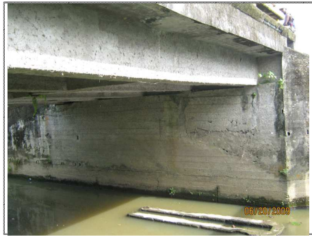
FOTO 14 VIGAS Y ESTRIBO
