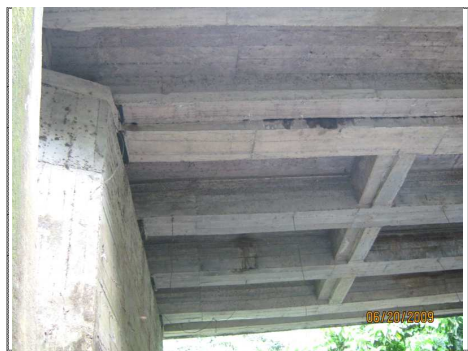
FOTO 10 ESTRIBO No. 2 Y LOSA
