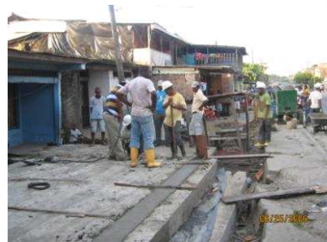
RUTA: 1001 TUMACO – JUNÍN SUPERVISIÓN EN FUNDICIÓN DE PUENTES PALAFÍTICOS MODULO 3
