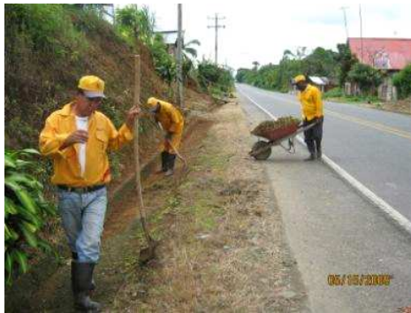
RUTA: 1001 TUMACO – JUNÍN PR 58+0100 MAYO 15 DE 2009. LIMPIEZA DE CUNETAS
