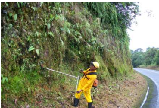
RUTA: 1001 TUMACO – JUNÍN JUNIO 5 DE 2009. ROCERIA Y DESMONTE MANUAL
