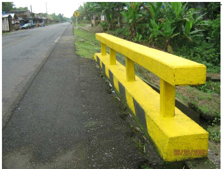
FOTO 3 BARANDAS LADO DERECHO
