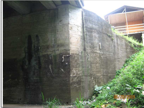
FOTO 7 ALETA Y ESTRIBO No. 2 LADO DERECHO
