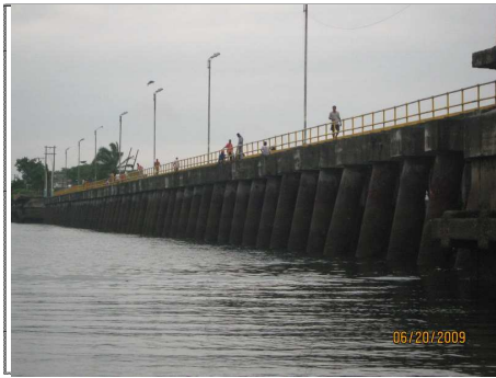
FOTO 1 VISTA LATERAL DEL VIADUCTO EL MORRO
