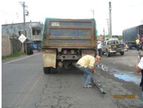
RUTA: 1001 TUMACO – JUNÍN SUPERVISIÓN EN ESTUDIOS PUENTE EL PINDO - MEDIDA DE DEFLEXIONES EN PAVIMENTO
