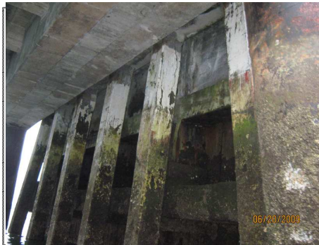
FOTO 3 VISTA ESTRIBO No 2
