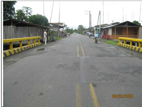
FOTO 1 SUPERFICIE DEL PUENTE Y ACCESO No. 1
