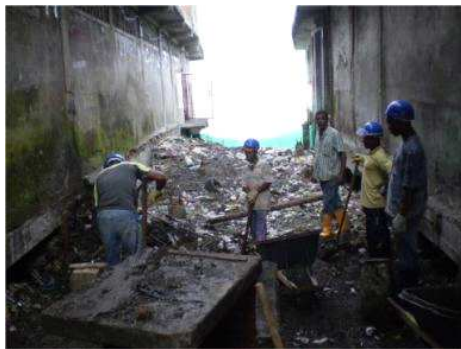
RUTA: 1001 TUMACO – JUNÍN SUPERVISIÓN PUENTES PALAFÍTICOS - DEMOLICIÓN MUELLE MODULO 4
