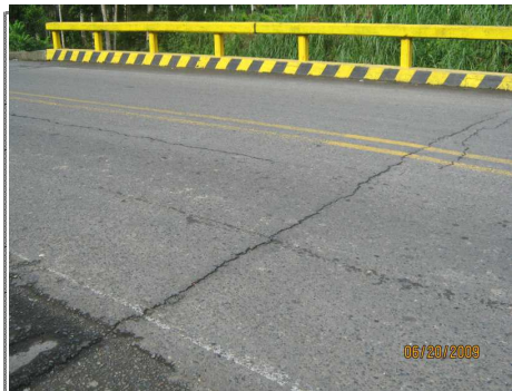
FOTO 3 SUPERFICIE, BARANDA LADO IZQUIERDO Y JUNTA DE EXPANSION No 1
