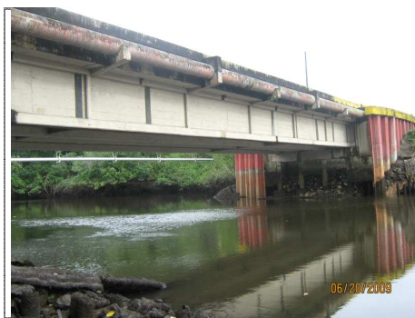
FOTO 11 VISTA LATERAL DE SUPERESTRUCTURA
