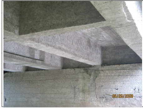
FOTO 8 LOSA, VIGAS Y ESTRIBO No 2
