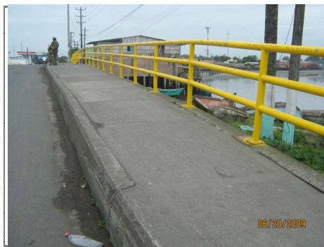
FOTO 4 BARANDAS Y ANDEN DERECHO
