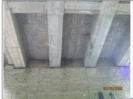
FOTO 8 ESTRIBO No. 1 , LOSA Y VIGAS
