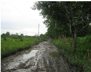
Fotografía 21. Vía Buchelli - Descolgadero PR 6+0500
