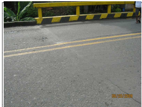
FOTO 12 SUPERFICIE DEL PUENTE Y JUNTA DE EXPANSION No 1
