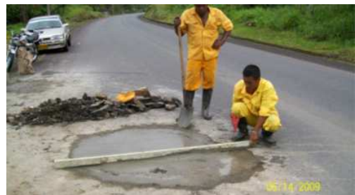
RUTA: 1001 TUMACO – JUNÍN PR 96+0900. MAYO 14 DE 2009 BACHEO CON CONCRETO HIDRÁULICO.
