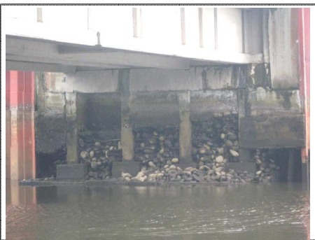
FOTO 5 VISTA DE ESTRIBO No. 1
