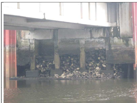
FOTO 5 VISTA DE ESTRIBO No. 1
