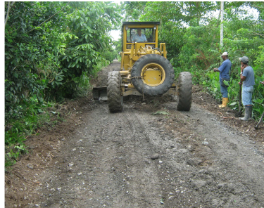
Fotografía 25. Nivelación de afirmado vía Buchelli - Descolgado PR 3+0900
