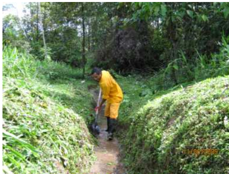
RUTA: 1001 TUMACO – JUNÍN PR 85+0500, JUNIO 11 DE 2009 SUPERVISIÓN EN LIMPIEZA DE DESCOLES.
