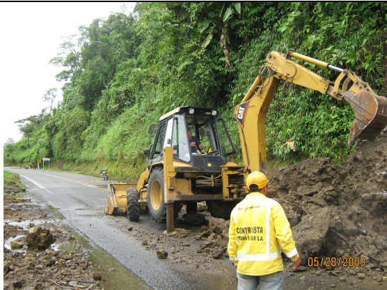
Fotografía 6. Remoción de roca con retro-cargador
