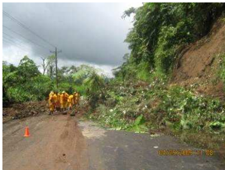
RUTA: 1001 TUMACO – JUNÍN PR 107+0000 ABRIL 29 DE 2009. REMOCIÓN DE DERRUMBES. ANTES
