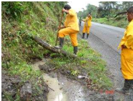
RUTA: 1001 TUMACO – JUNÍN PR 101 +0900. ABRIL 7 DE 2009. LIMPIEZA DE CUNETAS Y DESPEJE DE OBRAS HIDRÁULICAS
