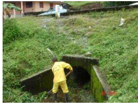
RUTA: 1001 TUMACO – JUNÍN PR 108+0000. ABRIL 22 DE 2009 LIMPIEZA DE ALCANTARILLAS
