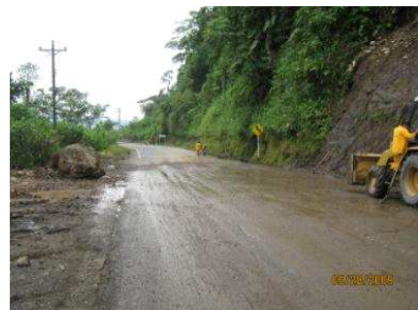
RUTA: 1001 TUMACO – JUNÍN PR 107+0000 MAYO 28 DE 2009. REMOCIÓN DE DERRUMBES. DESPUES
