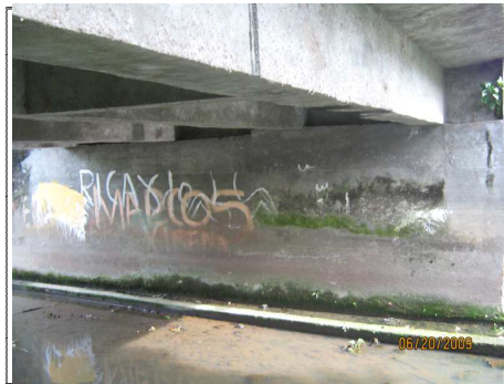
FOTO 6 VISTA DE LOSA , VIGAS Y ESTRIBO No. 2
