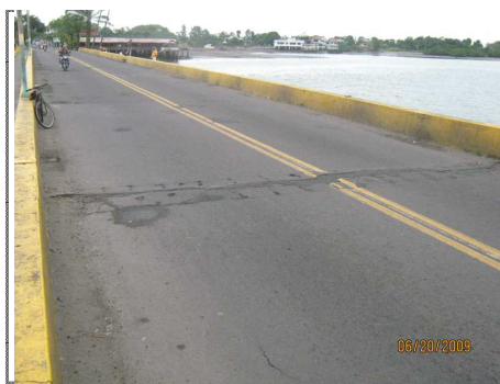
FOTO 11 JUNTA Y SUPERFICIE DEL PUENTE
