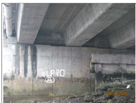
FOTO 4 LOSA Y VISTA ESTRIBO No 2
