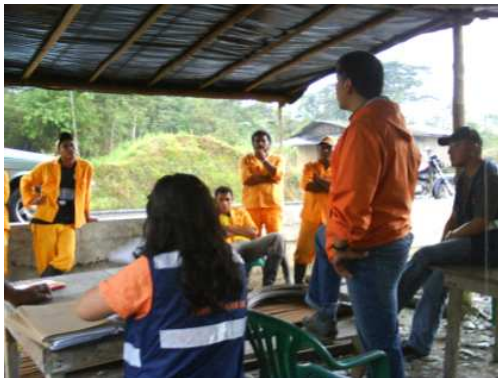
RUTA: 1001 TUMACO – JUNÍN PR 98+0700, SUPERVISIÓN DEL TRABAJO DE COOPERATIVA GUAYACAN
