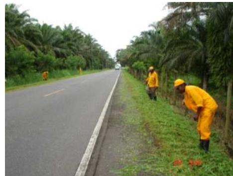
RUTA: 1001 TUMACO – JUNÍN PR 33+0500. MAYO 25 DE 2009. DESMONTE MANUAL.
