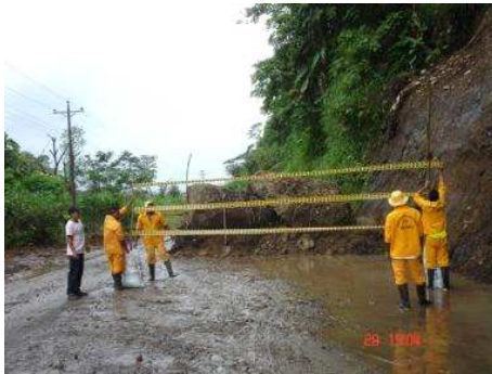
RUTA: 1001 TUMACO – JUNÍN PR 107+0000, 20 DE MAYO DE 2009 REMOCION DE DERRUMBE.
