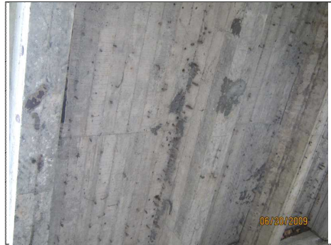
FOTO 10 LOSA Y VIGAS
