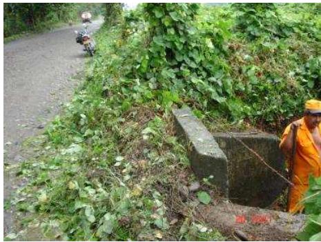
RUTA: 0501 ESPRIELLA - RIO MIRA - RIO MATAJE 1+0500, ABRIL 20 DE 2009 LIMPIEZA DE OBRAS
