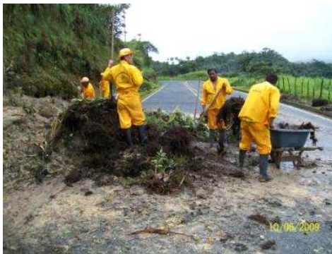
RUTA: 1001 TUMACO – JUNÍN PR 117+0700 JUNIO 10 DE 2009. REMOCIÓN DE DERRUMBES
