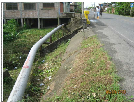
FOTO 5 TALUD IZQUIERDO EN ALETA No 1 LADO IZQUIERDO
