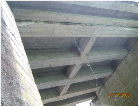
FOTO 9 LOSA Y VIGAS
