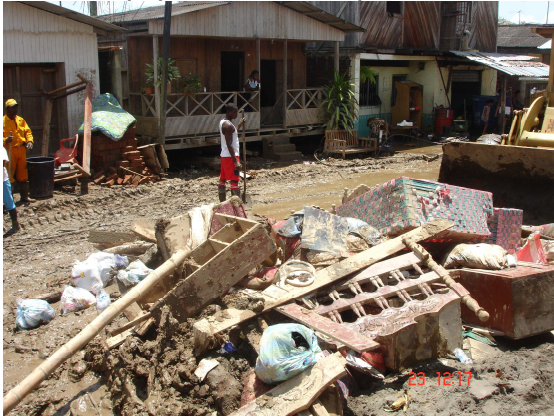
Fotografía 14. Remoción de escombros con equipo contratado por INVIAS.
