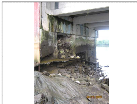
FOTO 6 VISTA ESTRIBO No 2
