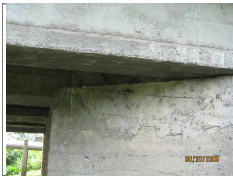
FOTO 11 APOYO EN ESTRIBO No 1
