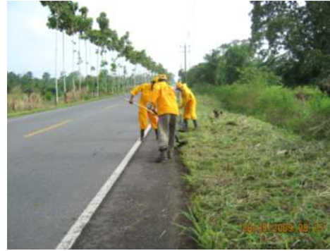
RUTA: 1001 TUMACO – JUNÍN PR 27+0000 MAYO 28 DE 2009. DESMONTE Y LIMPIEZA DE BERMAS.
