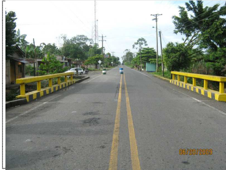
FOTO 1 SUPERFICIE DEL PUENTE Y ACCESO No. 2
