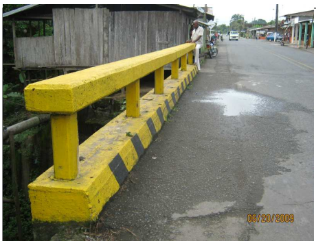
FOTO 3 BARANDA LADO IZQUIERDO Y SUPERFICIE DEL PUENTE
