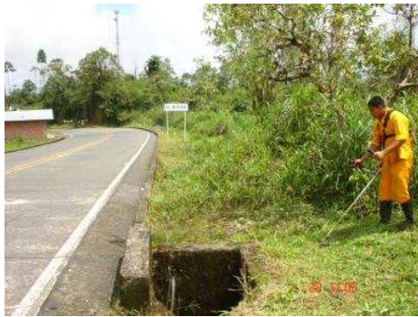
RUTA: 1001 TUMACO – JUNÍN PR 108+0900, ABRIL 22 DE 2009 ROCERIA EN OBRAS
