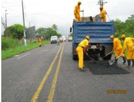
Fotografía 27. Bacheo Cooperativa el Mira Ltda. Sector la Carbonera
