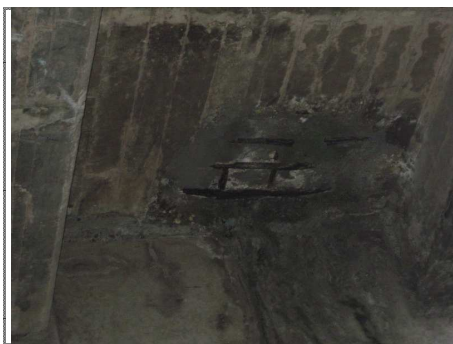
FOTO 5 VISTA INFERIOR DE LOSA
