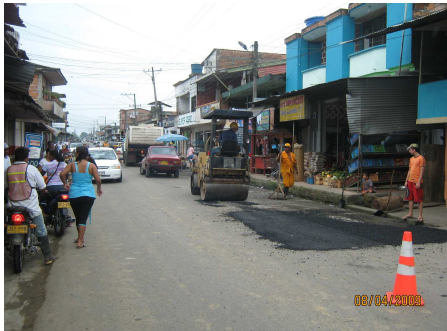
Fotografía 29. Bacheo Sector Llorente Ruta 1001. Cooperativa Nueva Unión Ltda.
