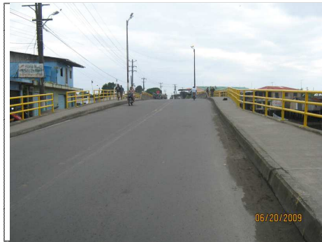
FOTO 2 SUPERFICIE DEL PUENTE, ACCESO No. 2 Y ANDEN IZQUIERDO
