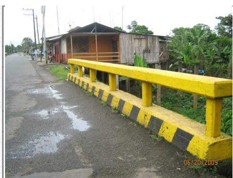
FOTO 4 BARANDA LADO DERECHO Y SUPERFICIE DEL PUENTE
