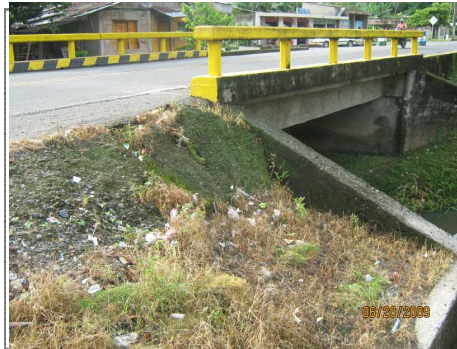
FOTO 3 BARANDAS Y CONO No. 2 DERECHO
