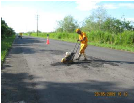
RUTA: 1001 TUMACO – JUNÍN PR 13+0000 MAYO 29 DE 2009. PARCHEO CON MEZCLA DENSA EN CALIENTE
