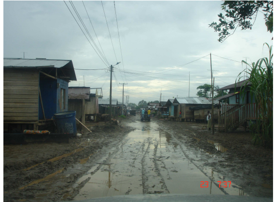
Fotografía 15. Resultado final después de la remoción de escombros.
