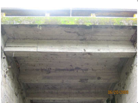
FOTO 9 LOSA Y VIGAS
