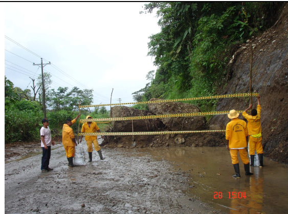
Fotografía 4. Demarcación del área afectada
