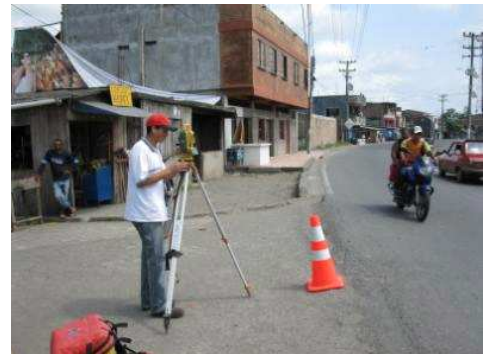
RUTA: 1001 TUMACO – JUNÍN SUPERVISIÓN EN ESTUDIOS PUENTE EL PINDO - TOMA DE TOPOGRAFÍA
