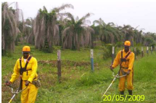
RUTA: 1001 TUMACO – JUNÍN MAYO 20 DE 2009. ROCERIA CON EL USO ADECUADO DE LOS IMPLEMENTOS DE SEGURIDAD INDUSTRIAL
