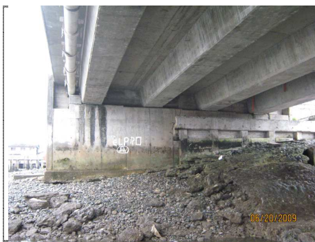
FOTO 3 VISTA INFERIOR DE LOSA Y ESTRIBO No. 1
