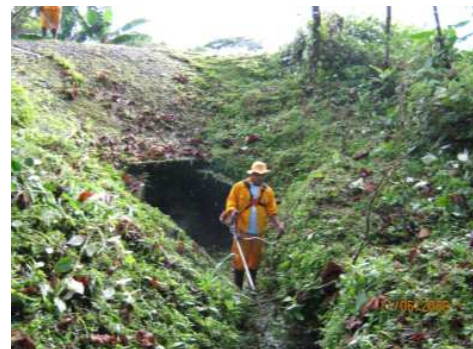
RUTA: 1001 TUMACO – JUNÍN PR 85+0500, JUNIO 11 DE 2009 SUPERVISIÓN EN ROCERÍA DE OBRAS.
