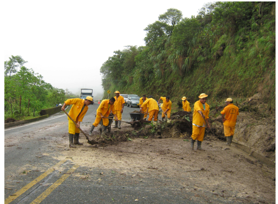
Fotografía 9. Remoción de derrumbe con herramienta menor
