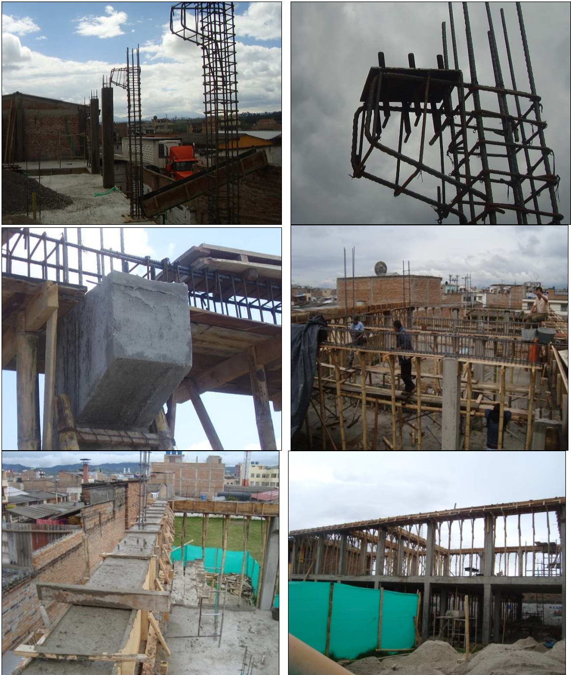
Figura 24. Columnas y Vigas Aéreas del Segundo Piso.
