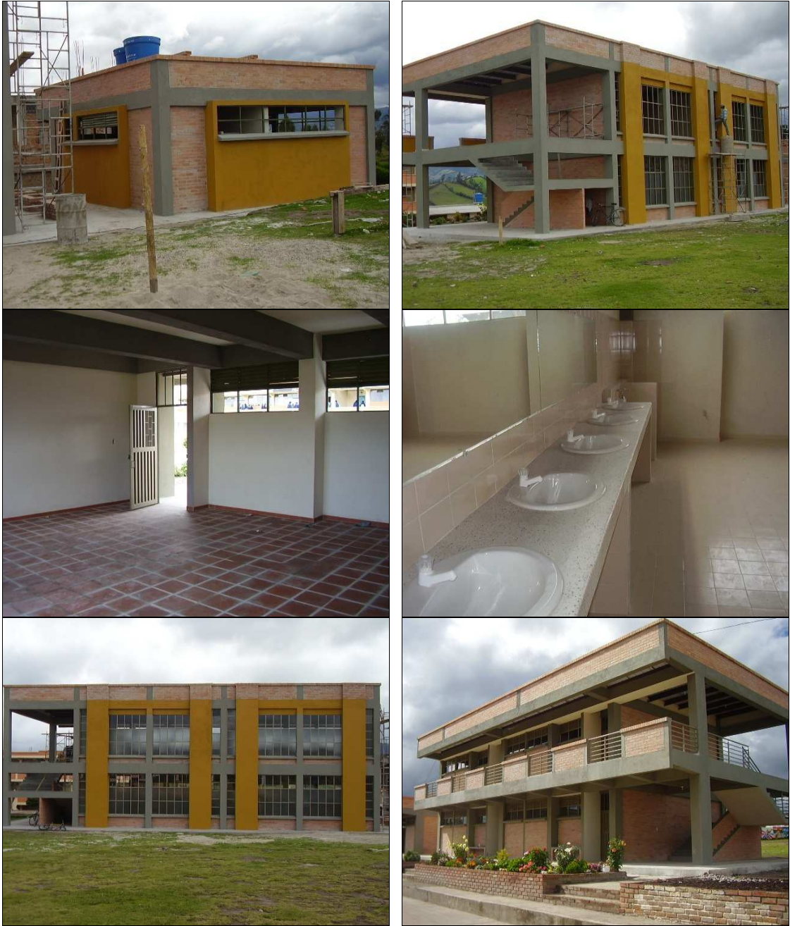
Figura 20. Pintura y aseo.
