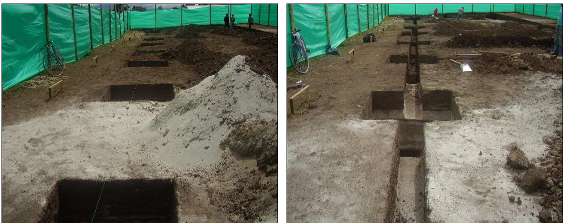
Figura 2. Excavación manual para cimientos.
