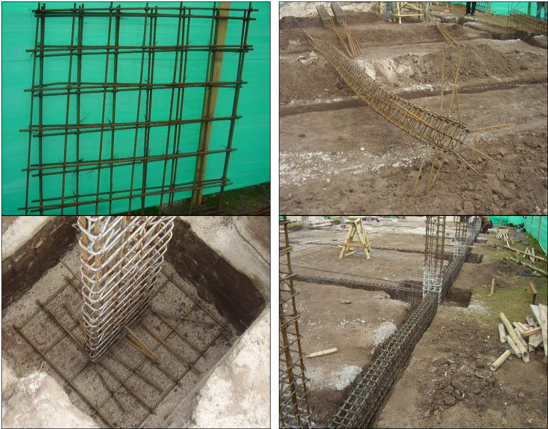
Figura 5. Figuración y colocación de acero de refuerzo.
