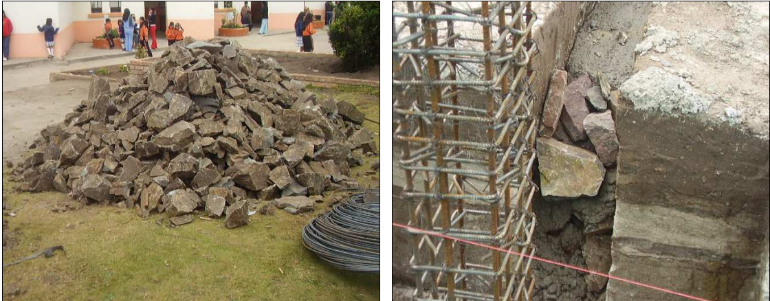
Figura 4. Concreto ciclópeo para cimientos.
