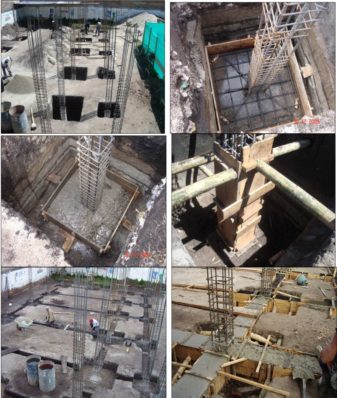
Figura 22. Ejecución de Zapatas y Vigas de Cimentación.
