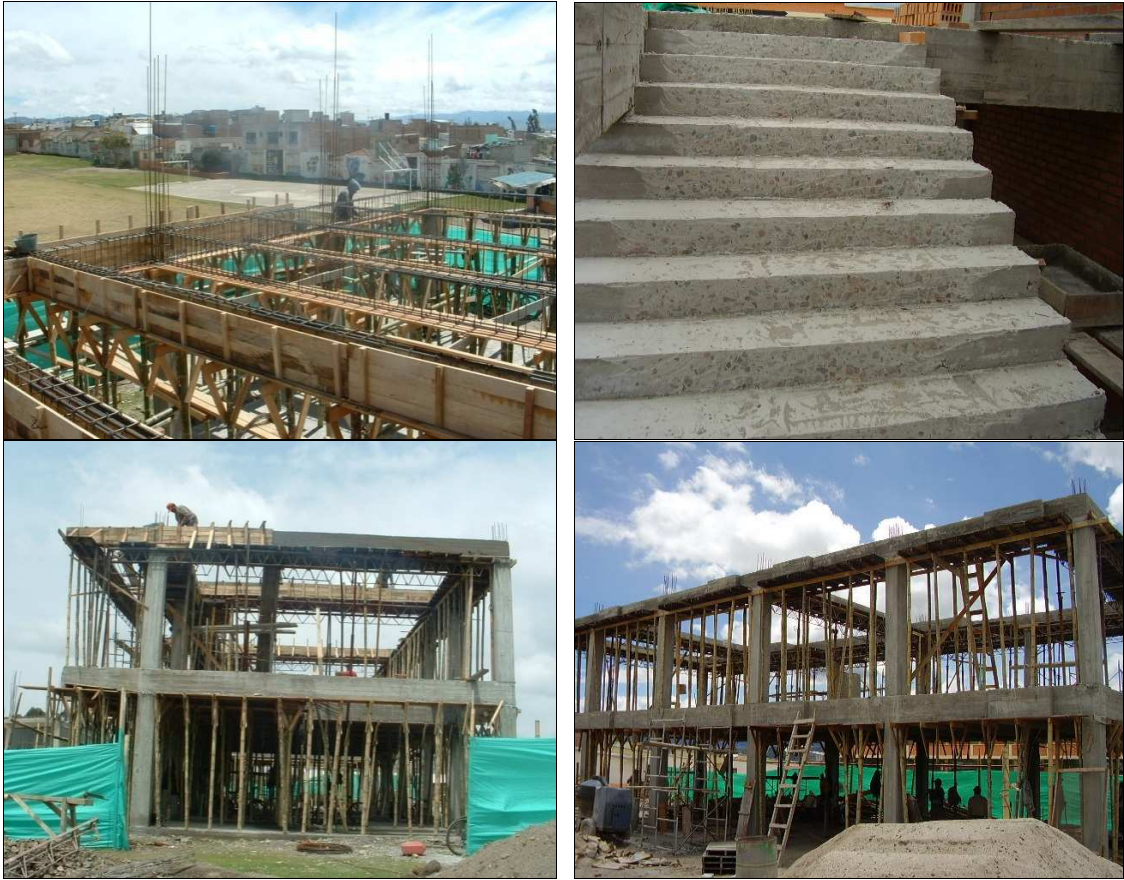
Figura 11. Columnas 2do Piso, Vigas de Cubierta y Escaleras.
