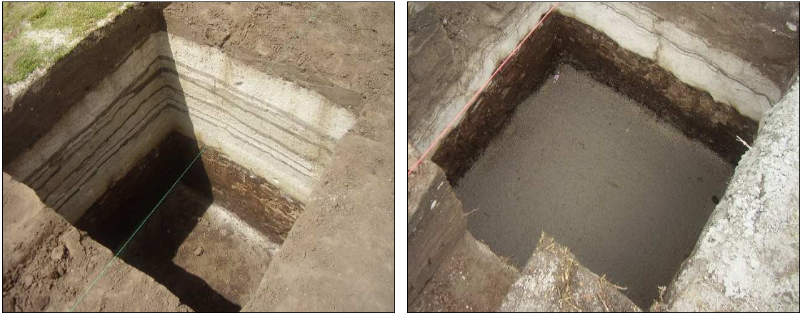
Figura 3. Concreto pobre de limpieza.
