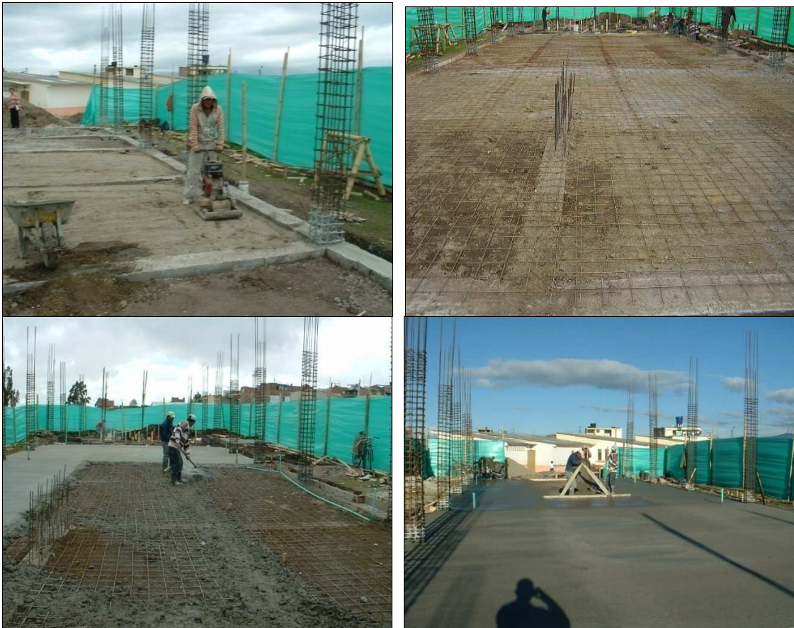
Figura 7. Placa de contrapiso.
