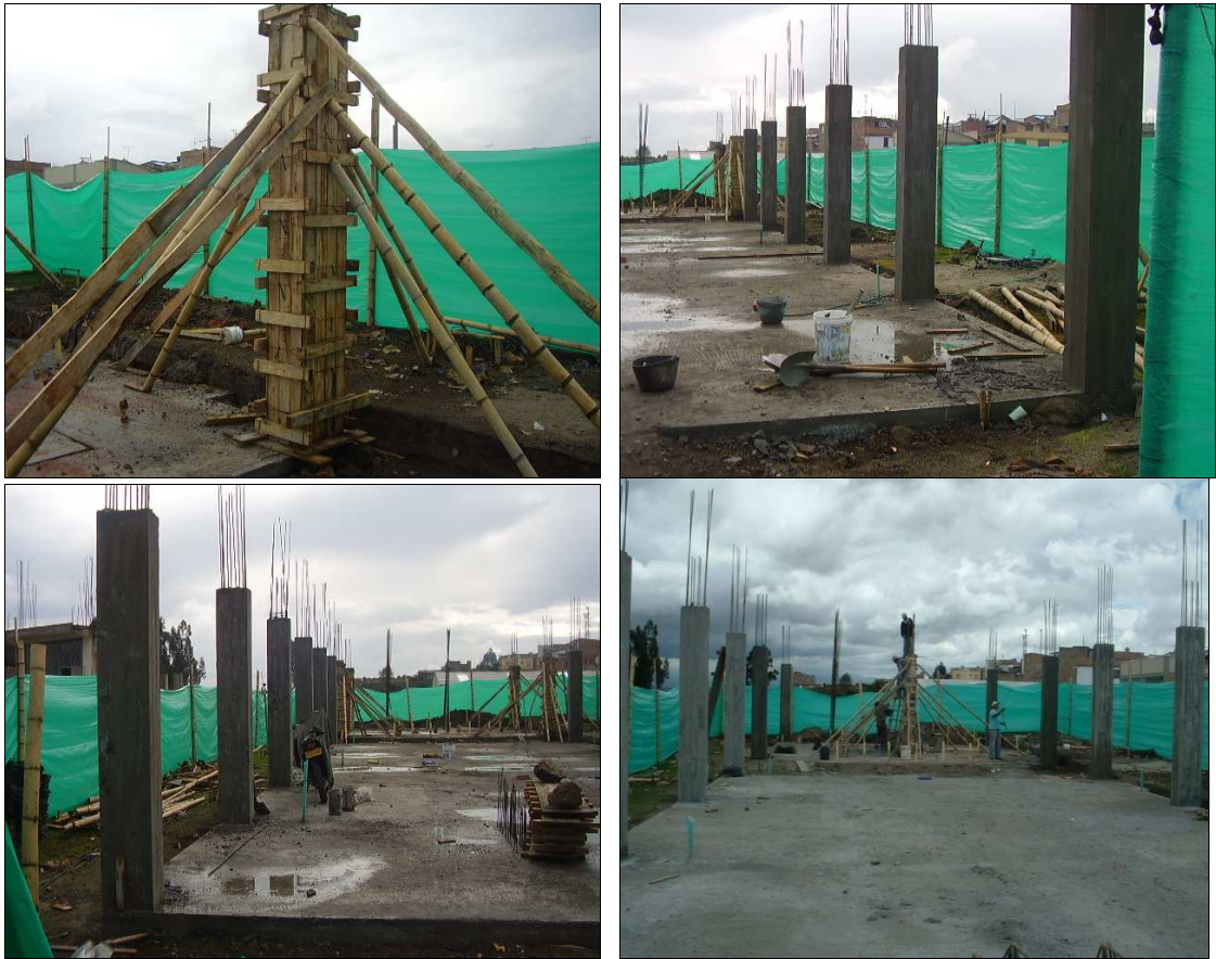
Figura 9. Columnas en concreto reforzado a la vista.
