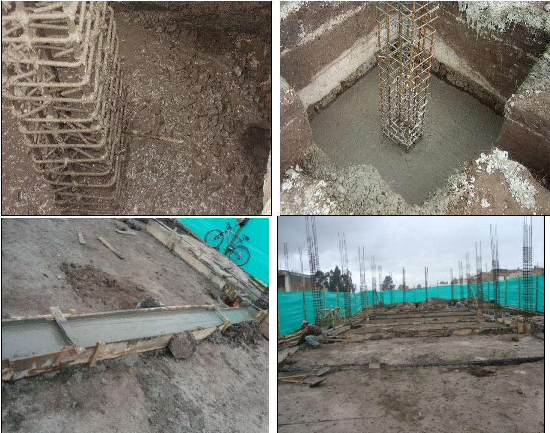
Figura 6. Concreto reforzado de 3000 psi.
