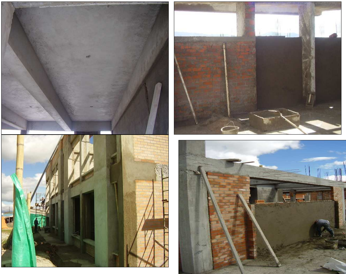
Figura 17. Pañetes interiores y exteriores.
