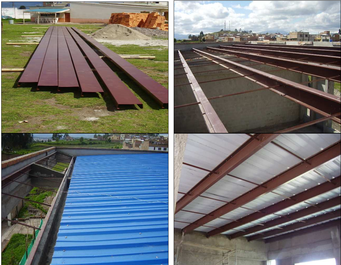
Figura 13. Estructura metálica para cubierta.
