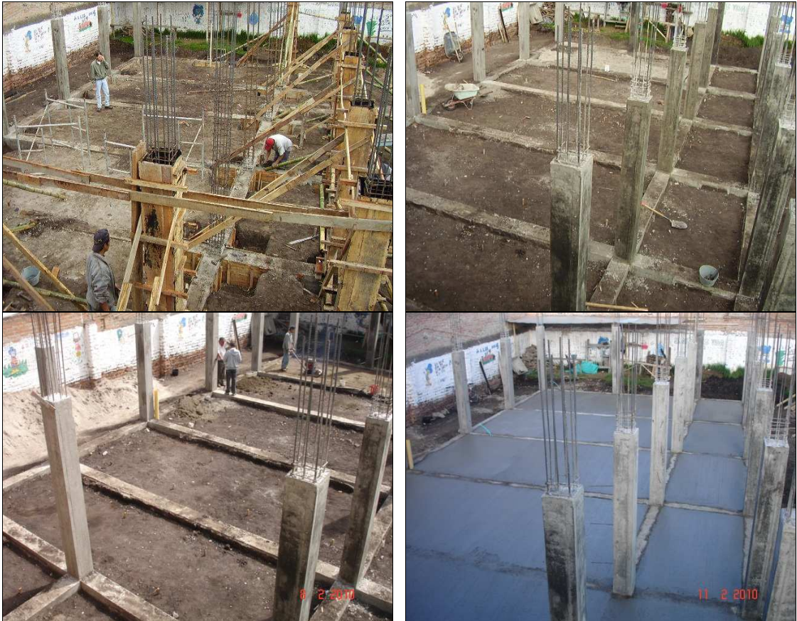
Figura N°22 Columnas y Placa de Contrapiso.
