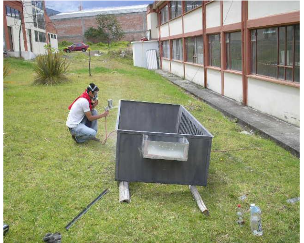
Figura 29 aplicación de anticorrosivo
