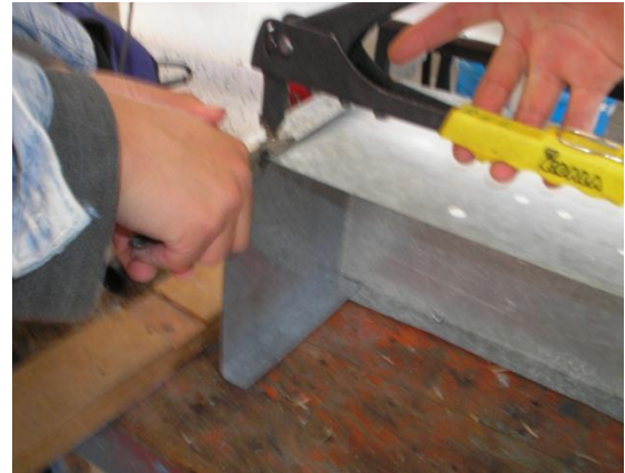
Figura 25 remachado de canaleta
