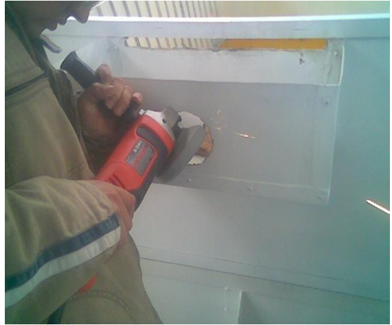
Figura 32 abertura salida de la canaleta
