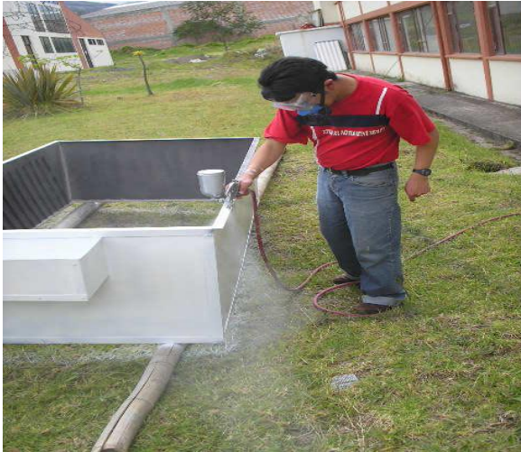
Figura 28 aplicación de pintura
