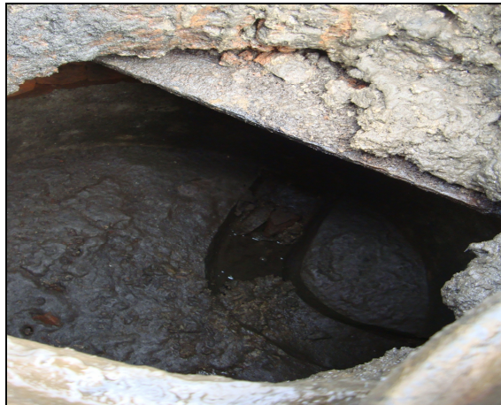
Figura 2. Estado actual cámara de alcantarillado.
