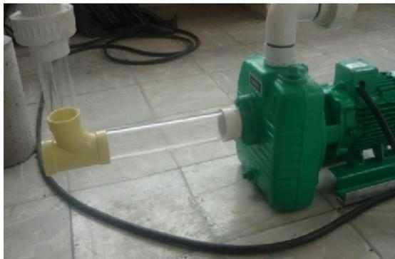
La bomba cuenta con su correspondiente sistema de conexión eléctrica debidamente instalado y protegido según las normas de seguridad, su encendido se hace de manera manual desde un tablero de control en donde se encuentra el arrancador eléctrico, y el toma de conexión, se usa cable de alta tensión debido a la complejidad del montaje y a la capacidad del equipo pues se cuenta con un motor trifásico.
