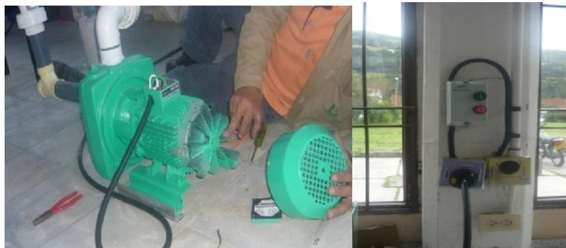
La bomba se calibra, verificando el sentido de giro de su motor, garantizando que la corriente que recibe sea la adecuada, verificando su aislamiento y protección, optimizando así su funcionamiento.
