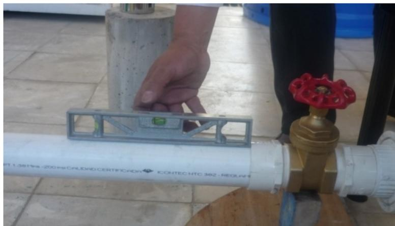
Los accesorios y tubería se aseguran a las estructuras de soporte del montaje para evitar fallas en los componentes debido al movimiento y la fricción causada por el trabajo de las mismas, se usa materiales de madera y metálicos para dar soporte a la sección en referencia, se implementa el uso de abrazaderas elaboradas en las medidas necesarias para garantizar la unión adecuada del elemento. Este proceso finalizado se puede observar como un ejemplo en la figura 54.
