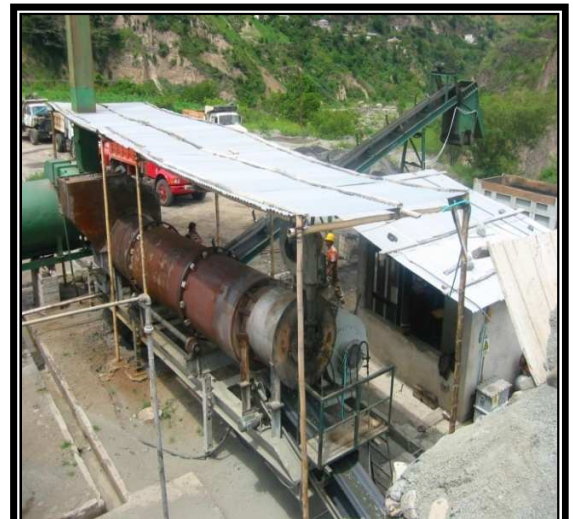
Imagen 4. Cubierta tambor s.
