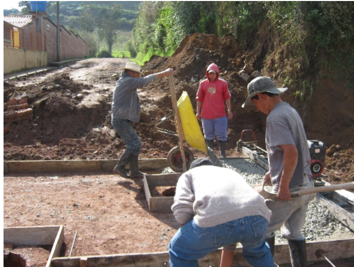
Figura 22. Colocación del concreto y uso de vibrador
