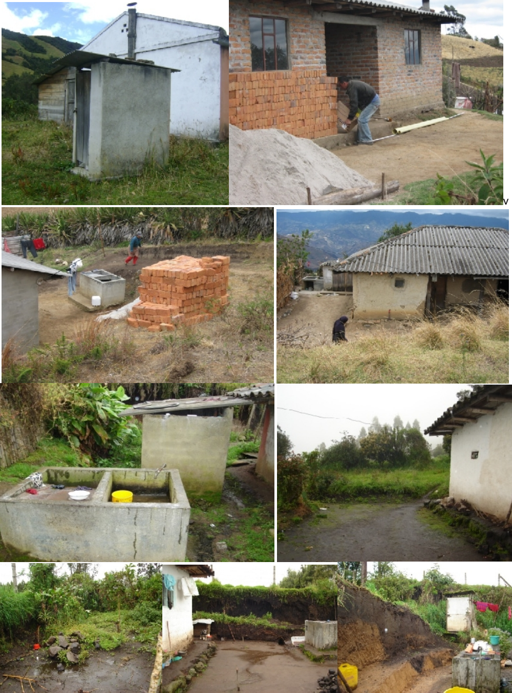
Figura 49. Estado de algunas viviendas beneficiadas
