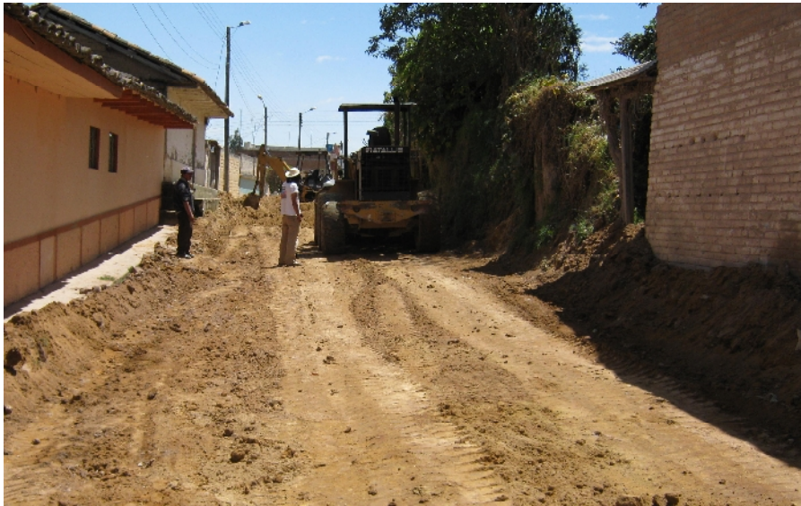
Figura 13. Nivelación de subrasante
