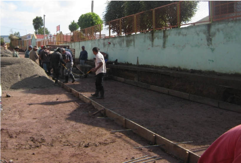
Figura 24. Adecuación final de base
