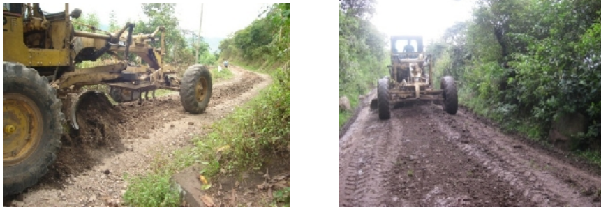
Figura 39. Nivelación y perfilado
