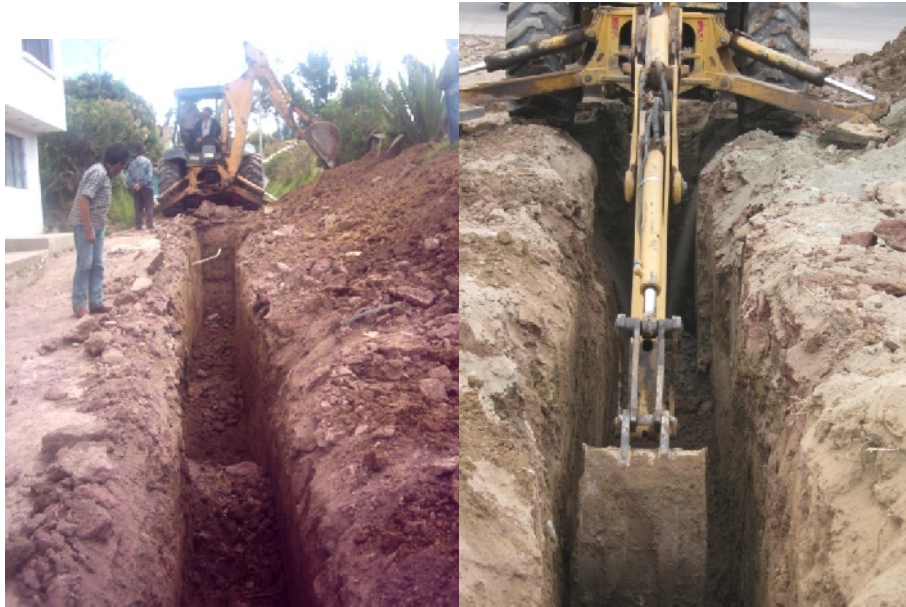
Figura 65. Excavación con retroexcavadora
