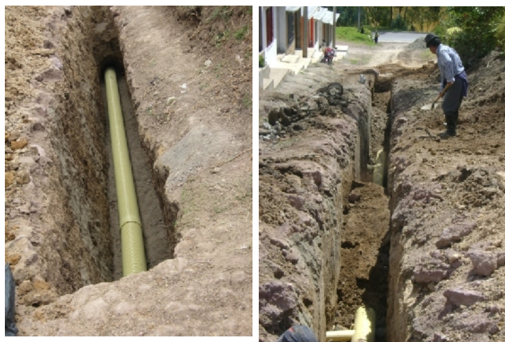
Figura 71. Instalación de Tubería corrugada
