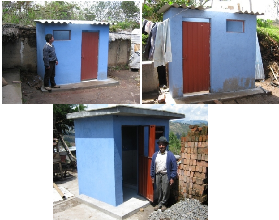
Figura 62. Unidad sanitaria terminada
