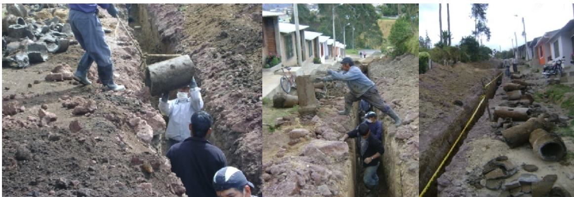
Figura 69. Retiro de tubería desgastada
