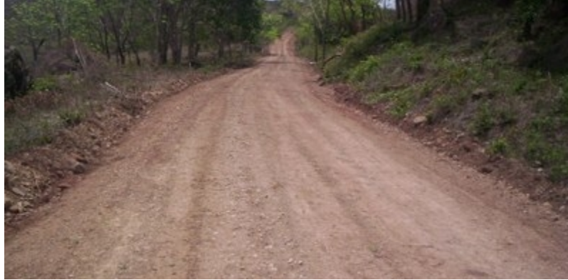
Figura 46. Estado final de la vía
