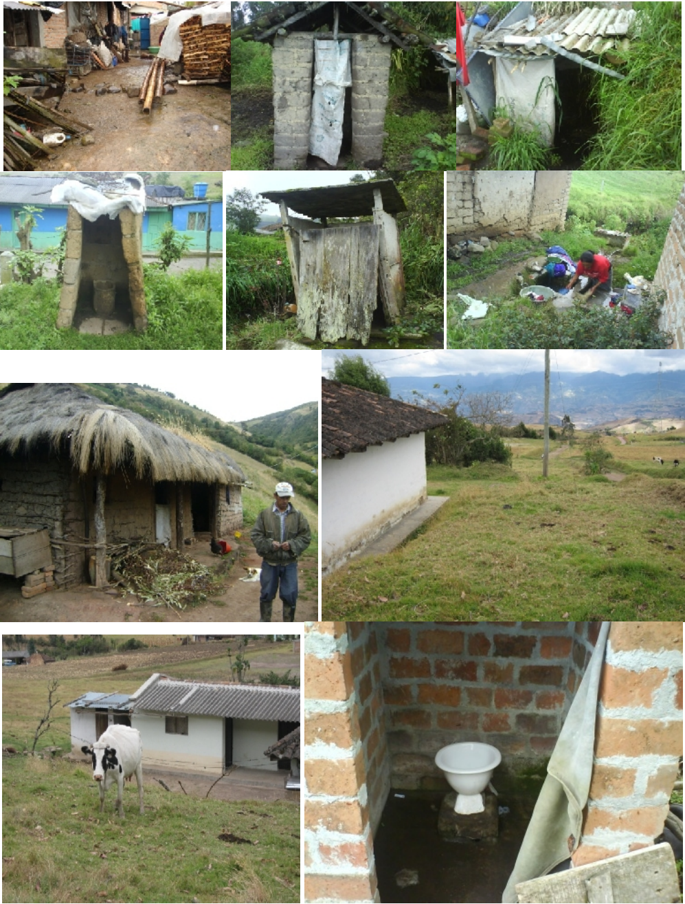
Figura 50. Estado de algunas viviendas beneficiadas
