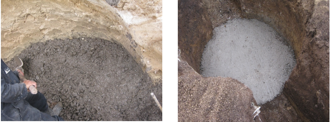
Figura 9. Fundicion solado camara de inspeccion
