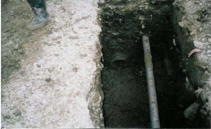
Figura 19. Base en concreto sumidero
