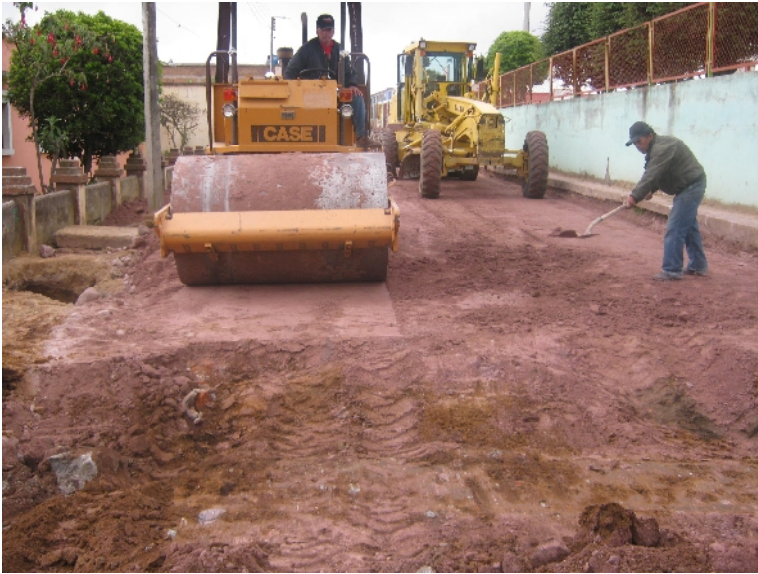
Figura 17. Compactación de base
