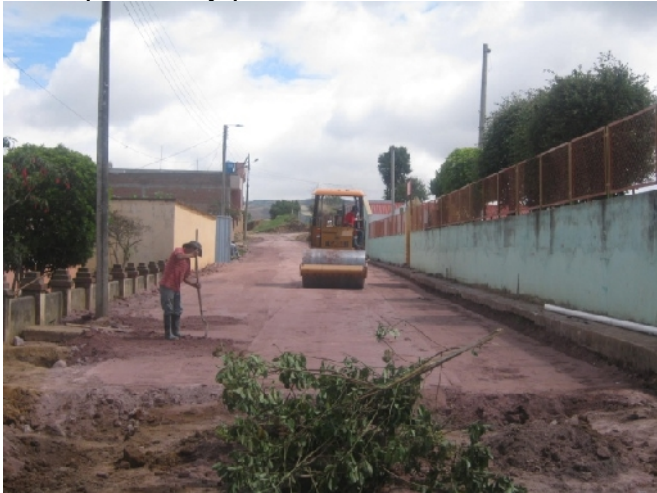
Figura 18. Material Compactado y perfilado
