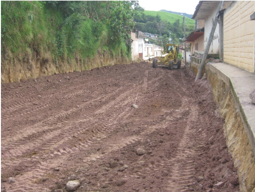
Figura 15. Tendido de material para base
