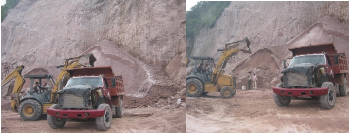
Figura 33. Cargue de material
