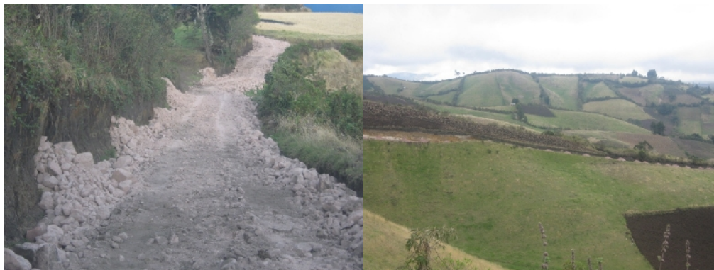
Figura 35. Acordonamiento de material Vía San Vicente-San Antonio.
