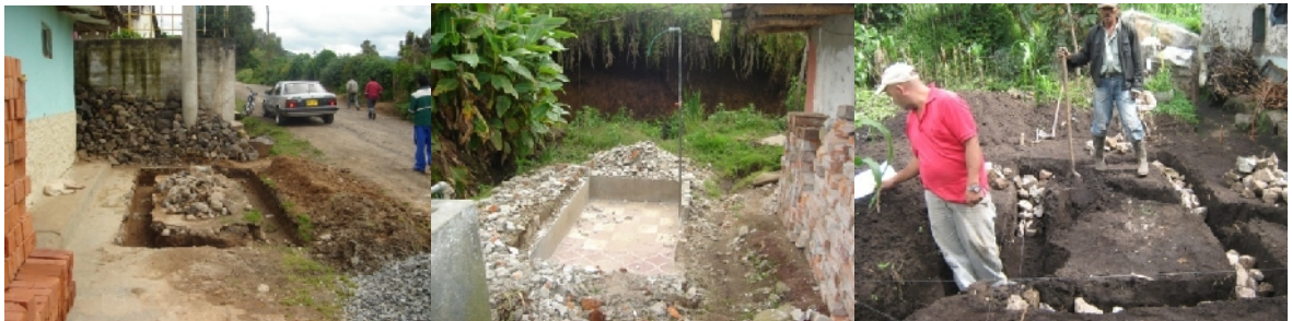
Figura 52. Excavación y desalojo de material
