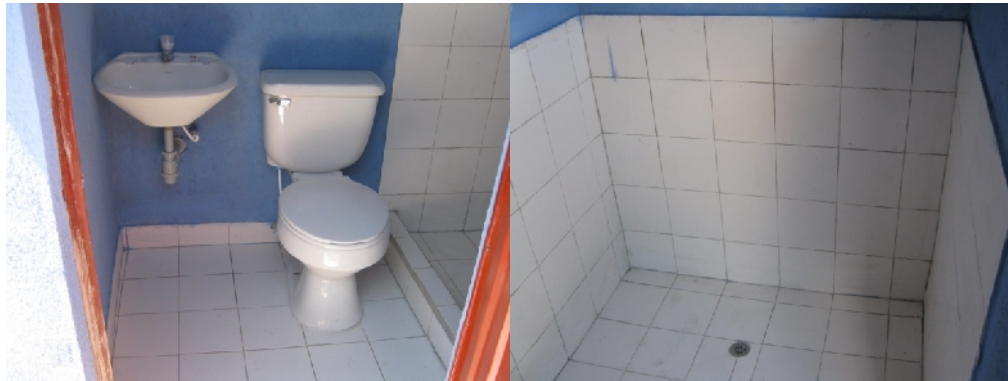
Figura 61. Enchape y acabados
