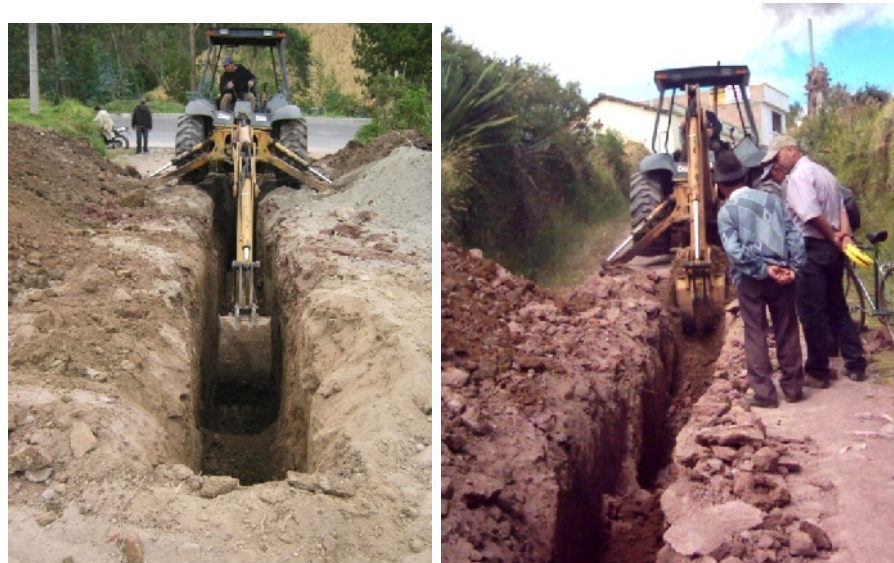
Figura 64. Excavación con retroexcavadora
