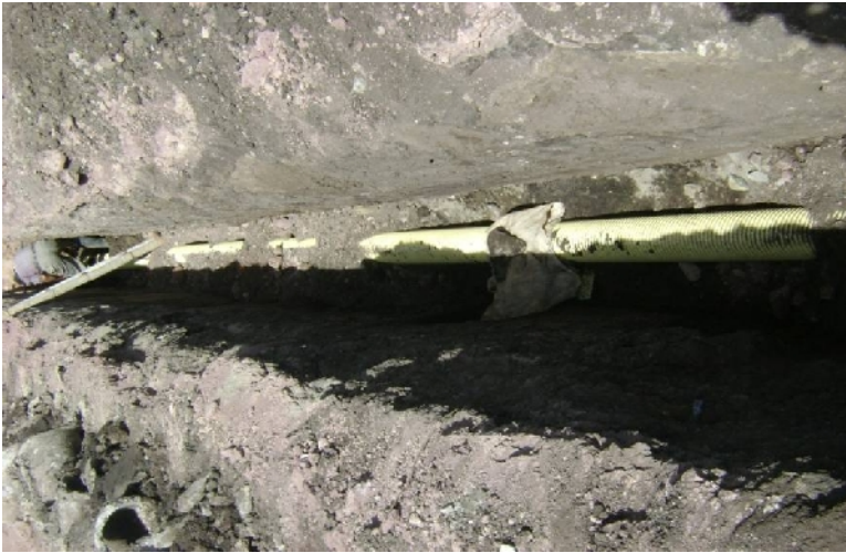
Figura 72. Instalación de Tubería corrugada
