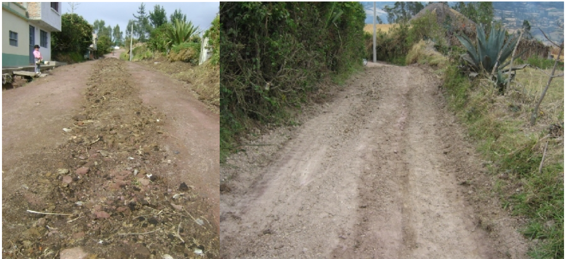
Figura 76. Estado final de la vía
