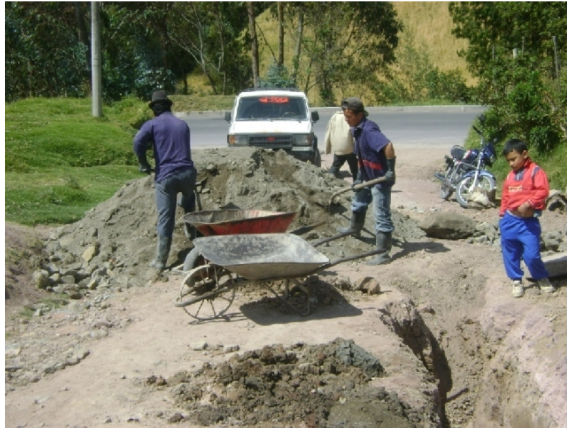
Figura 70. Recebo para base de colocacion de tuberia
