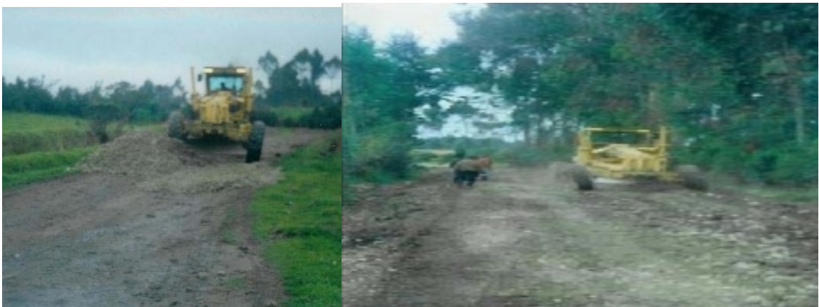
Figura 39. Tendido de material
