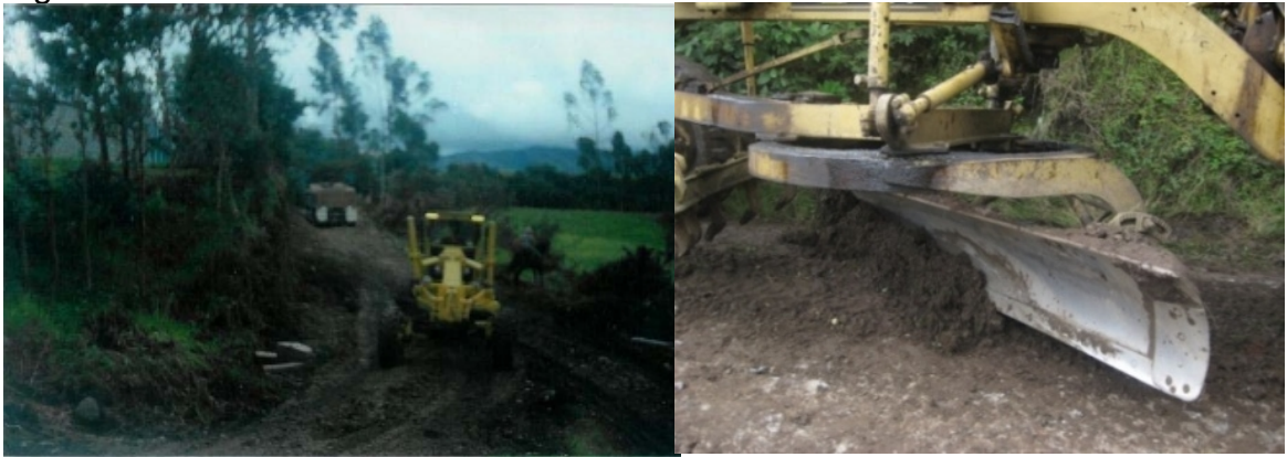
Figura 38. Tendido de material
