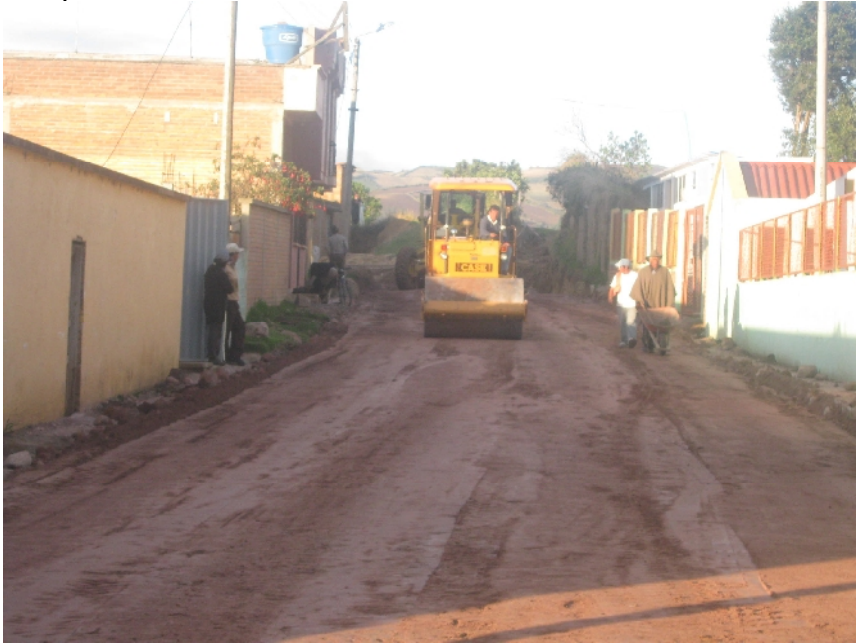
Figura 16. Compactación de base
