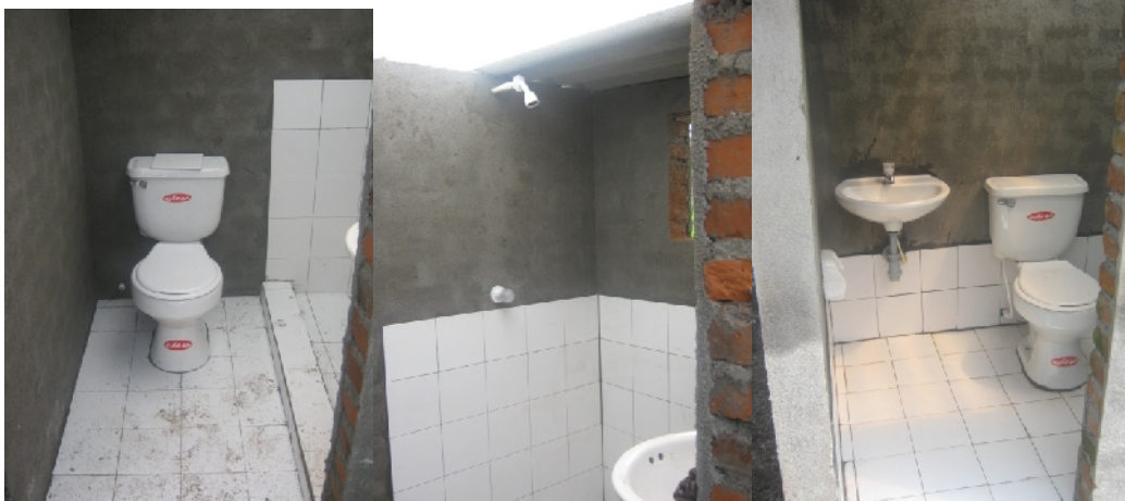
Figura 60. Enchape y acabados
