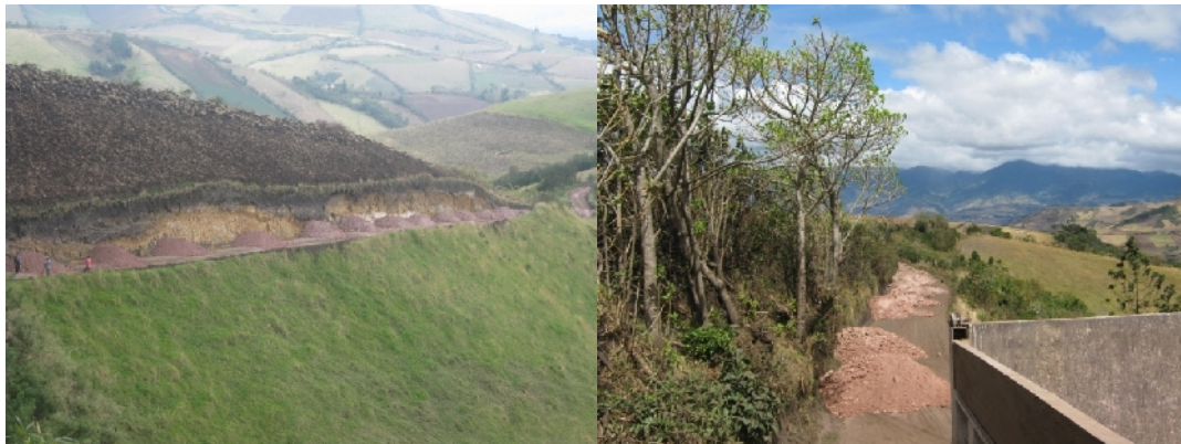
Figura 34. Acordonamiento de material Vía San Vicente-San Antonio.
