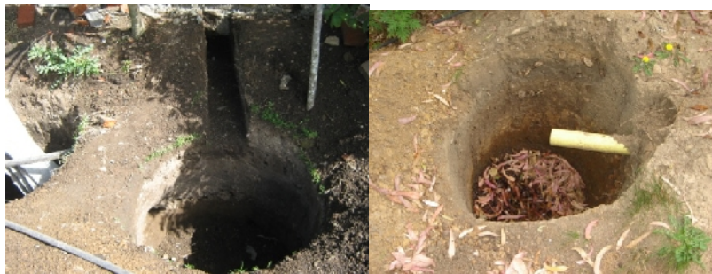
Figura 63. Excavación Pozo séptico.
