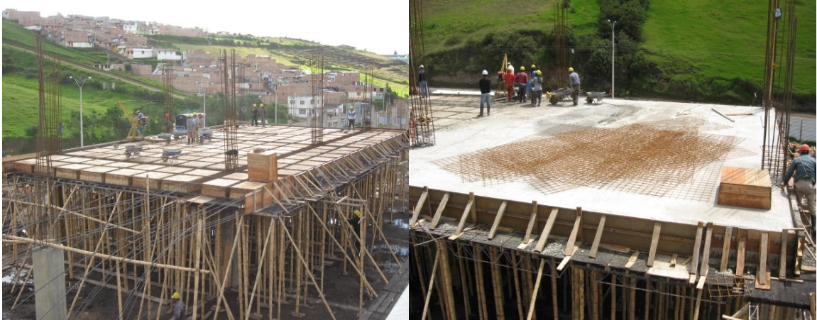
Fotografías N° 40 y 41. Losa entrepiso bloque 3 entre ejes 9' y 11
