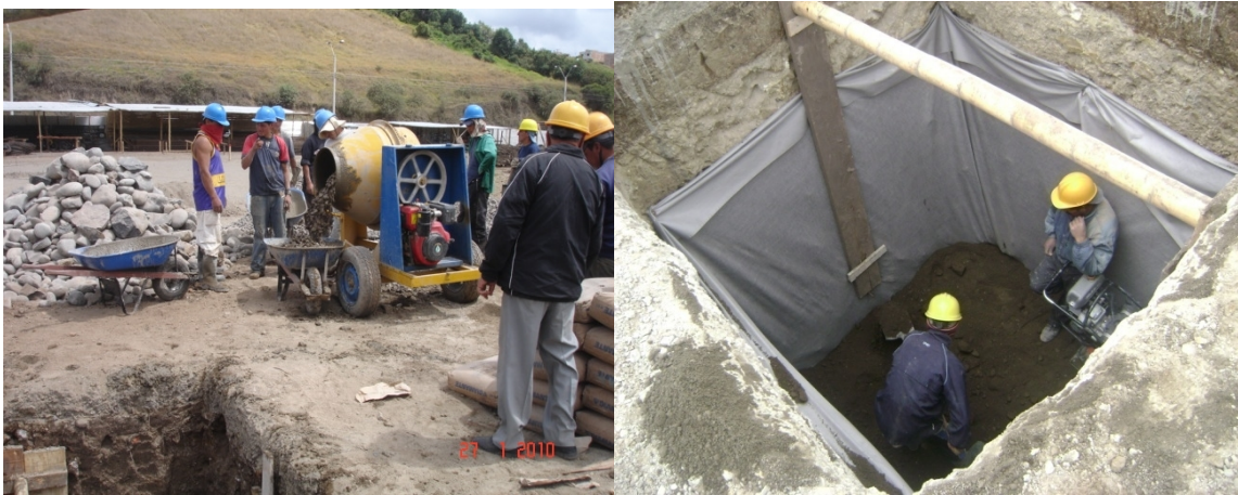
Fotografías 26 y 27. Concreto ciclópeo, geotextil, mejoramiento de trinchera y compactación.
