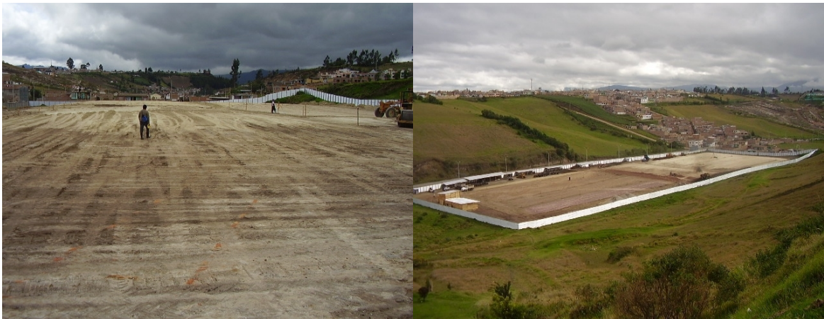
Fotografías Nº 13 y 14. Nivelación y compactación.
