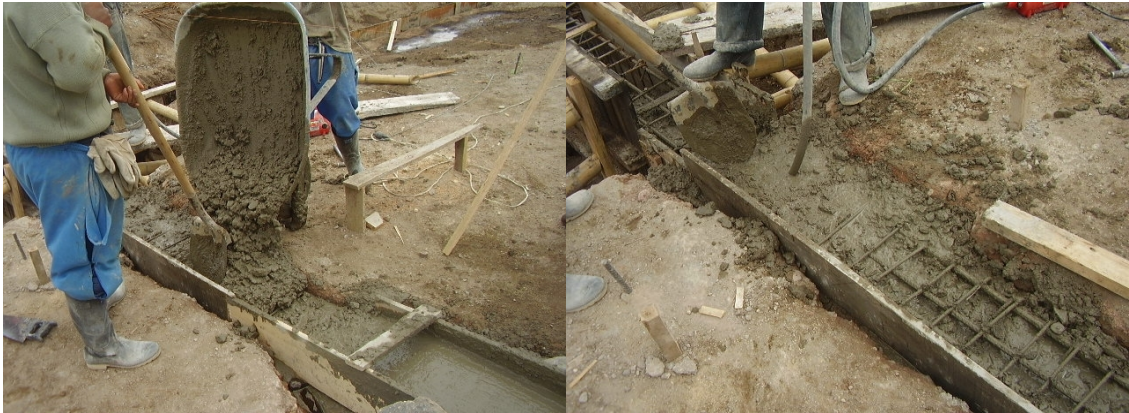
Fotografías 54 y 55. Vaciado y vibración del concreto.
