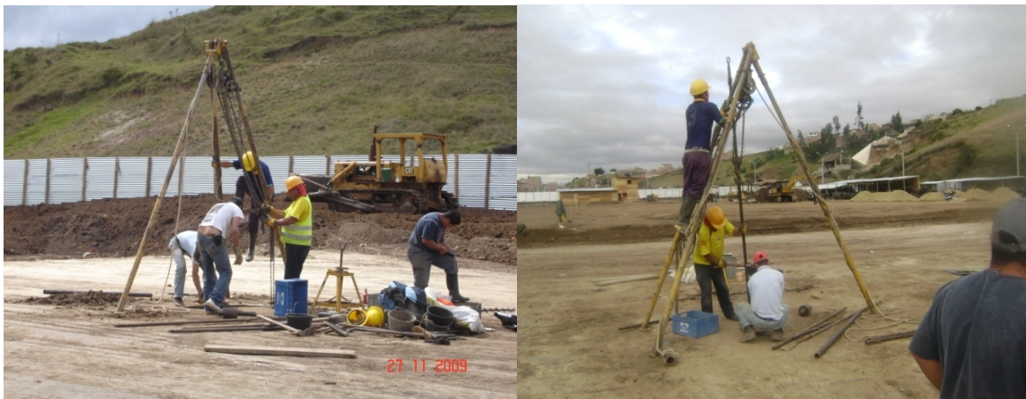
Fotografías 21 y 22. Apiques.
