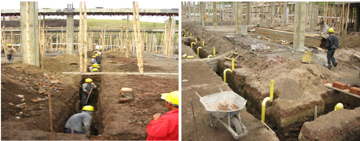
Fotografías 46 y 47. Excavaciones, batería sanitaria eje G entre 15 y 16, cajilla de inspección, instalaciones tubería pvc sanitaria 4"
