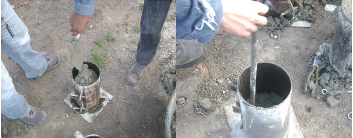
Fotografía 62 y 63. Toma de cilindros.
