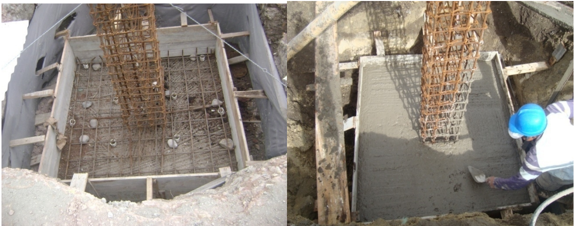
Fotografía 28 y 29. Mejoramiento en suelo cemento a nivel de desplante, parrilla zapata sobre concreto de limpieza, columna armada lista para izarse, zapata fundida en concreto de 3000 psi
