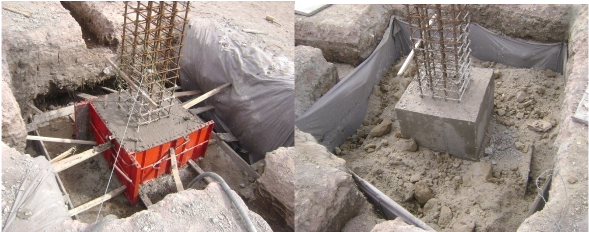
Fotografías 30 y 31. Formaleta pedestal y fundición.
