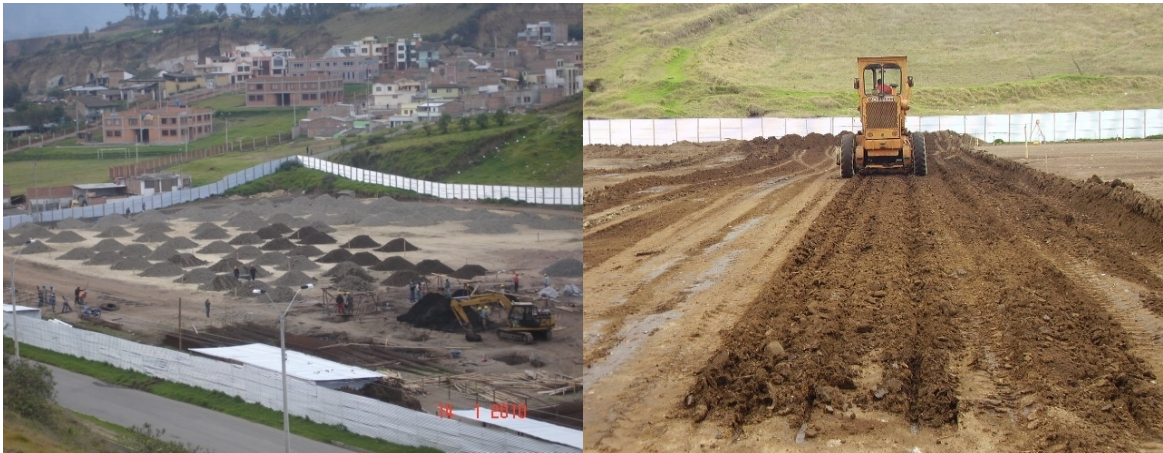
Fotografías Nº 11 y 12. Acopio de Material y Extendido.
