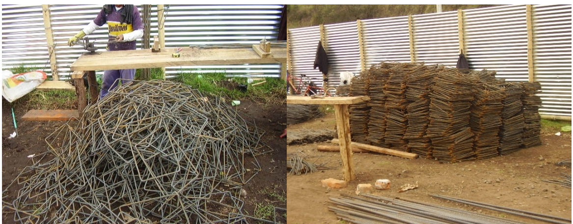
Fotografías 19 y 20. Almacenamiento, corte, figuración y doblado de acero.
