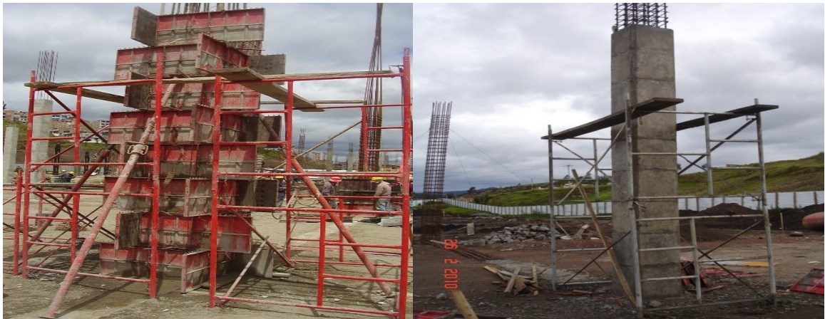
Fotografías 34 y 35. Columnas: formaleta y fundición.
