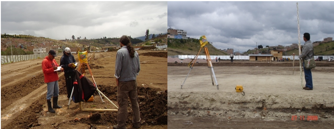
Fotografías N° 5 y 6. Equipo de Topografía para trabajos de localización y replanteo
