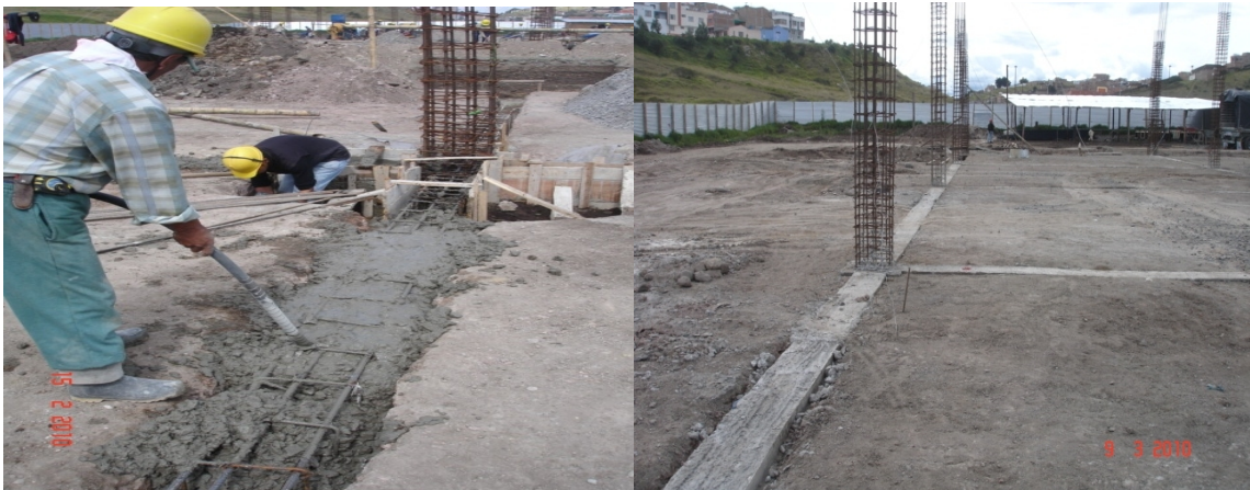
Fotografías N° 32 y 33. Vigas de Piso: Excavación, solado, armado y fundición
