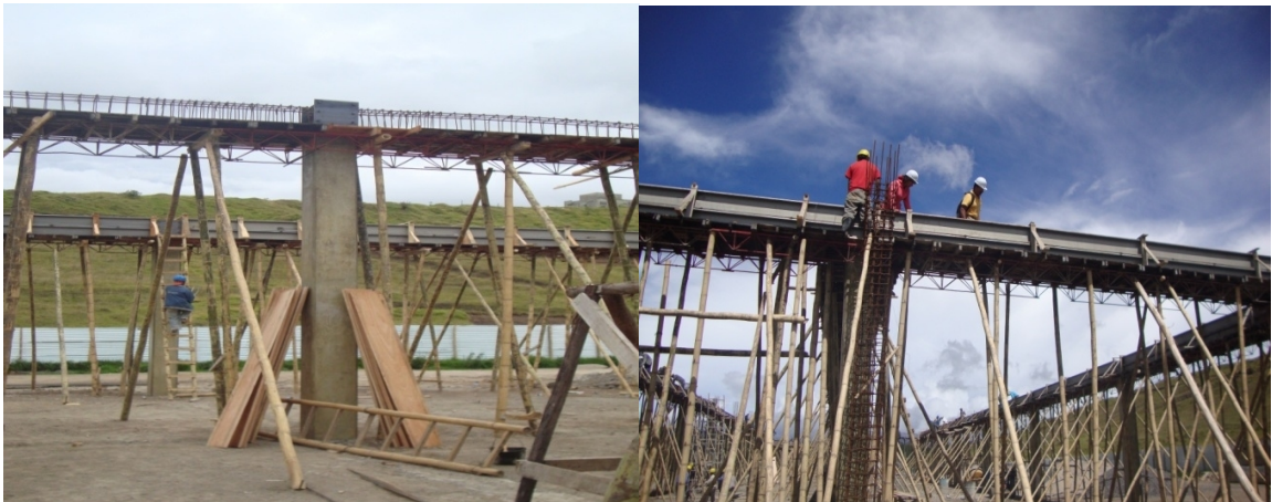
Fotografías 36 y 37. Vigas aéreas: formaleta, espacio de trabajo,
