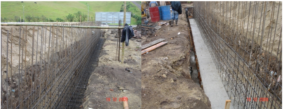
Fotografías Nº 17 y 18. Construcción muro de contención
