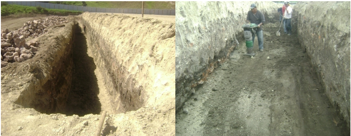
Fotografías 15 y 16. Excavación y compactación base de la zarpa del muro.
