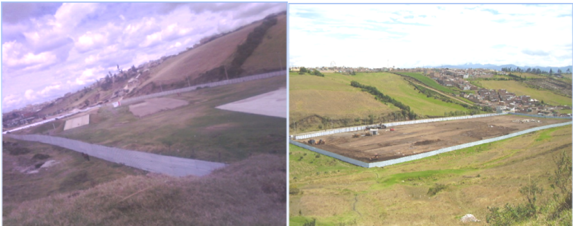
Fotografías 1 y 2. Cerramiento lámina de zinc
