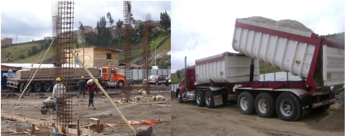
Fotografías 48 y 49. Disposición de cemento, arena
