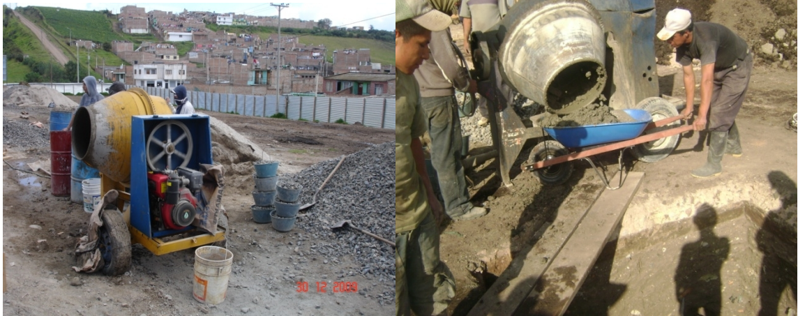
Fotografías 52 y 53. Mezcladora en funcionamiento.
