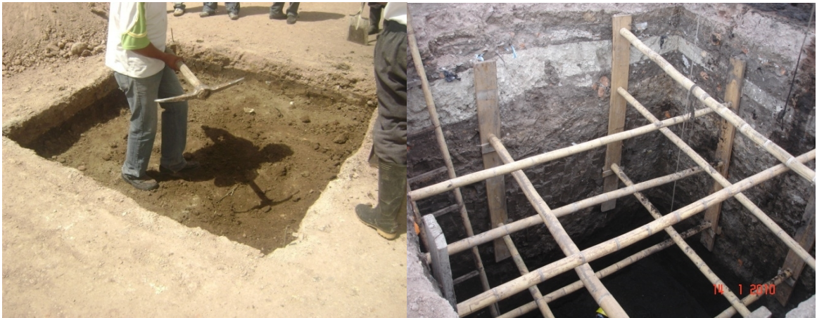
Fotografías 23 y 24. Excavaciones, entibado y listo para concreto ciclópeo.
