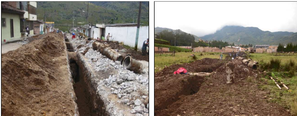
Foto 35. Retiro de tubería existente
