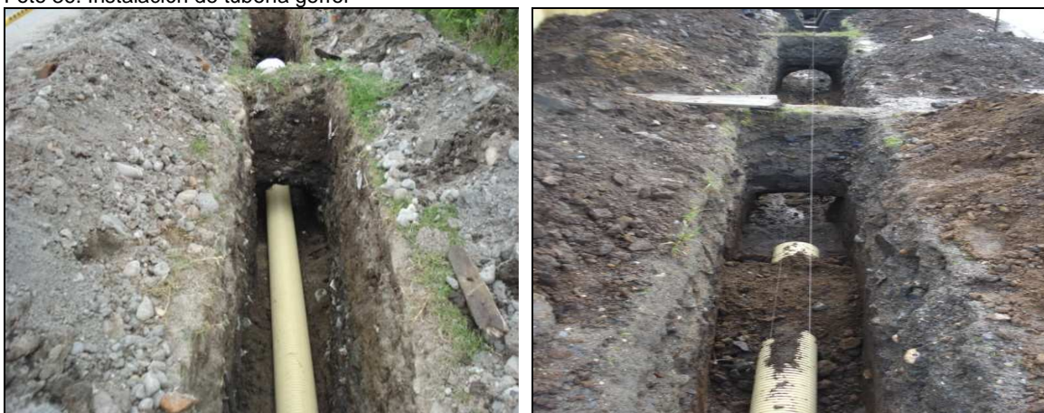
Foto 36. Instalación de tubería gerfor
