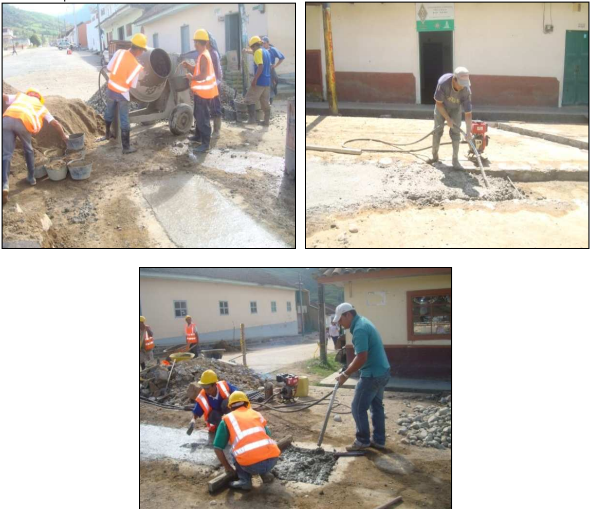
Foto 39. Reposición de concreto hidráulico
