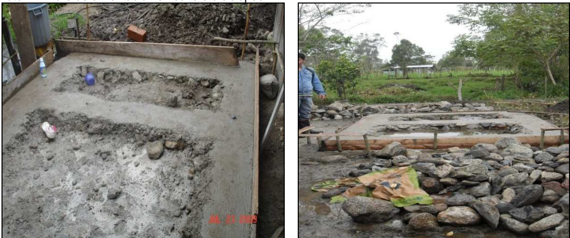
Foto 21. Muro de cimentación en concreto ciclópeo
