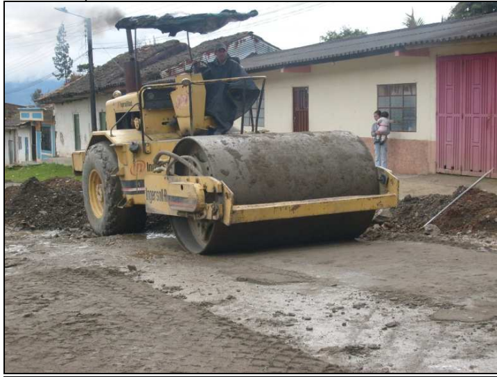
Foto 6.compactacion material de sub-base
