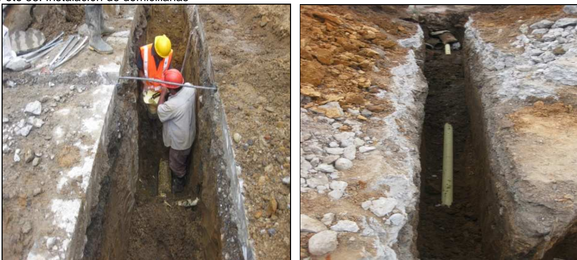
Foto 38. Instalación de domiciliarias
