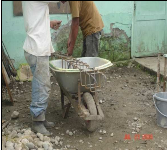
Foto 24. Acero de refuerzo para columna
