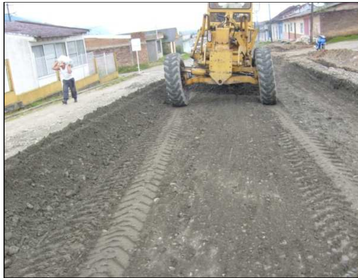
Foto 5. Extendido material de sub-base
