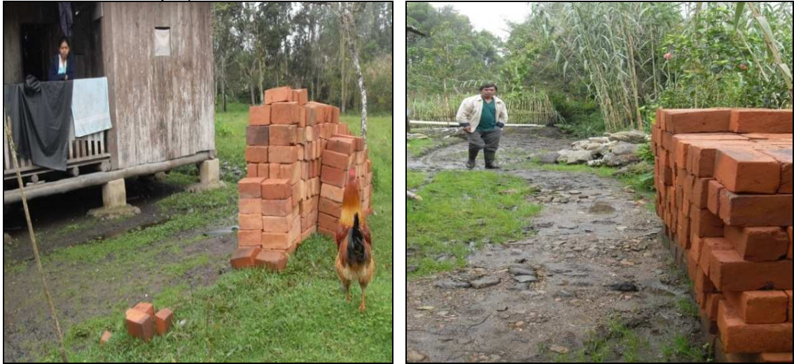
Foto 20. Localización y replanteo, suministro de material
