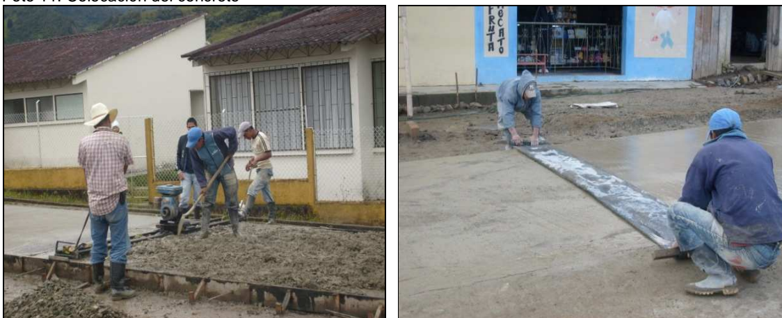
Foto 11. Colocación del concreto
