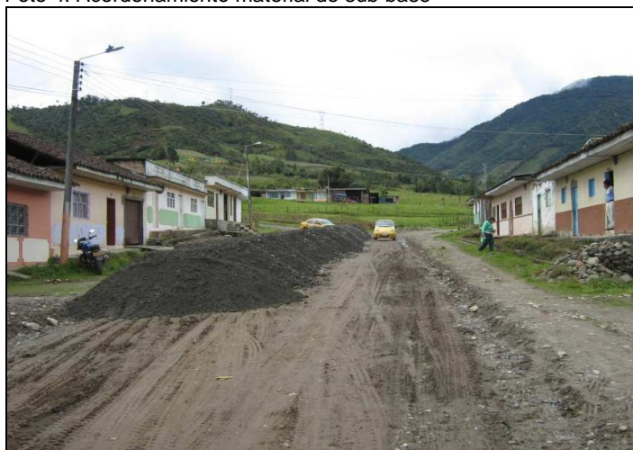
Foto 4. Acordonamiento material de sub base
