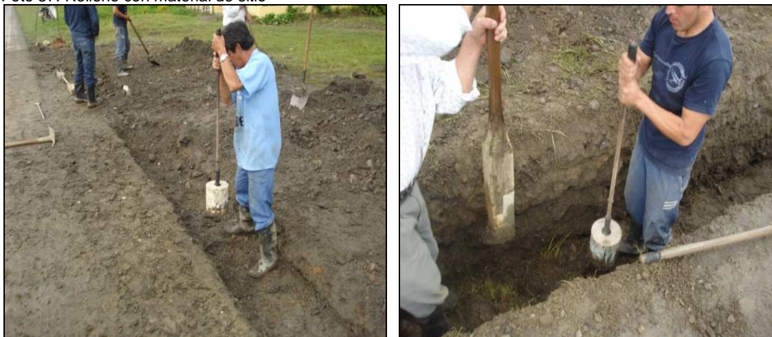
Foto 37. Relleno con material de sitio
