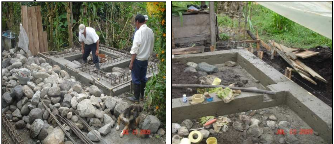
Foto 23. Viga de cimentación
