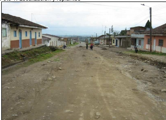
Foto 1. Localización y replanteo
