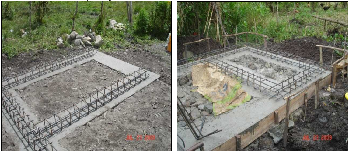
Foto 22. Acero de refuerzo para viga de cimentación
