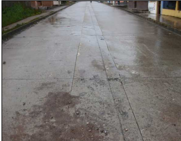
Foto 32. Corte de pavimento
