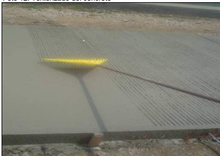
Foto 12. Texturizado del concreto
