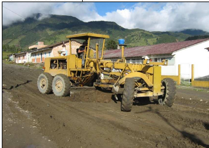
Foto 2. Excavación a máquina
