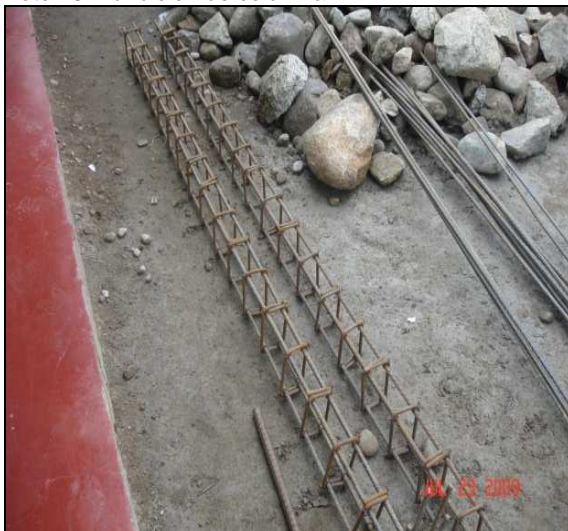
Foto 25. Fundición de columna
