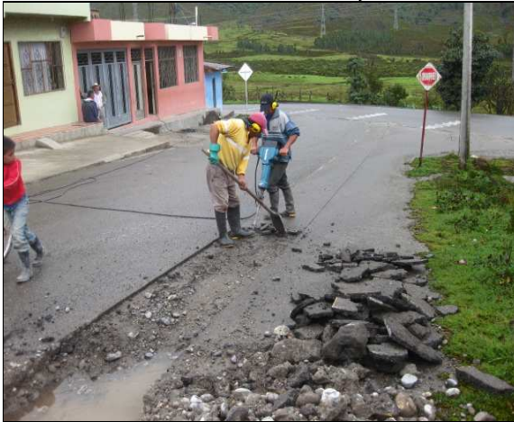
Foto 33. Retiro de concreto hidráulico y asfáltico
