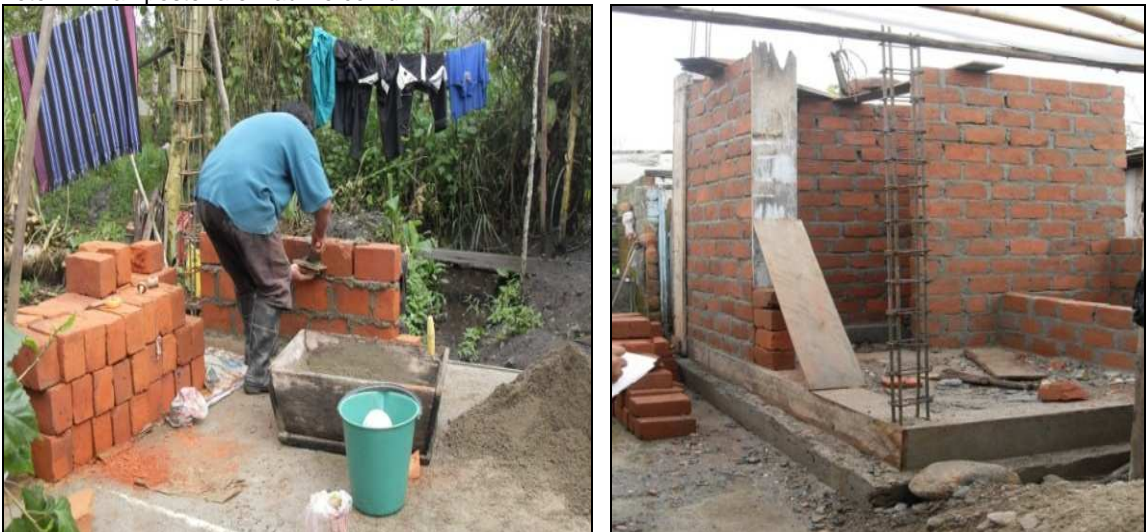
Foto 27. Mampostería en ladrillo común
