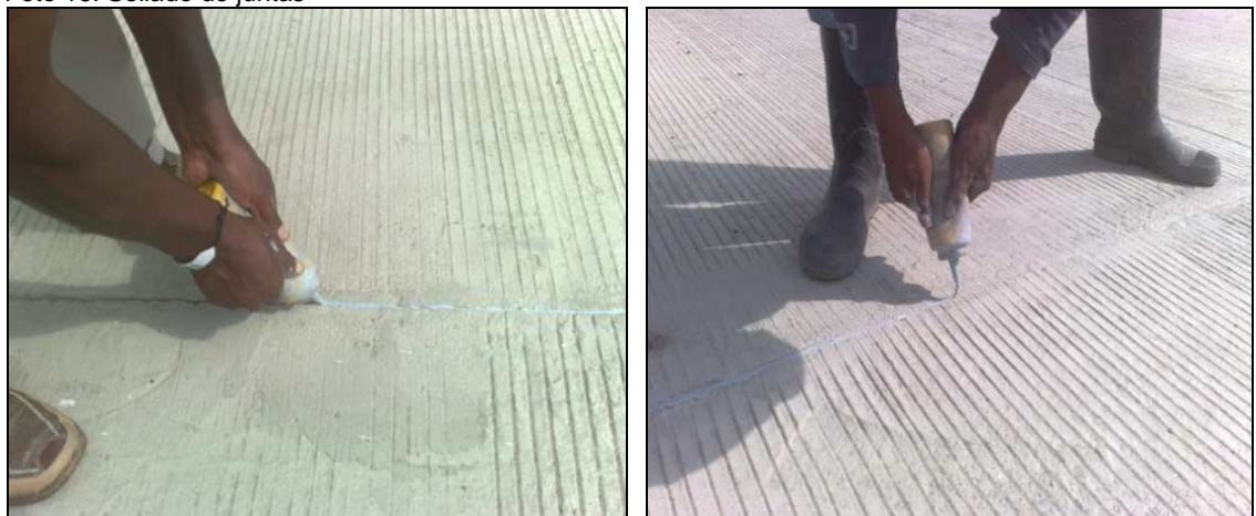
Foto 16. Sellado de juntas
