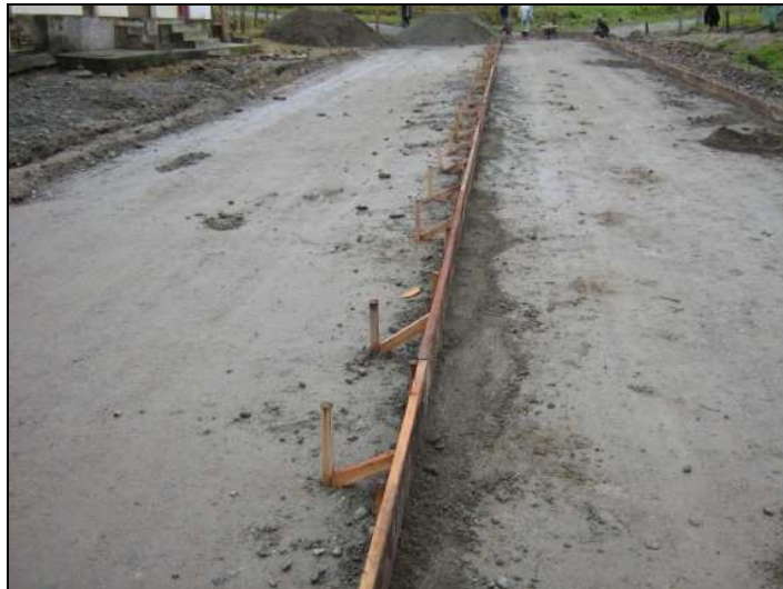
Foto 7. Colocación de la formaleta
