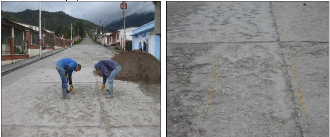
Foto 31. Localización y replanteo
