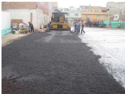
Imagen 193. Extendido de la mezcla.
