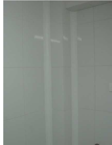
Imagen 57. Media caña terminada.
