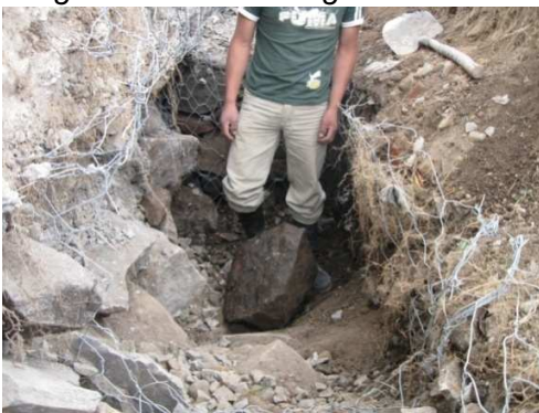
Imagen 77. Retiro de gaviones.
