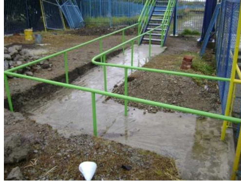
Imagen 327. Andén acceso plataforma.
