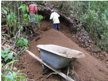
Imagen 156. Relleno con material de sitio
