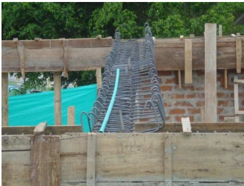
Imagen 271. Acero de refuerzo viga canal
