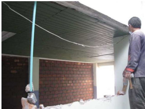
Imagen 83. Construcción de muros en mampostería.
