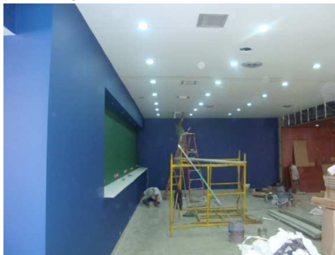
Imagen 141. Cielo falso terminado
