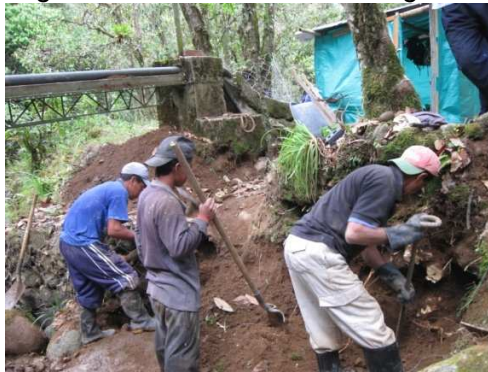
Imagen 154. Excavación en conglomerado
