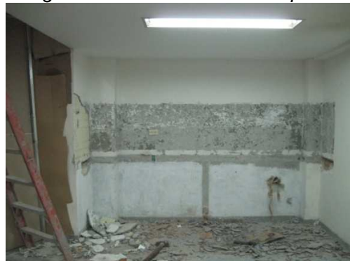
Imagen 8. Demolición de enchape.
