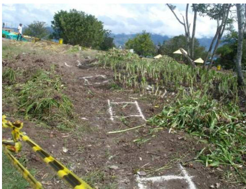
Imagen 301. Localización y replanteo.
