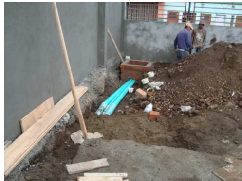
Imagen 214. Tubería Conduit, acometida y caja de inspección
