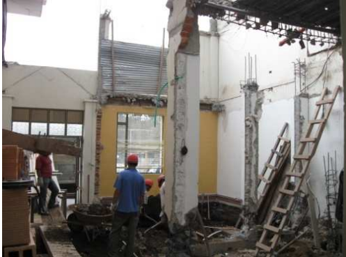
Imagen 228. Demolición de columnas.
