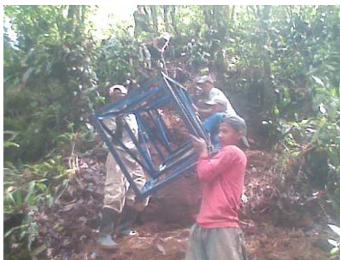
Imagen 168. Transporte de estructuras.
