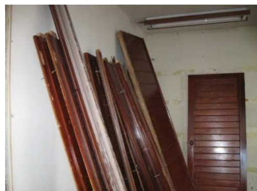
Imagen 225. Retiro de puertas.
