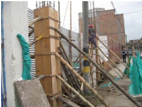
Imagen 202. Columnas (0,45x0,45 m).
