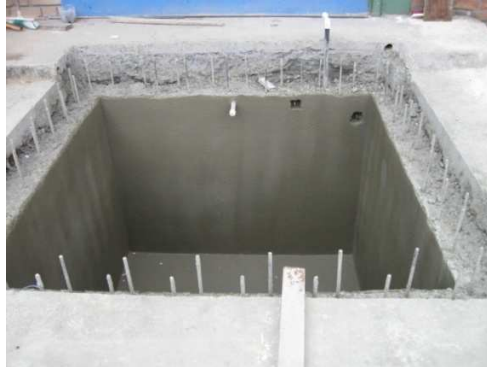
Imagen 103. Repello de paredes y piso.
