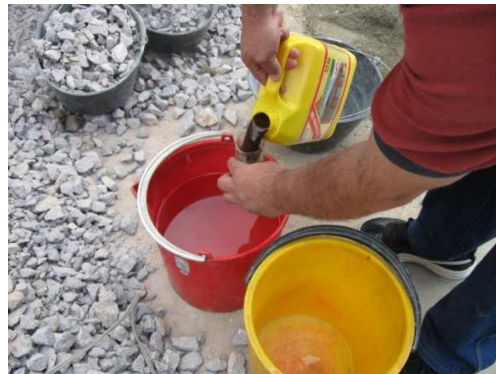
Imagen 105. Impermeabilización del Concreto.
