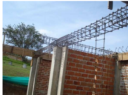
Imagen 272. Refuerzo viga aérea.
