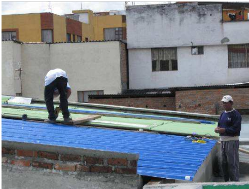
Imagen 116. Retiro e instalación de tejas.
