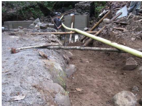
Imagen 171. Relleno con material de sitio.
