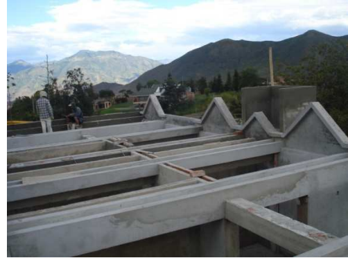
Imagen 274. viga canal terminada.
