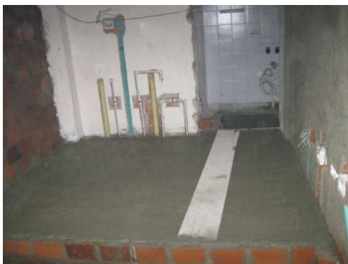
Imagen 17. Fundición placa de piso.
