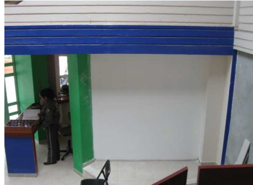
Imagen 66 .Muro en superboard.
