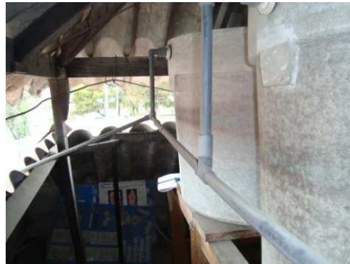
Imagen 223. Desmonte de tanques AC.
