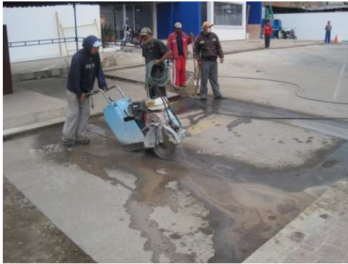
Imagen 181. Corte carpeta asfáltica
