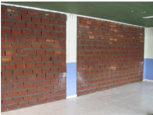
Imagen 89. Muro en mampostería terminado.
