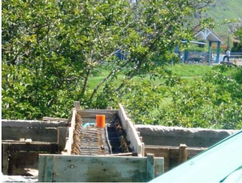
Imagen 273. Formaleta viga canal.
