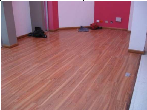
Imagen 51. Instalación de piso flotante en madera.
