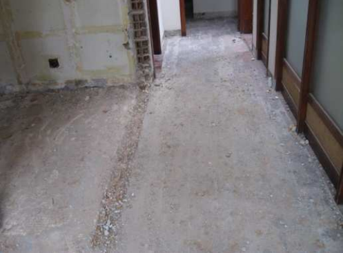
Imagen 230. Demolición enchape de piso.
