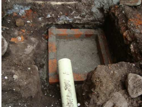
Imagen 212. Construcción caja de inspección.
