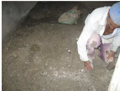
Imagen 120. Demolición de placa de piso.
