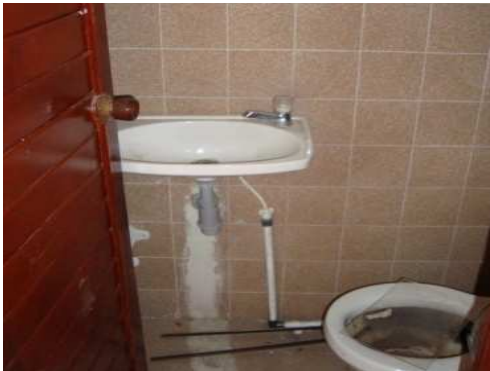
Imagen 222. Desmonte de aparatos Sanitarios.
