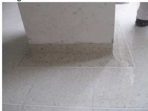
Imagen 53. Terminación de la barredera.
