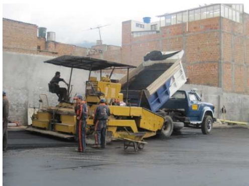
Imagen 192. Colocación de mezcla.
