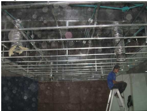
Imagen 139. Estructura cielo falso.
