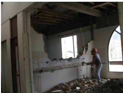
Imagen 226. Demolición de muros.
