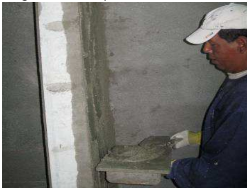
Imagen 123. Repello de muros.
