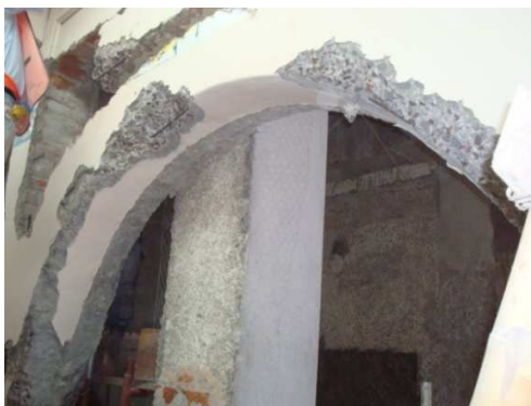
Imagen 9. Demolición de dinteles.
