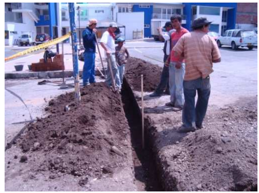
Imagen 185. Excavacion Instalacion de Tuberia.
