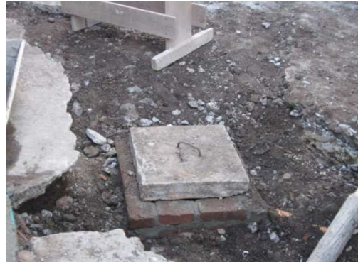
Imagen 29. Terminación caja de inspección.
