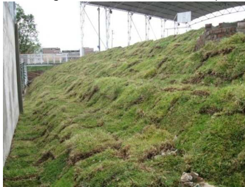
Imagen 85. Instalación de césped.
