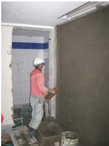
Imagen 56. Construccion medias cañas
