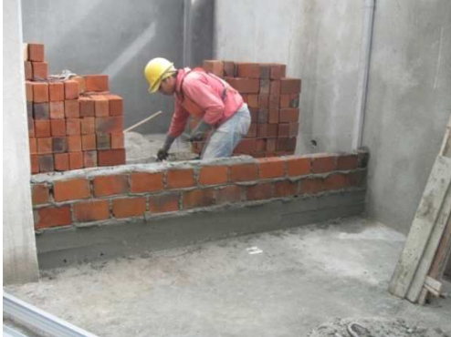
Imagen 22. Construcción muro en soga
