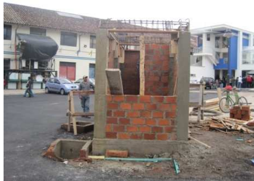
Imagen 206. Viga aérea en concreto
