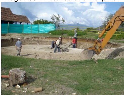
Imagen 302. Excavación a máquina.
