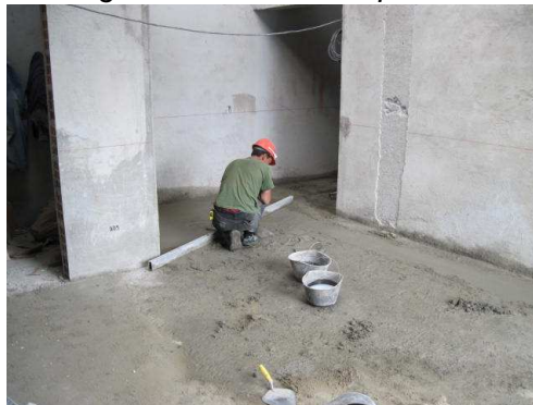
Imagen 236. Pañete de piso.
