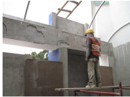
Imagen 5. Demolición repello viga.
