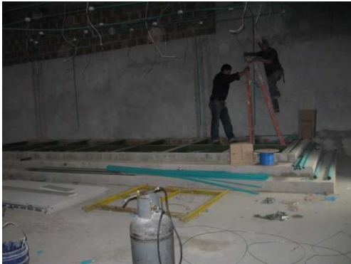
Imagen 145. Est. metálica superboard piso
