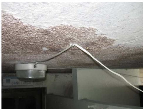
Imagen 98. Demolición de perlita en cielo raso.
