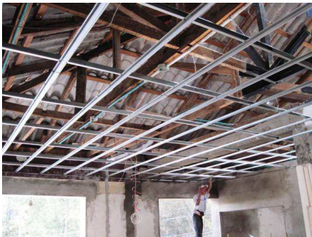
Imagen 256. Estructura cielo raso.
