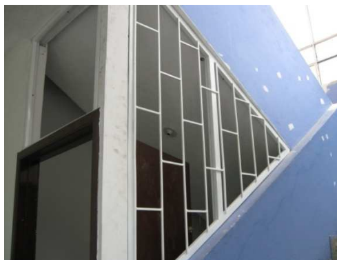
Imagen 95. Instalación de ventanas.
