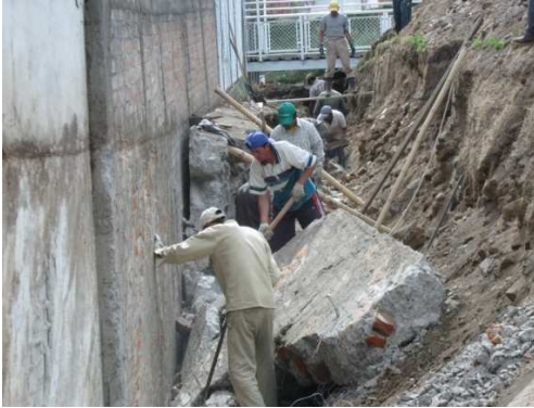
Imagen79. Demolición de muro
