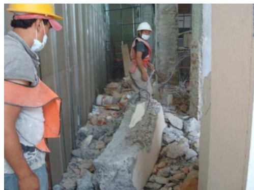
Imagen 10. Demolición Concreto Reforzado.
