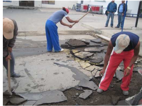
Imagen 182. Demolicion carpeta asfáltica.
