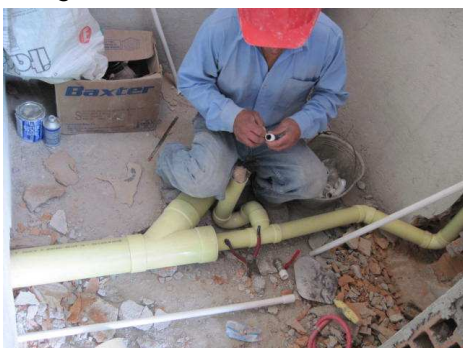
Imagen 248. Instalación de tubería.
