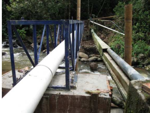
Imagen 175. Recubrimiento con sikafill
