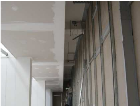
Imagen 61. Instalación dintel en Dry Wall
