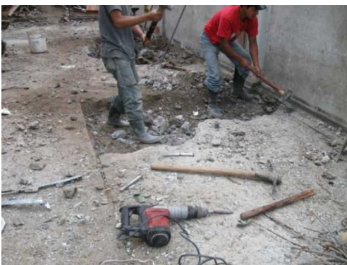
Imagen 81. Demolición de placa de piso
