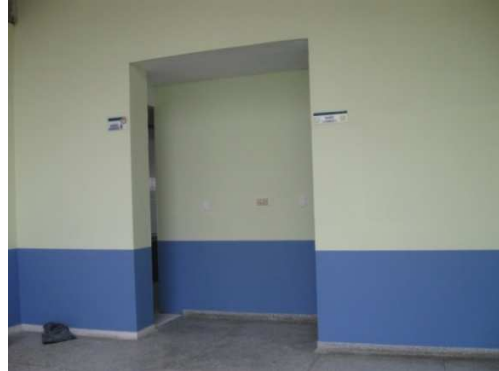
Imagen 92. Aplicación de pintura.
