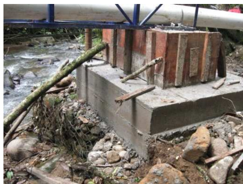
Imagen162. Zapata y dado de anclaje.
