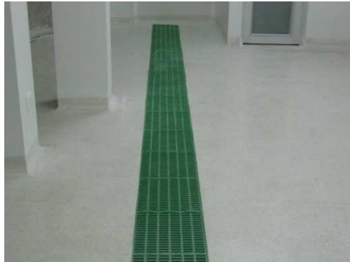
Imagen 21. Instalacion rejilla plástica.
