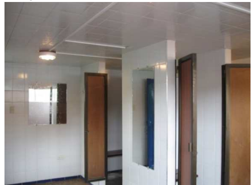
Imagen114. Finalización de enchape
