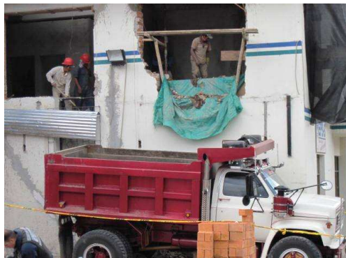
Imagen 232. Desalojo de escombros.
