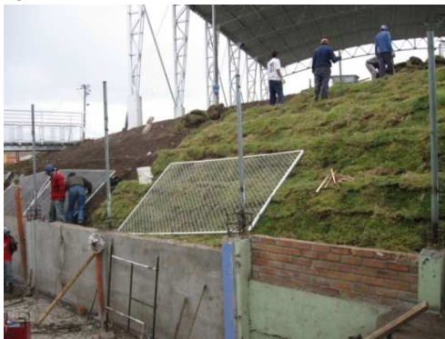
Imagen 88. Instalación de mallas eslabonadas
