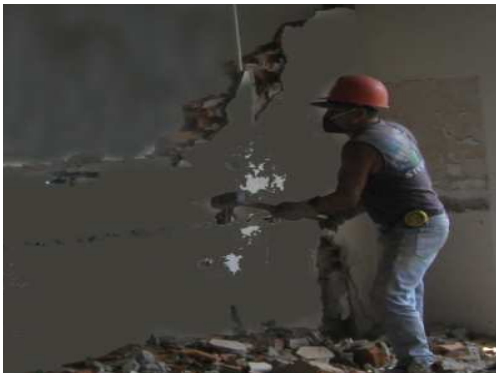
Imagen 119. Demolición de muros.
