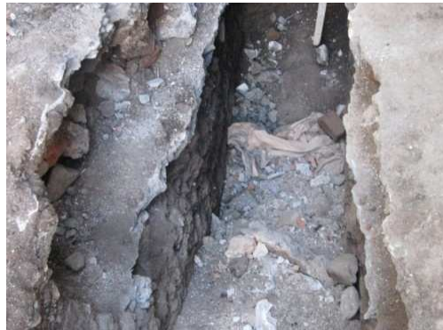
Imagen 12. Demolición placa de 25 cm.
