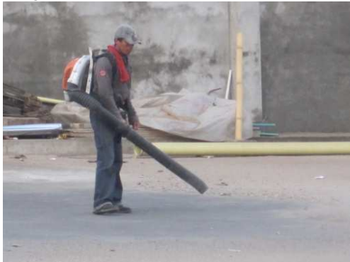
Imagen 190. Limpieza con sopladora.
