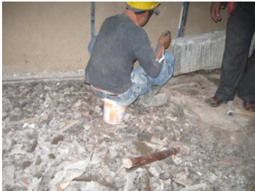
Imagen 11 .Demolición de placa.
