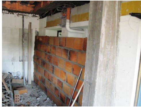
Imagen122. Muro en ladrillo farol
