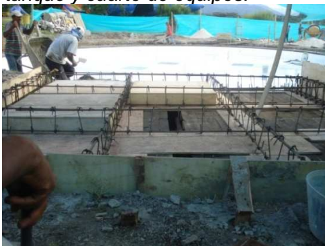
Imagen 317. Conformación cubierta tanque y cuarto de equipos.
