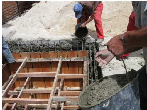
Imagen102. Fundición de muros.
