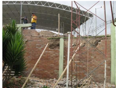
Imagen 82. Demolición muro en mamp.
