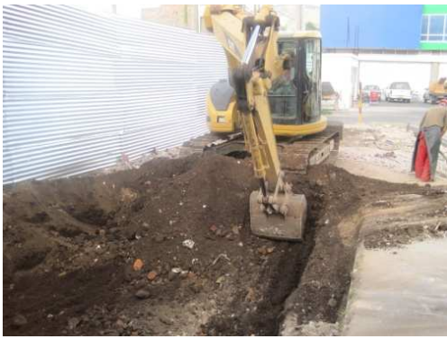
Imagen 184. Excav. Mejoramiento de suelo.
