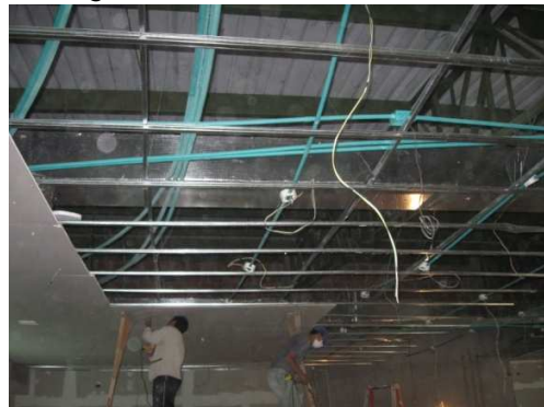
Imagen 140. Instalación cielo falso.
