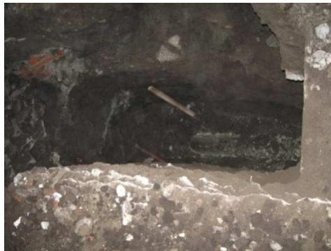
Imagen 13. Demolición tubería de concreto
