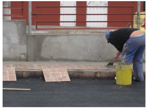
Imagen 216. Instalación cerámica piso.
