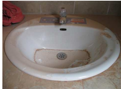
Imagen 209. Instalación de lavamanos.
