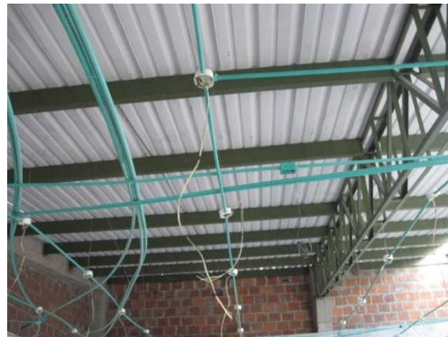
Imagen 138. Estructura con anticorrosivo.
