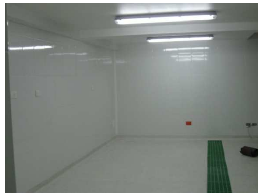
Imagen 50. Terminación de enchape.
