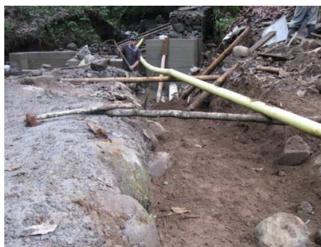
Imagen 169. Excavación en conglomerado.
