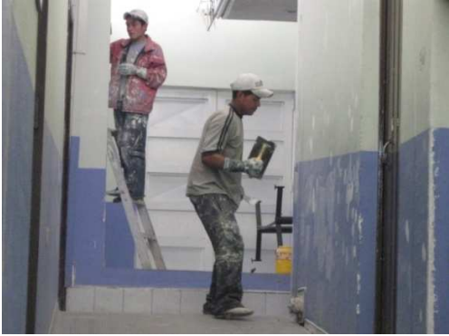
Imagen 91. Mejoramiento de acabados.
