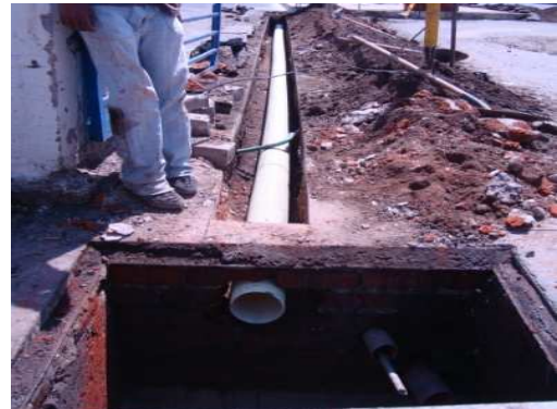
Imagen 211. Instalación tub sanitaria 6".
