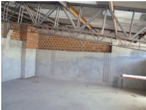
Imagen 137. Estado inicial de la estructura
