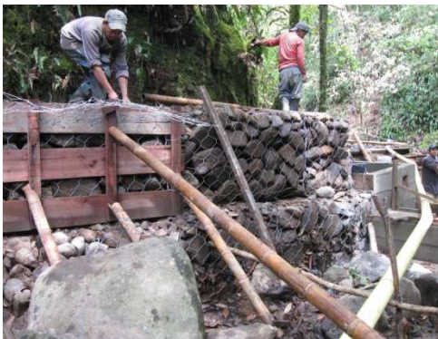
Imagen165.construcción muro en gaviones.
