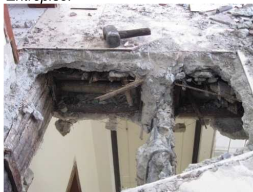
Imagen 227 Demolición Losa de Entrepiso.
