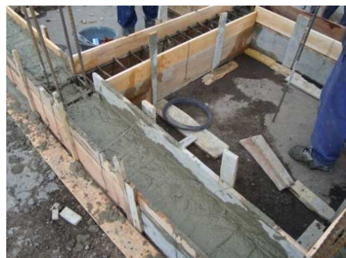
Imagen 205. Fundición viga de piso.
