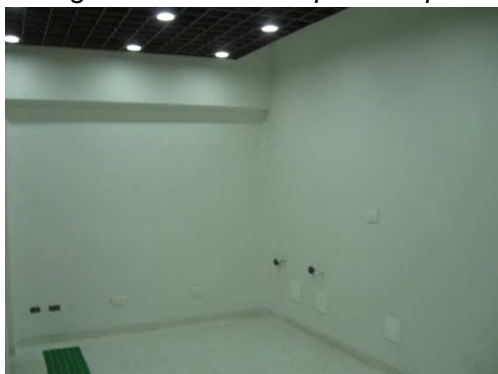
Imagen 44. Muros con pintura epóxica
