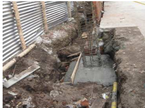
Imagen 197. Fundición de zapata.
