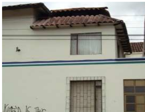
Imagen 221. Desmonte de teja de asbesto cemento
