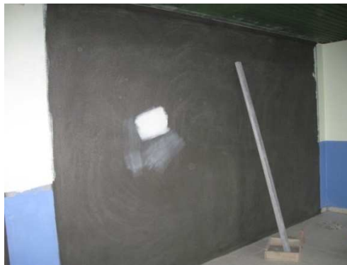
Imagen 90. Repello de muro.
