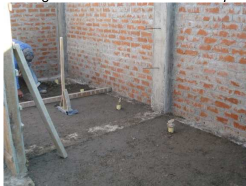
Imagen 265. Relleno en losa de piso.
