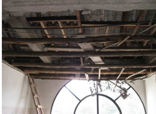
Imagen231. Demolición de cielo raso.
