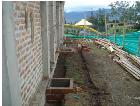
Imagen 291. Construcción cajas de inspección.
