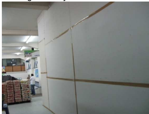
Imagen 3. Dry wall sin acabado.
