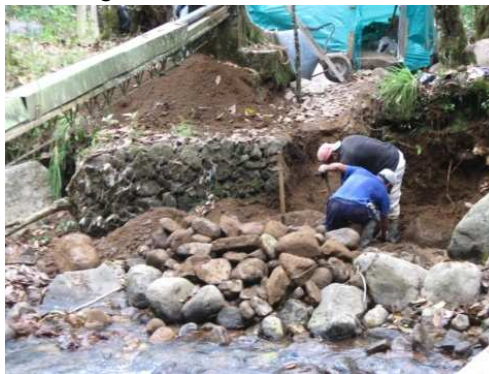
Imagen 155. Excavación en roca.
