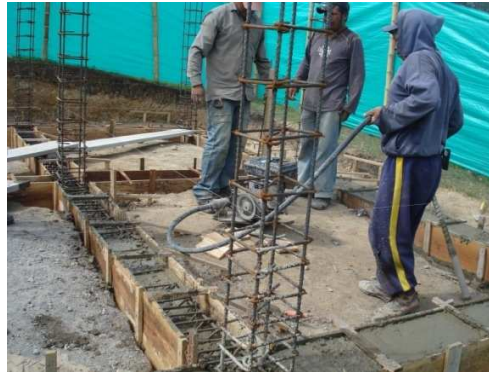
Imagen 270. Vaciado de concreto.
