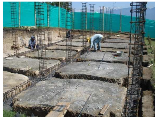
Imagen267. Acero de refuerzo vigas y Columnas.
