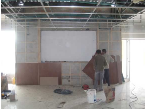
Imagen 148. Estructura enchape madera
