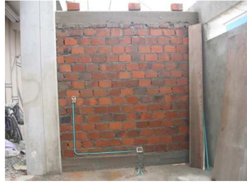
Imagen 23. Muro en soga terminado
