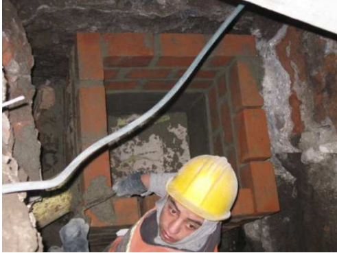
Imagen 28. Construcción cámara de insp.
