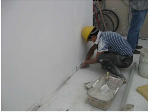
Imagen 54. instalacion barredera plana.
