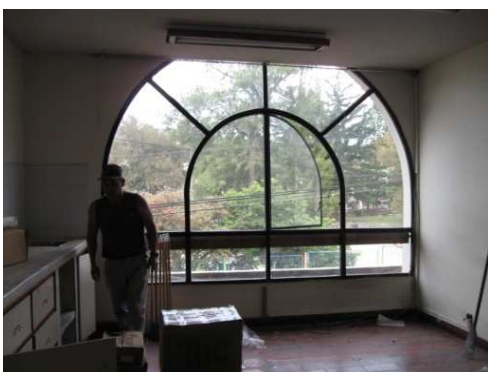
Imagen 224. Retiro de ventanas.
