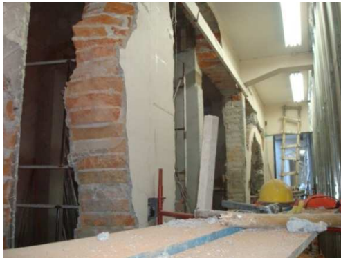
Imagen 4. Demolición muro de 30 cm.
