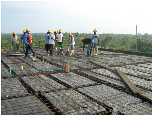
Foto 10 Pases de instalaciones por placa.
