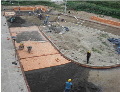
Foto 57 Instalación de adoquín de arcilla.
