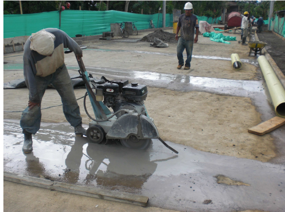
Foto. 62 Corte de juntas
