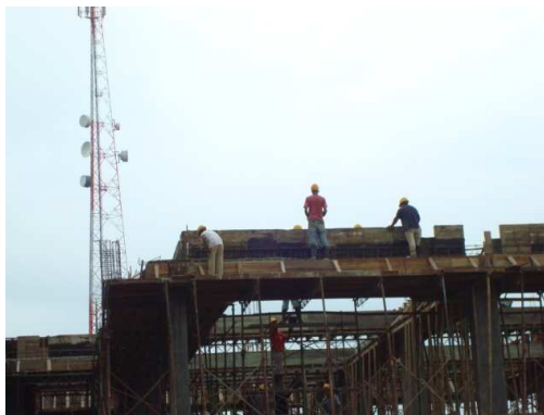
Foto 13 Armado acero de refuerzo vigas aéreas bloqu1.
