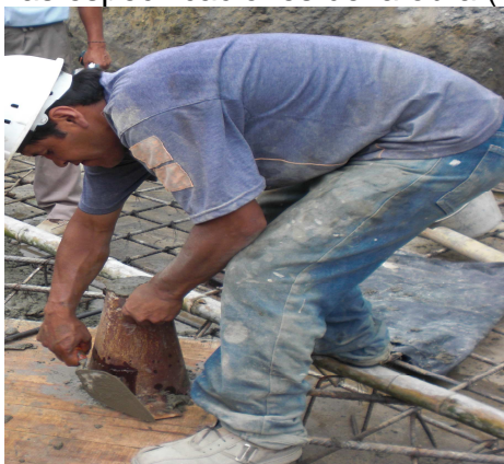
Foto 2 Ensayos de asentamiento
