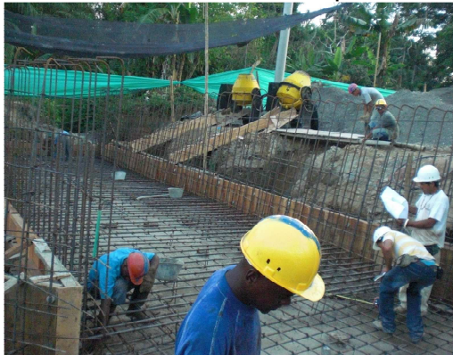
Foto 50 Revisión acero y formaleta placa box culvert.
