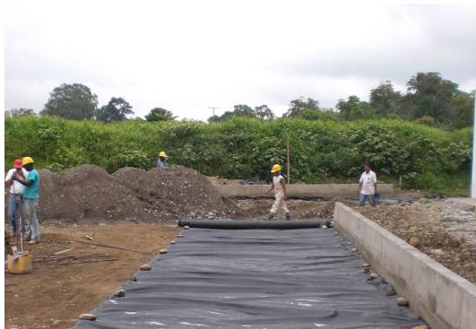
Foto 43 Instalación de geotextil.
