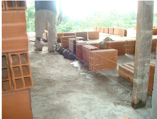
Foto 23 Replanteo y arranque de muros con ayuda de hilo.
