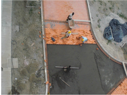
Foto 58 Instalación de adoquín de arcilla.
