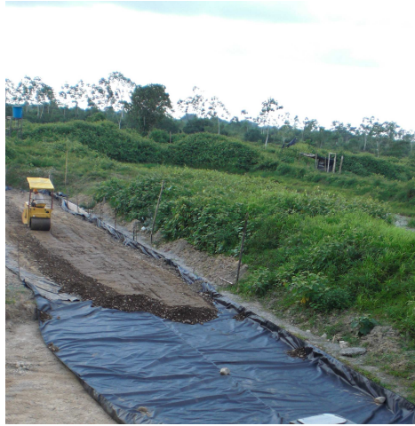
Foto 44 Compactación de súb base
