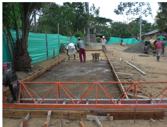
Foto. 60 Formaleta para pavimento
