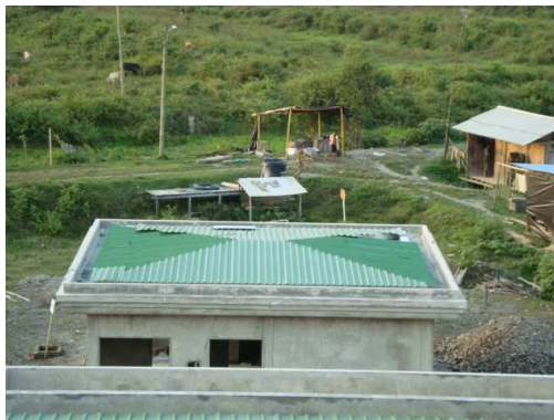
Foto 26 Proceso final de la instalación de teja termoacustica en la morgue.
