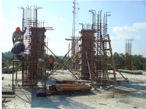
Foto 4 Armado refuerzo y encofrado de columna.
