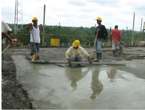
Foto 12 Proceso final de la placa.
