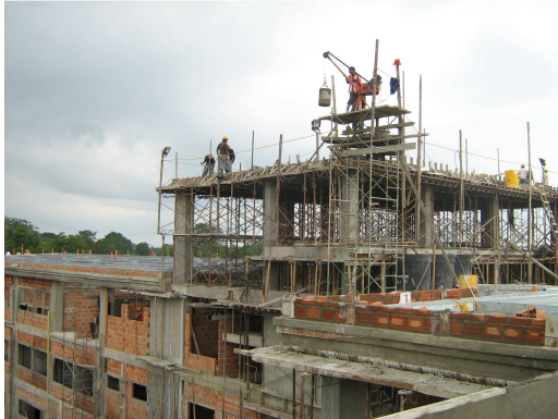
Foto 9 Colocación del concreto en sitio.
