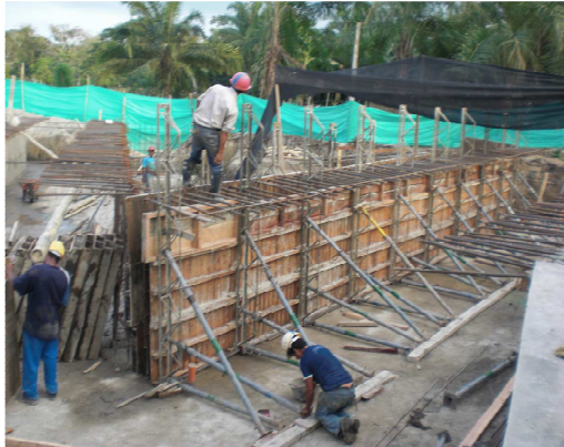
Foto 51 Revisión formaleta muro box culvert.
