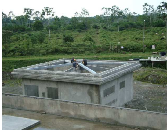
Foto 24 Estructura metálica para cubierta de la morgue.
