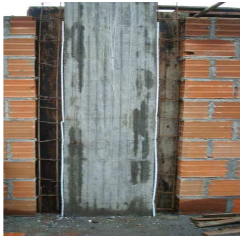
Foto 19 Refuerzo columneta de confinamiento.
