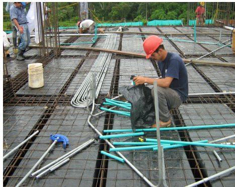
Foto 8 Instalaciones embebidas en la placa.
