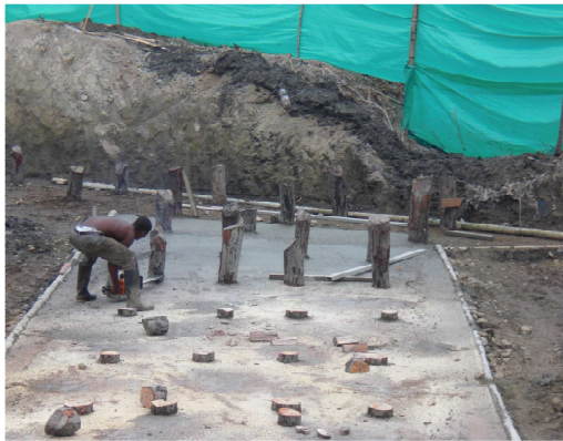
Foto 49 Descabece de pilotes.
