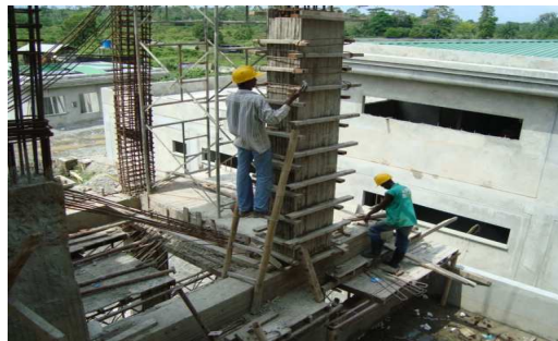
Foto 17 Refuerzo y encofrado de columnas de escalera.
