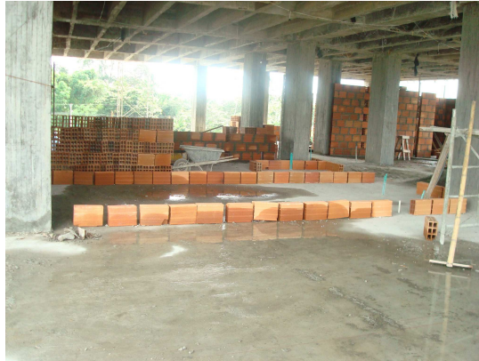
Foto 22 Replanteo y arranque de muros.
