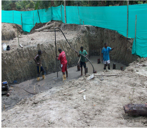
Foto 48 Hincado de pilotes de mangle.
