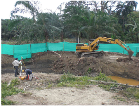
Foto 42 Excavación para box culvert.
