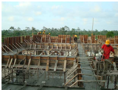
Foto 15 Fundición vigas aéreas bloqu1.
