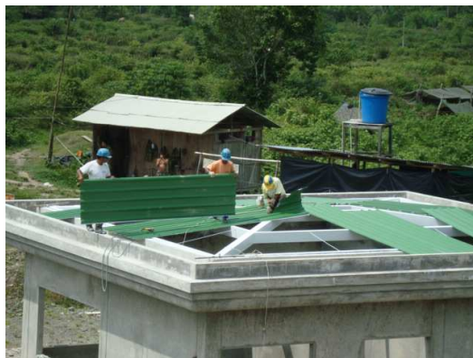
Foto 25 Instalación de teja termoacustica en la morgue.
