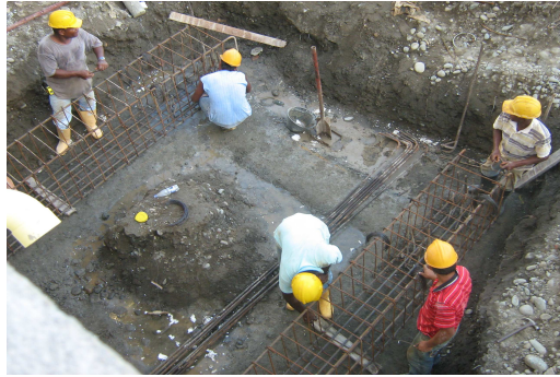
Foto 16 Refuerzo de cimientos de escalera.
