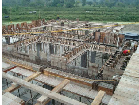
Foto 14 Encofrado vigas aéreas bloqu1.
