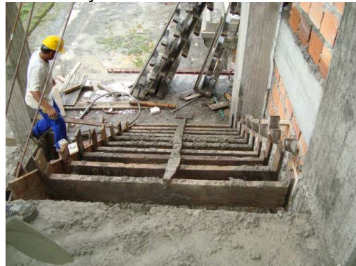
Foto 18 Encofrado de pasos de escalera.
