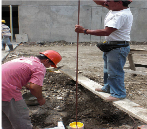
Foto 37 Varilla cooper Weld.
