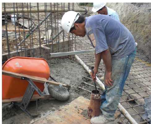
Foto 53 Ensayos de asentamiento.
