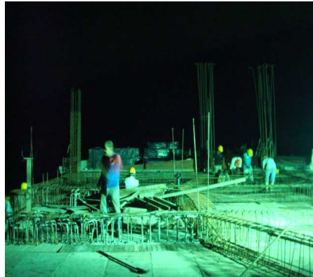
Foto 7 Armado de refuerzo de placa de entresiso.
