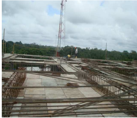
Foto 6 Encofrado de placa de entresiso.
