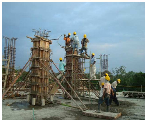
Foto 5 Fundición de columnas.
