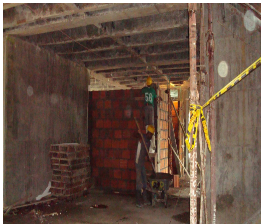
Foto 21 Fundición de columneta.
