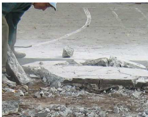
Imagen 2. Demolición de placa.
