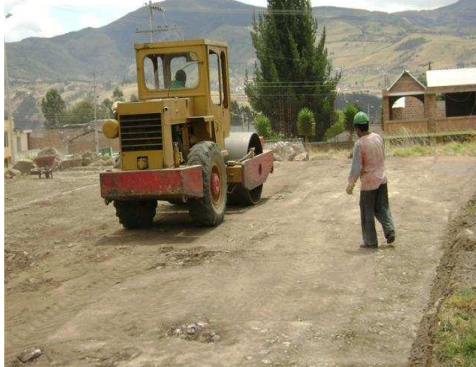
Imagen 17. Compactación de la base
