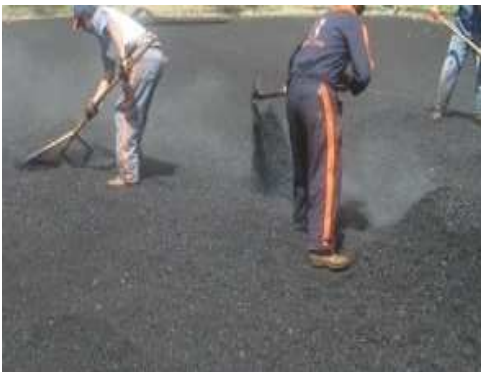
Imagen 6. Extendido de la mezcla
