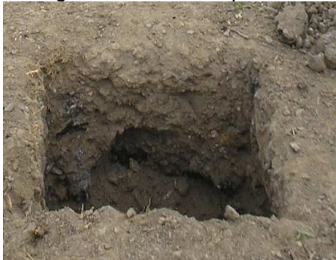
Imagen 30. Excavacion para dados.
