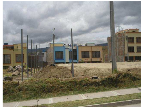
Imagen 19. Apoyos en tubo estructural de 2"
