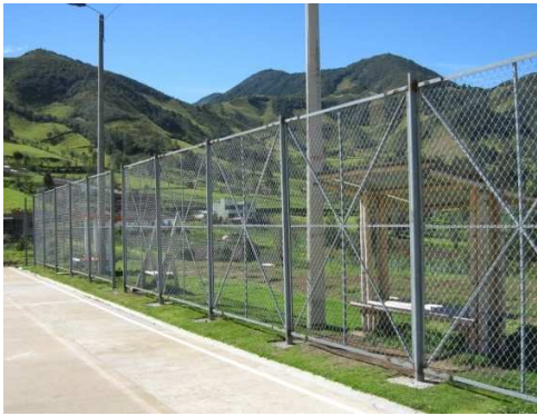
Imagen 32. Dados en concreto de 3000 psi.
