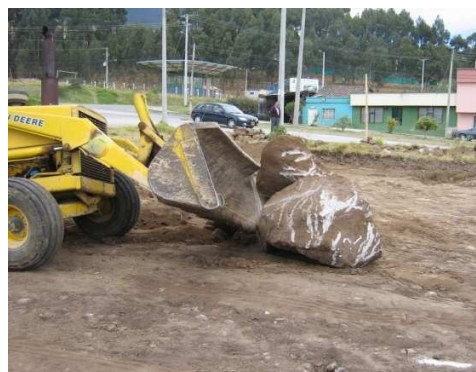
Imagen 13. Excavación a máquina.
