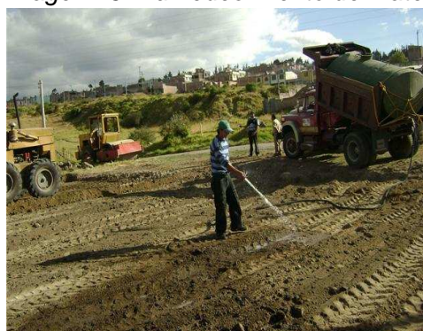
Imagen 16. Humedecimiento de material
