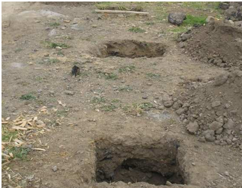
Imagen 18. Excavación para dados.
