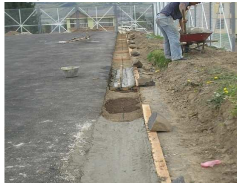
Imagen 26. Fundición de cunetas.
