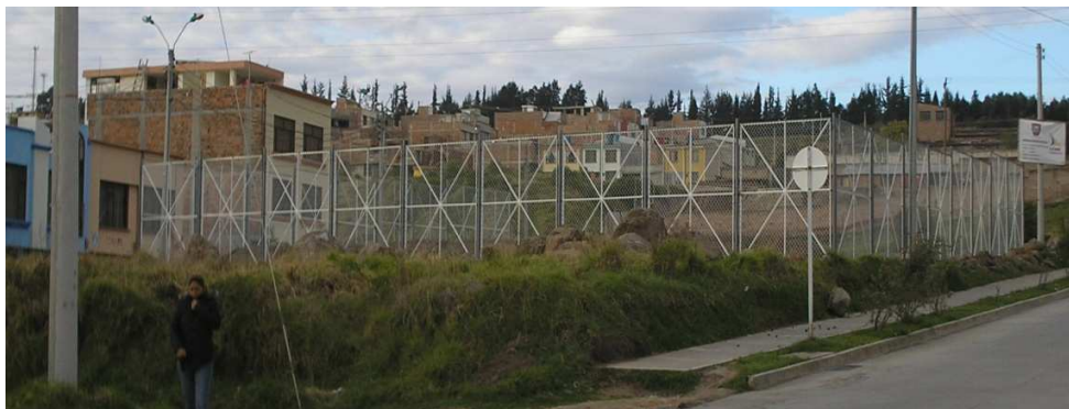
Imagen 21. Cerramiento de protección en tubo estructural 2 ½”.
