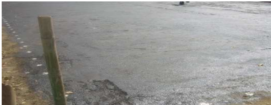
Imagen 22. Colocación de imprimante.
