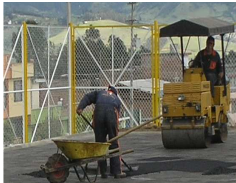
Imagen 24. Extendido y compactación de mezcla.
