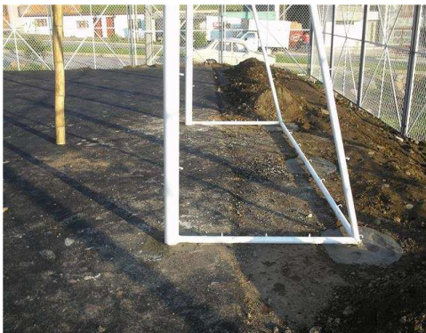
Imagen 27. Construcción dados en concreto
