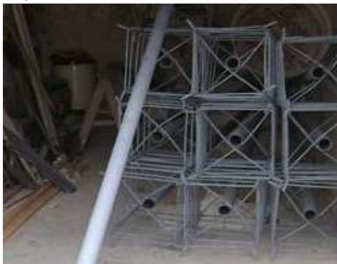
Imagen 31. Acero de refuerzo 60000 psi.
