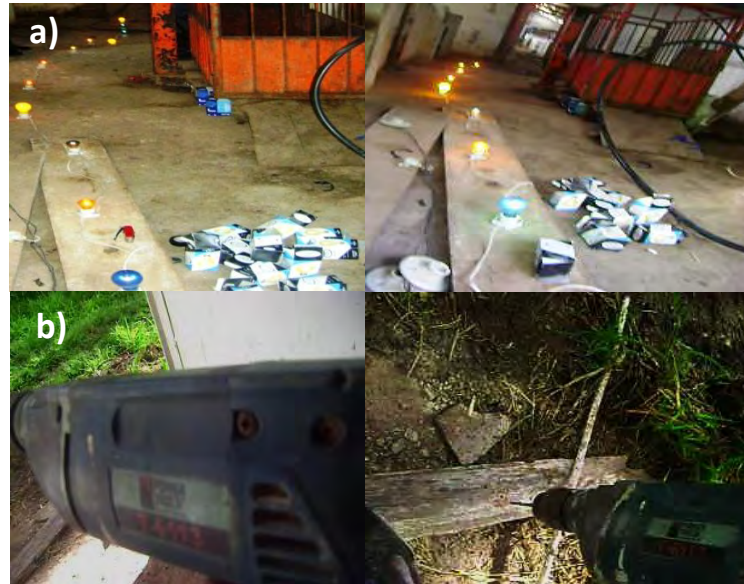
Figura 49. Pruebas de encendido eléctrico a) encendido de bombillos b) encendido de taladro
