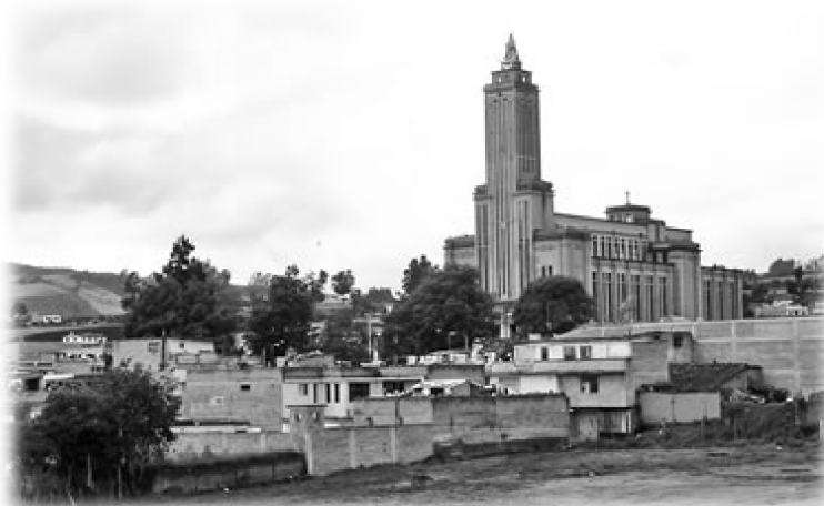
Fotografía N° 2 Corregimiento de Catambuco.
