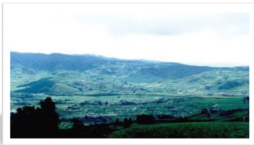
Fotografía N° 1 Panorámica de Catambuco.
