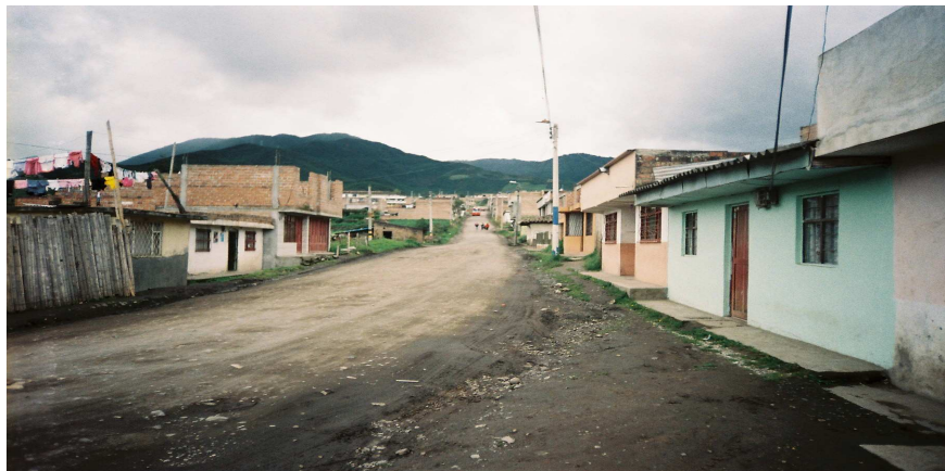
Figura 10. Irregularidades e inexistencia de andenes
