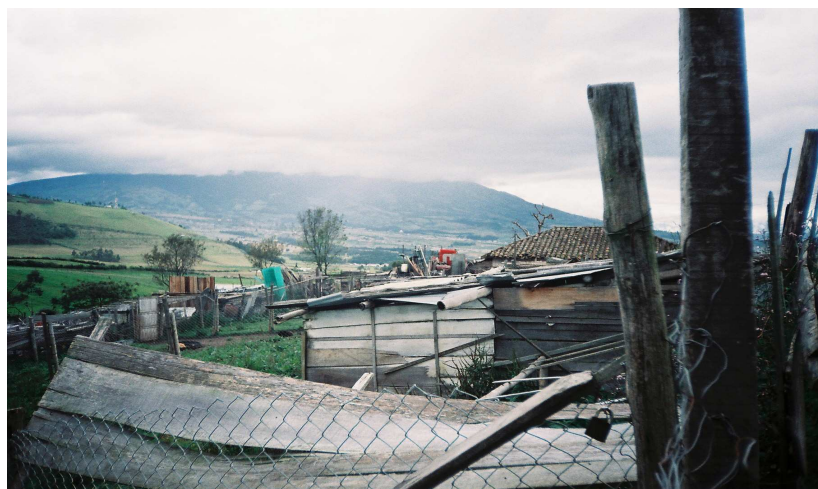
Figura 5. Perrera municipal junto a viviendas
