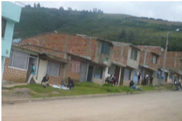
Imagen 10. Vía vehicular Barrio Villa Nueva. Fuente esta investigación
