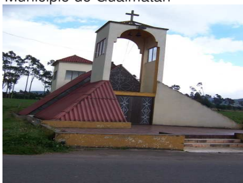
Figura 4. Capilla Corregimiento de Cuatis. Municipio de Gualmatán
