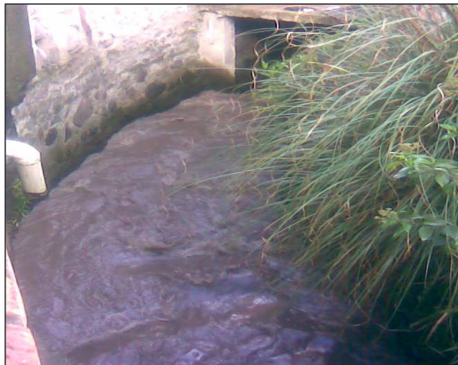
(Figura 44) "Recorrido Q. Mijitayo sin canalizar desde la parte alta de la Avenida Mijitayo hasta Colegio Filipense" Fuente: esta Investigación fecha Noviembre 14 de 2007.
