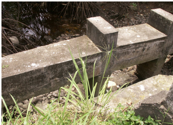
Figura 15. Obras de protección de la línea de conducción
