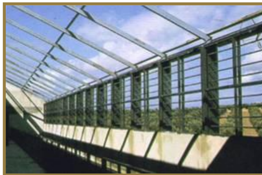
Figura 10. Fotografía muro de cerramiento
