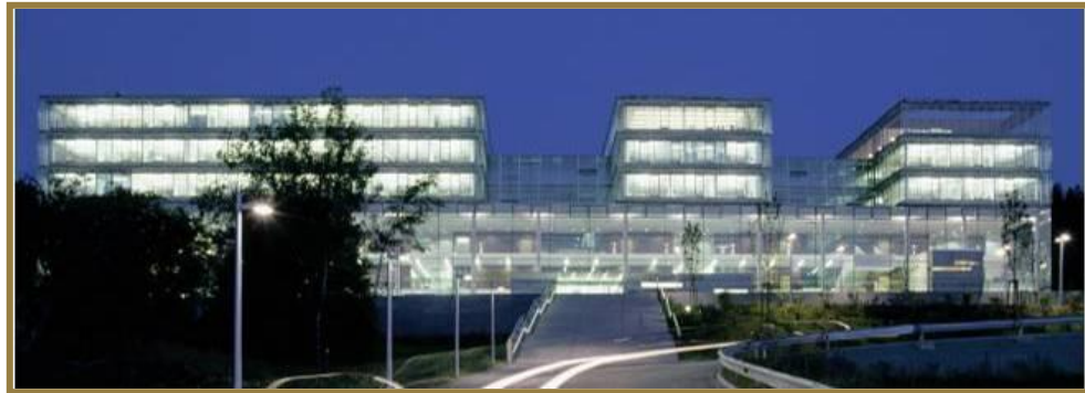
Figura 14. Fotografía fachada principal
