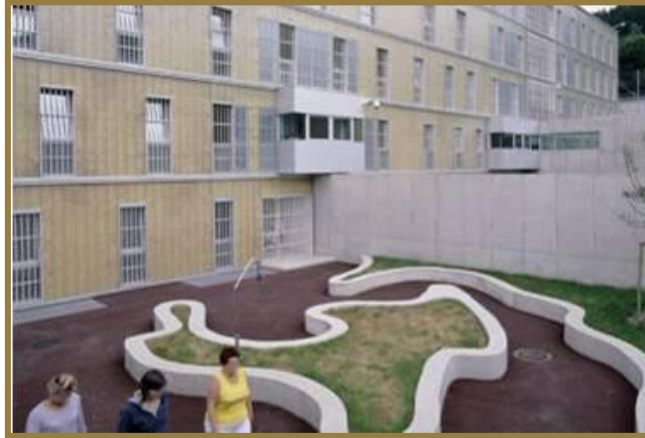
Figura 16. Exteriores área residencial
