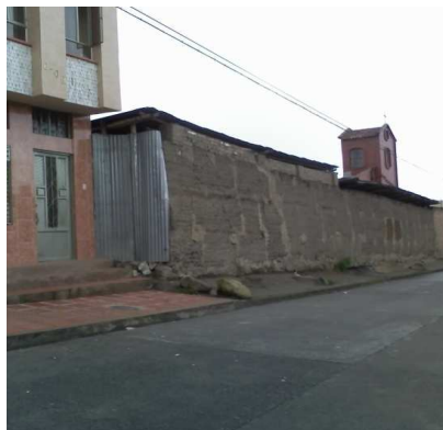
Fotografía 33. Actual Parqueadero Barrio San Vicente
