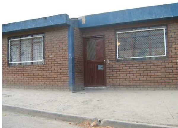
Fotografía 61. Salón Comunal Panorámico I Carrera 37 con calle 50
