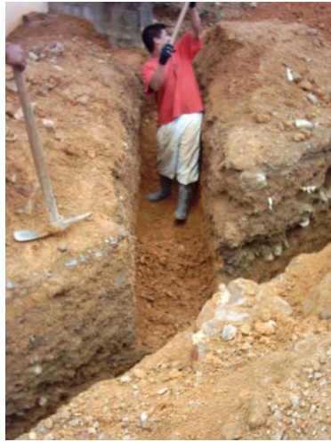
Imagen 16. Excavaciones a mano para instalación de acometida domiciliaria
