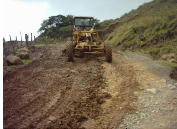
ACTIVIDADES DE CONFORMACIÓN DE CALZADA
