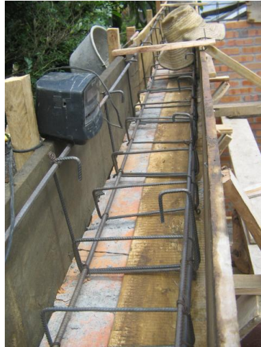
CONSTRUCCIÓN DE VIGA CANAL
