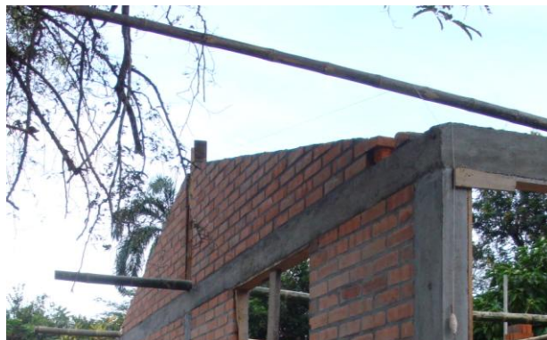
MUROS DE CULATA
