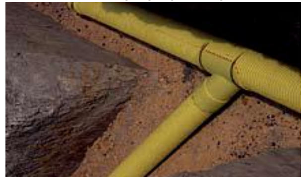
COLOCACIÓN DE LA ACOMETIDA DOMICILIARIA
