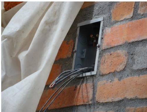
INSTALACIÓN DE TABLERO DE CIRCUITOS
