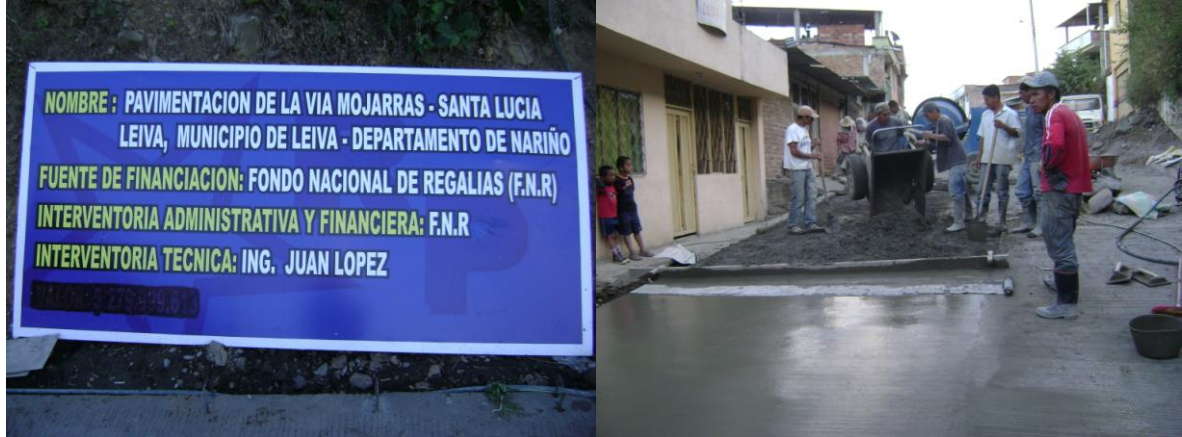
Imagen 29. Valla y proyecto en ejecución
