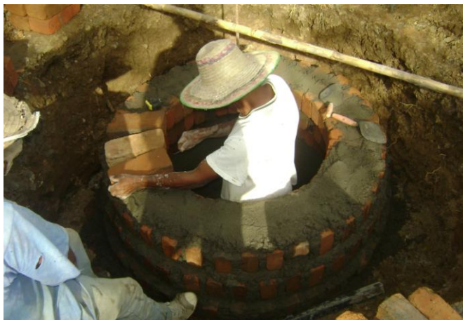
Imagen 17. Construcción de cámaras de inspección
