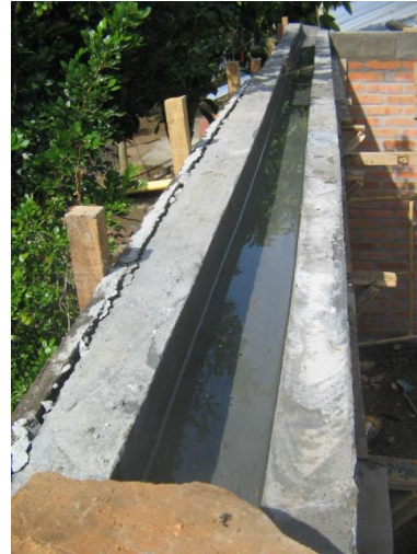
VIGA CANAL EN CONCRETO
