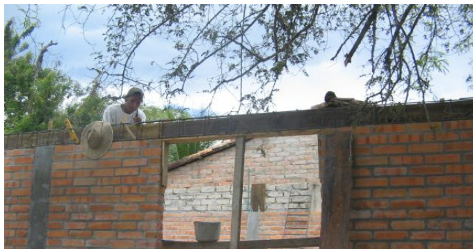
CONSTRUCCIÓN VIGA DE AMARRE
