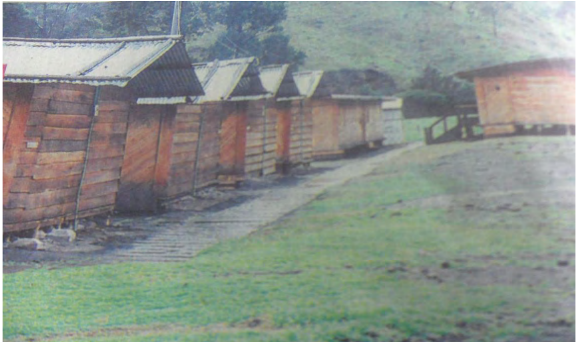
Figura 11. Albergue el Vergel, en desolación por la no evacuación.
