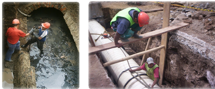
Figura 25. PROYECTO RENOVACIÓN REDES DE ALCANTARILLADO URBANO
