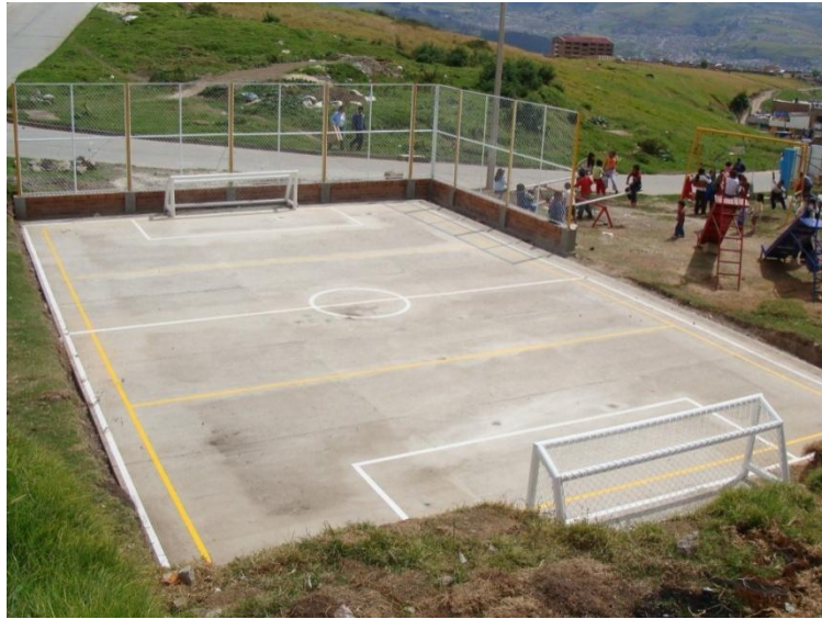
Figura 21. Líneas de demarcación, cerramiento y canchas pintadas.
