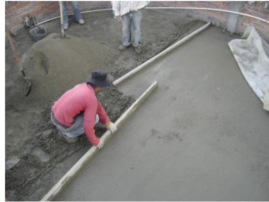
Figura 46. Repello del piso.
