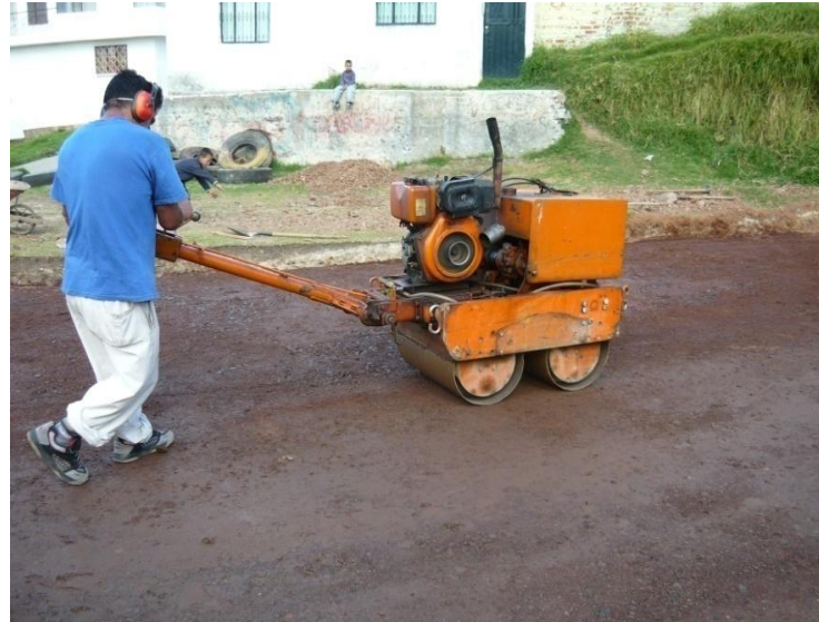
Figura 6. Compactación con rodillo compactador manual.
