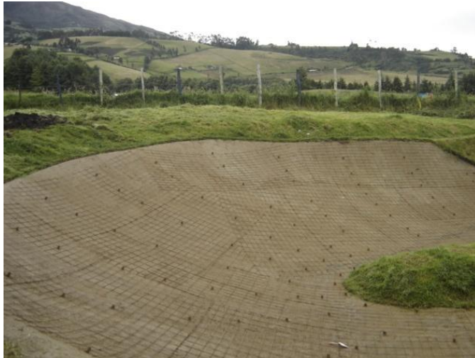
Figura 28. Colocación de la malla electro soldada.
