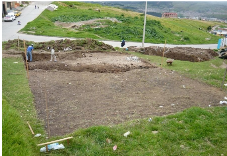
Figura 3. Excavación del terreno manualmente.
