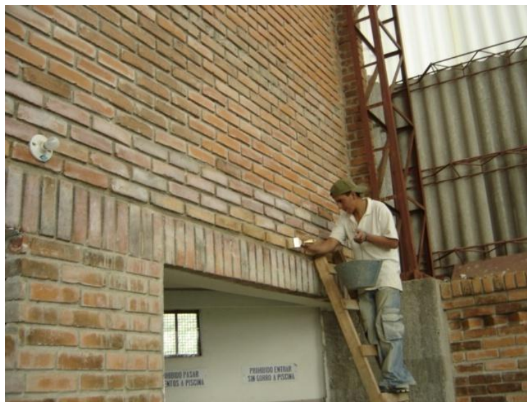
Figura 49. Aplicación de Sika transparente en los muros afectados.
