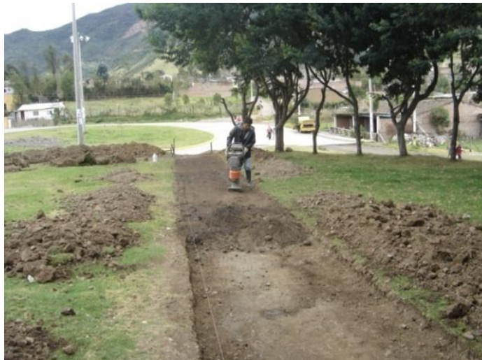
Figura 41. Compactación de la base.
