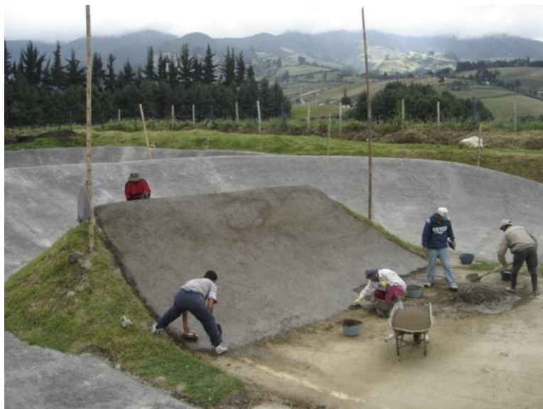
Figura 31. Fundición de saltos en la pista.
