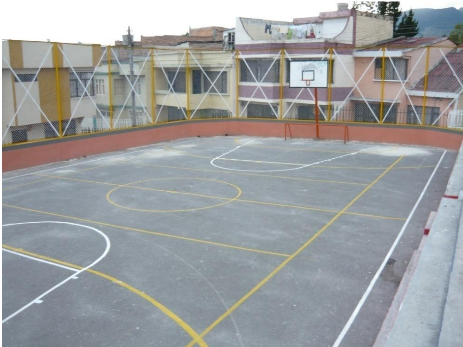
Figura 74. Obra terminada en el polideportivo.
