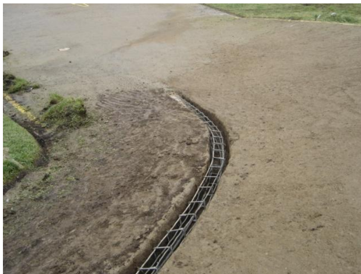
Figura 27. Viga de confinamiento en la curva N° 1.
