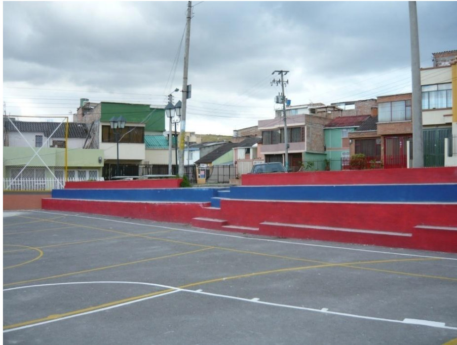
Figura 73. Graderías pintadas y terminadas.
