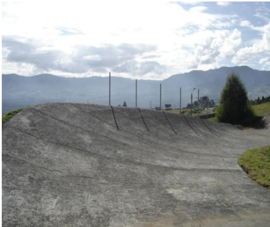
Figura 35. Obra terminada en la curva 4.
