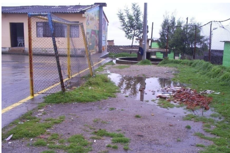
Figura 95. Estado inicial del polideportivo en la zona de la iglesia.
