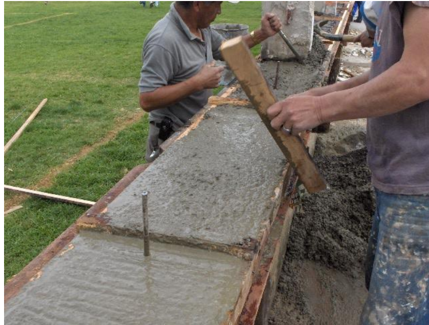
Figura 88. Proceso de fundición de la alfajía.
