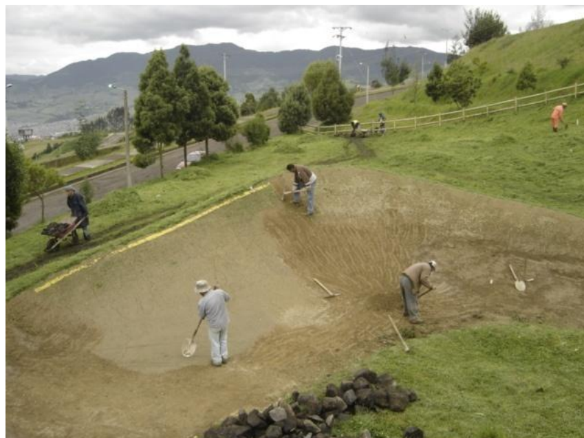
Figura 22. Excavación en la superficie de la pista.
