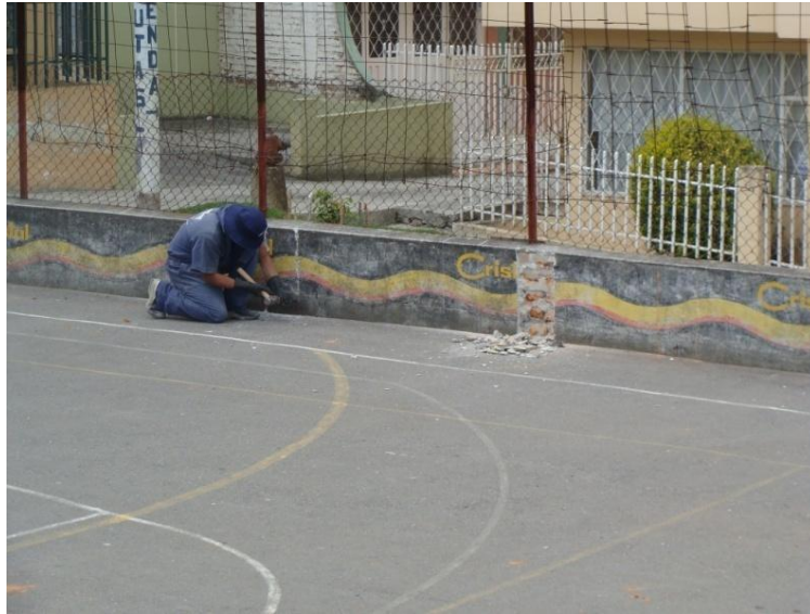
Figura 57. Demolición de la mampostería existente.
