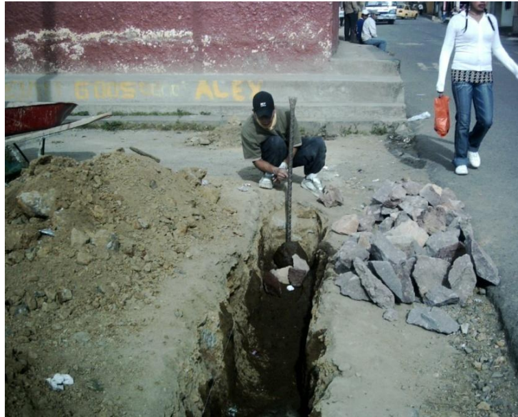
Figura 96. Actividades de excavación en la obra.
