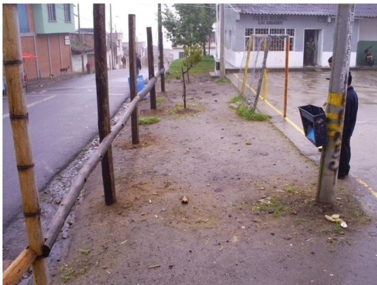
Figura 94. Estado inicial del polideportivo en la zona del CAI.
