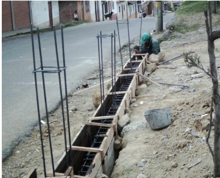
Figura 98. Armado y encofrado de la viga.
