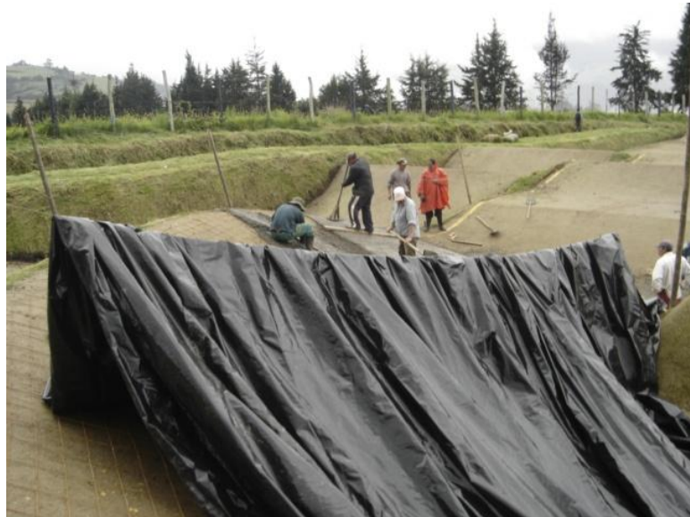
Figura 30. Fundición de la placa bajo lluvia.
