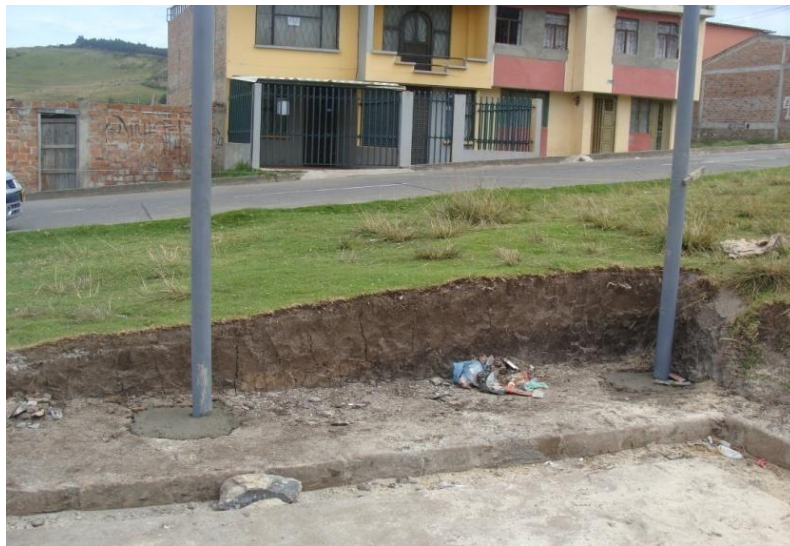
Figura 81. Dados en concreto fundidos con el tubo estructural de 3\"
