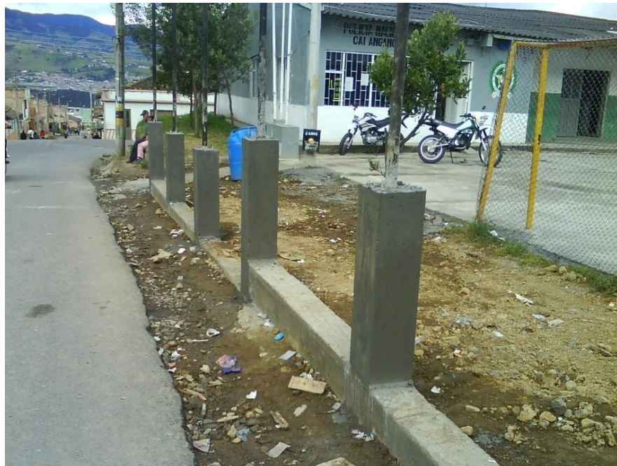
Figura 101. Columnas fundidas con el tubo estructural para el cerramiento.
