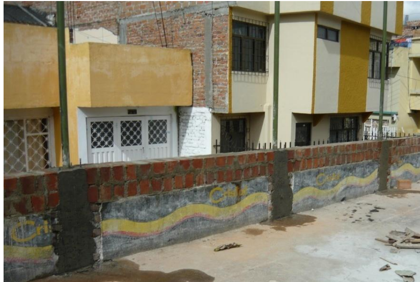
Figura 63. Columnas fundidas con el tubo estructural de 3\"
