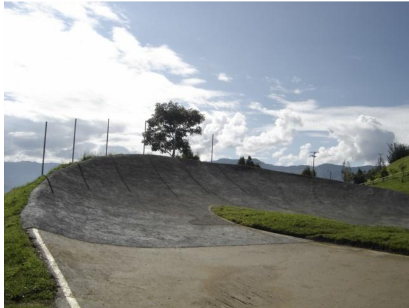
Figura 32. Obra terminada en la curva 1.
