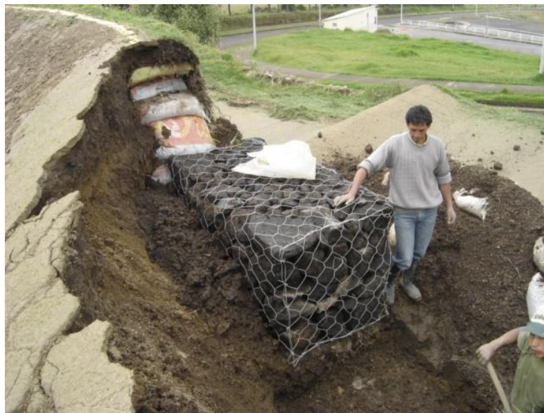
Figura 25. Construcción de muro en gavión.
