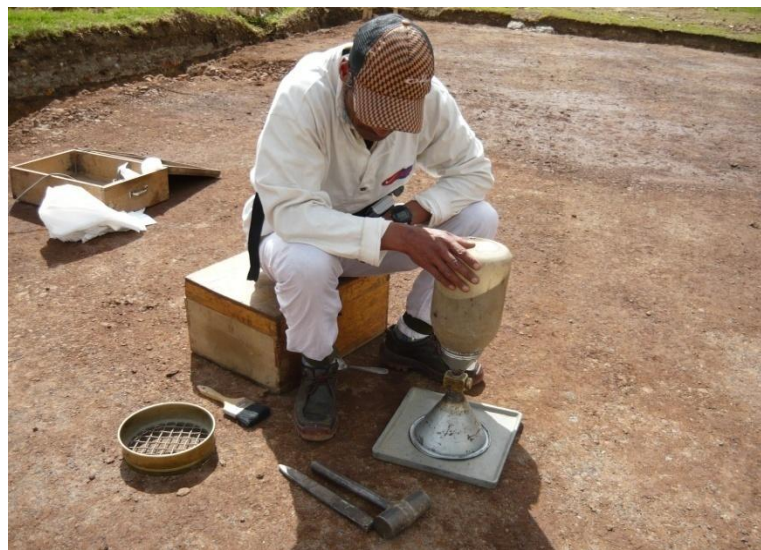
Figura 7. Ensayo del cono y la Arena en la obra.
