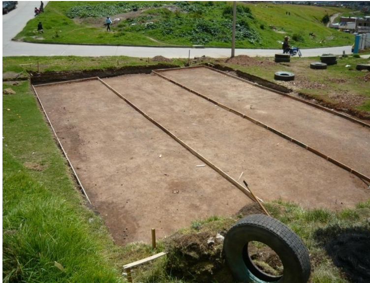
Figura 8. Formaleta de la losa.
