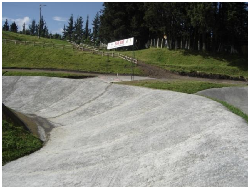
Figura 33. Obra terminada en la curva 2.
