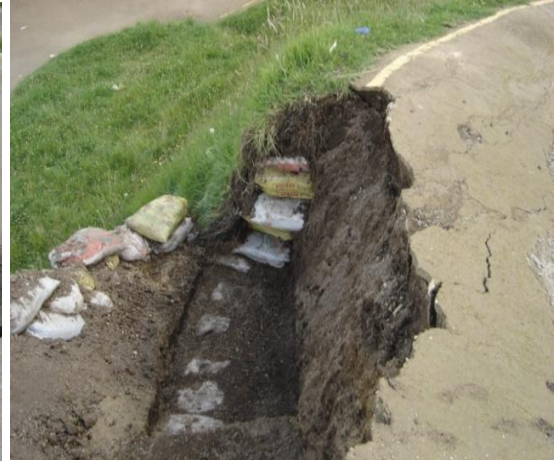
Figura 24. Excavación para gavión
