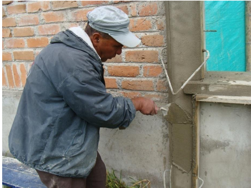
Figura 90. Aplicación de mortero a columnas y vigas.
