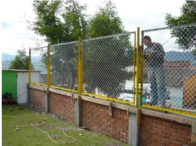
Figura 104. Alfajía fundida y cerramiento en ángulo y malla instalado.
