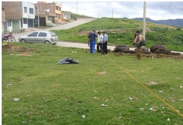
Figura 1. Localización y replanteo del lote.
