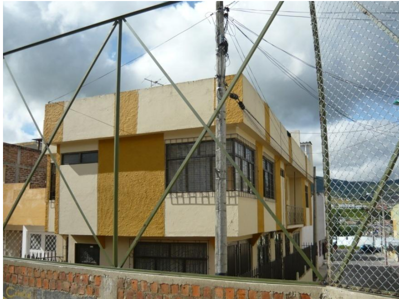
Figura 67. Instalación del cerramiento de protección.
