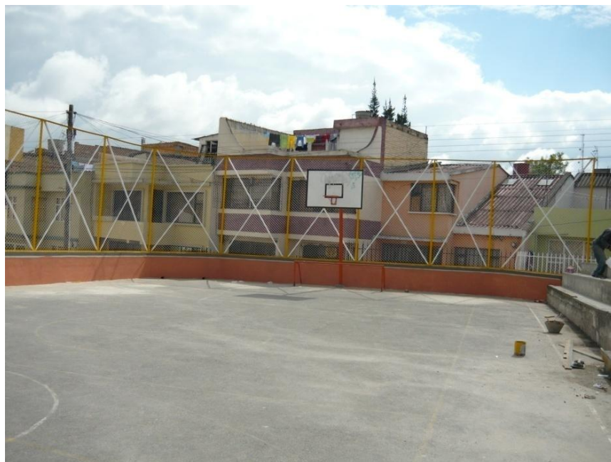
Figura 72. Muros y cerramiento pintado en su totalidad.
