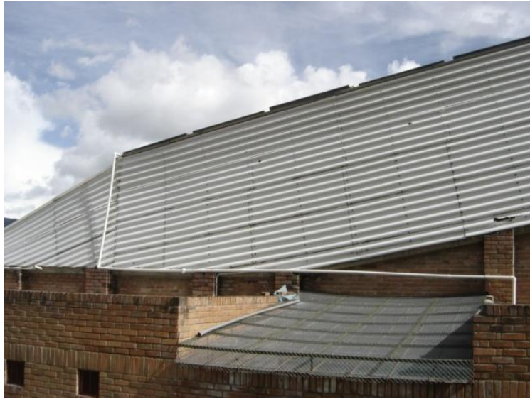
Figura 50. Red de tubería en PVC de 2" instalada.
