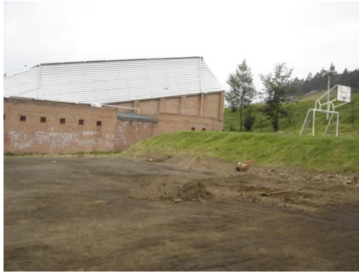
Figura 48. Terreno con base compactada.
