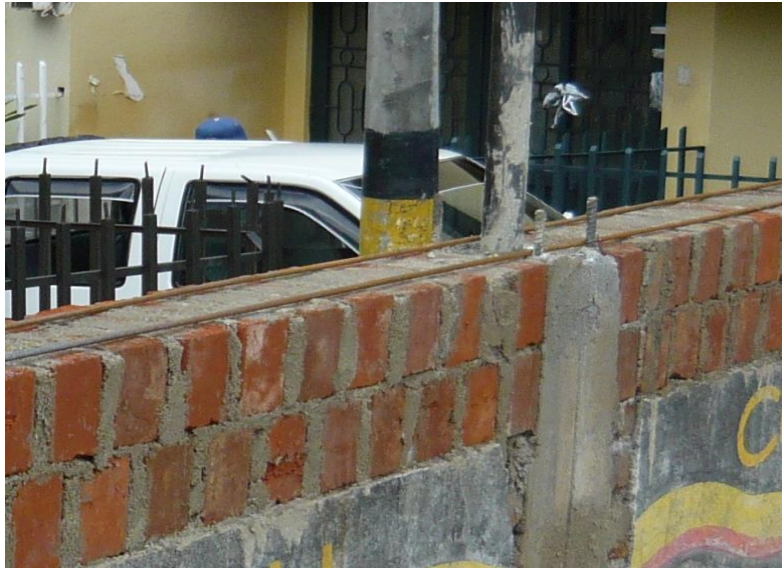
Figura 65. Colocación del refuerzo para la alfajía.
