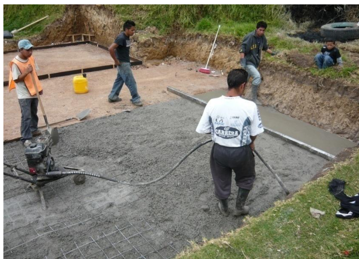
Figura 9. Proceso de fundición de la losa.
