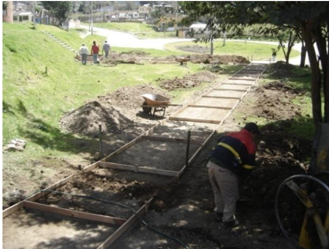
Figura 42. Encofrado del andén.
