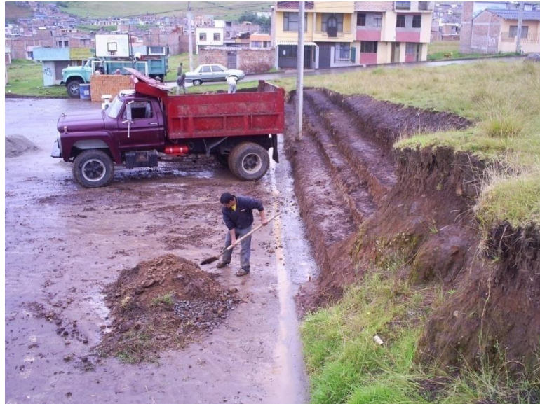
Figura 76. Excavación y conformación de las graderías y su cimentación.
