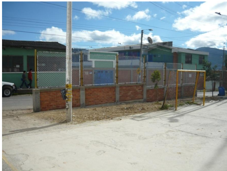
Figura 105. Cerramiento terminado en la zona del CAI
