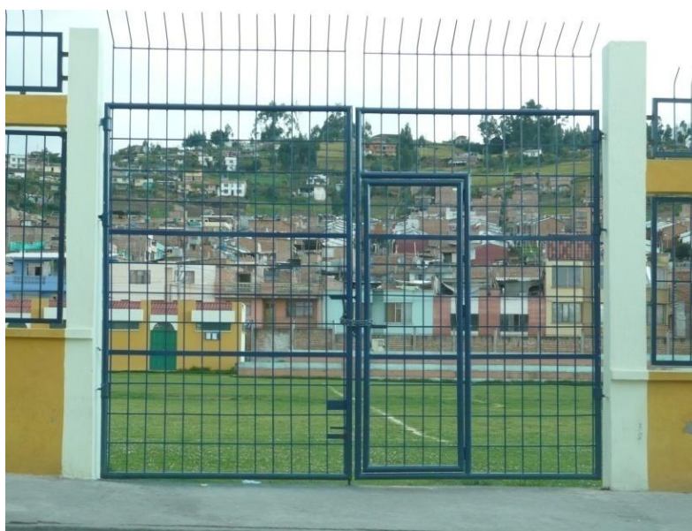
Figura 93. Puerta adecuada y pintada.
