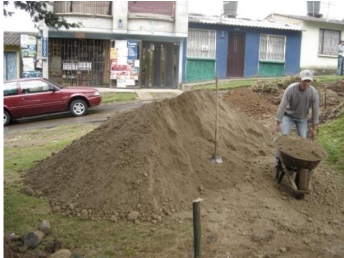
Figura 40. Regado de la base para los andenes.
