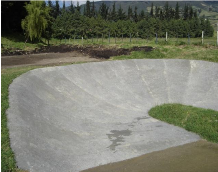
Figura 34. Obra terminada en la curva 3.
