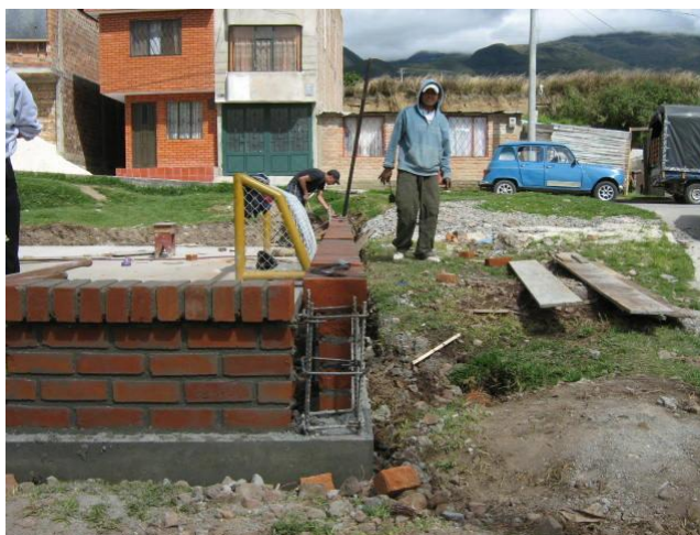
Figura 16. Muro de cerramiento.
