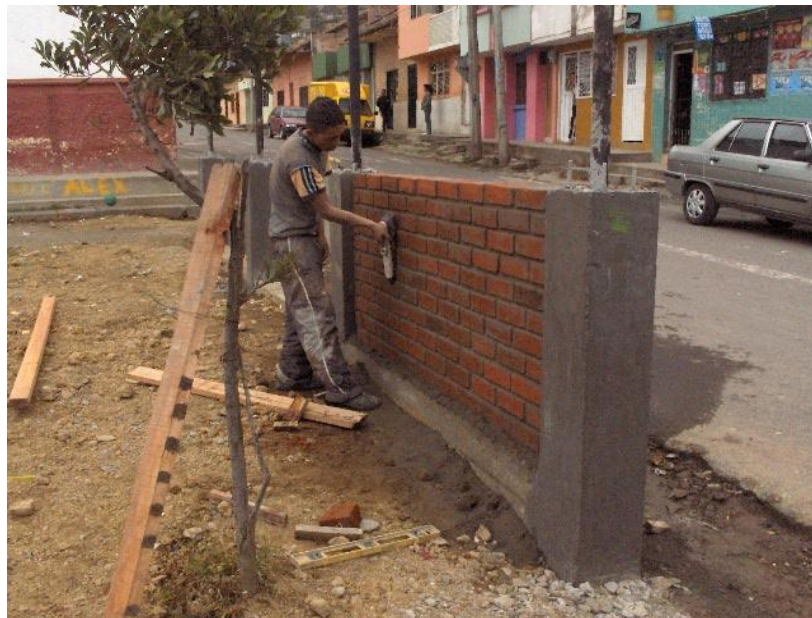
Figura 103. Limpieza del ladrillo después de pegado.
