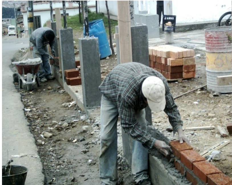
Figura 102. Construcción de los muros del cerramiento.
