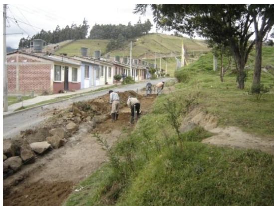
Figura 39. Excavación para andenes.
