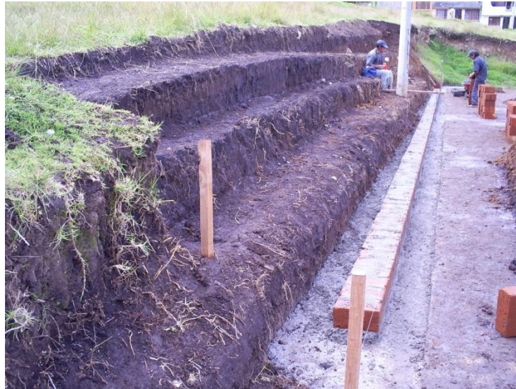
Figura 78. Base de las graderías y cuneta fundida.
