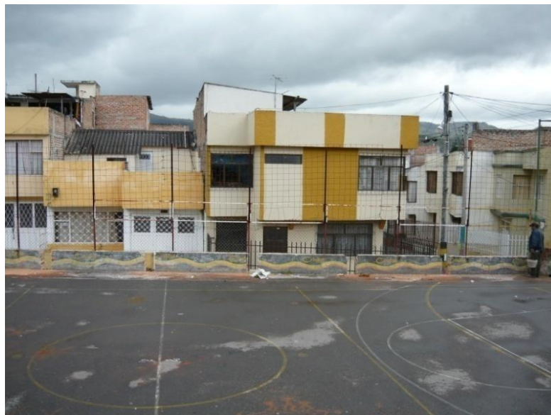
Figura 58. Espacios demolidos para las columnas.
