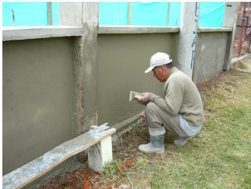
Figura 89. Aplicación de mortero 1:4 a los muros.
