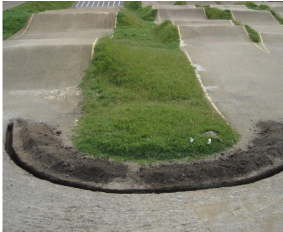
Figura 23. Excavación para viga
