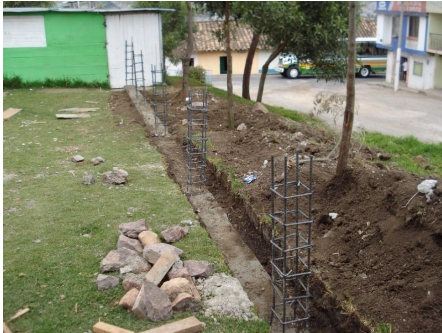
Figura 100. Armado del refuerzo de las columnas.
