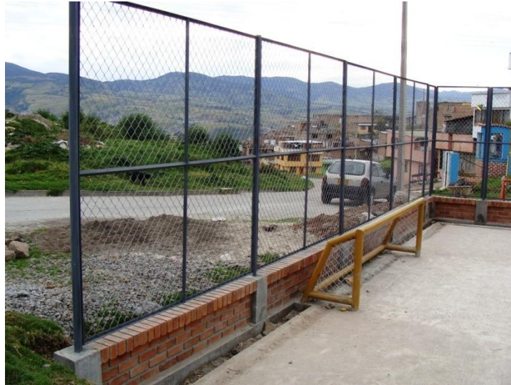
Figura 19. Malla de protección instalada.
