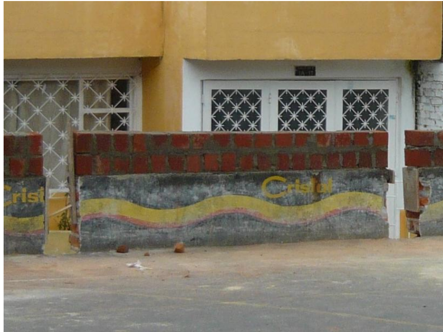
Figura 59. Construcción del muro en tizón H=0.3 m.
