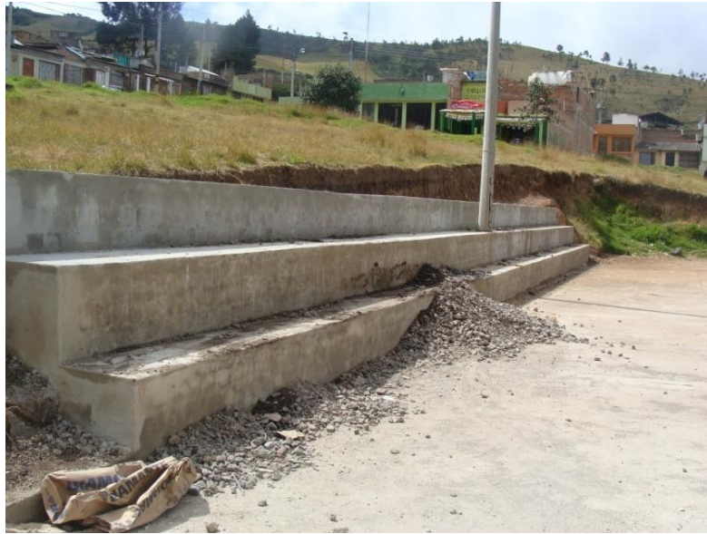
Figura 80. Graderías repelladas y terminadas.
