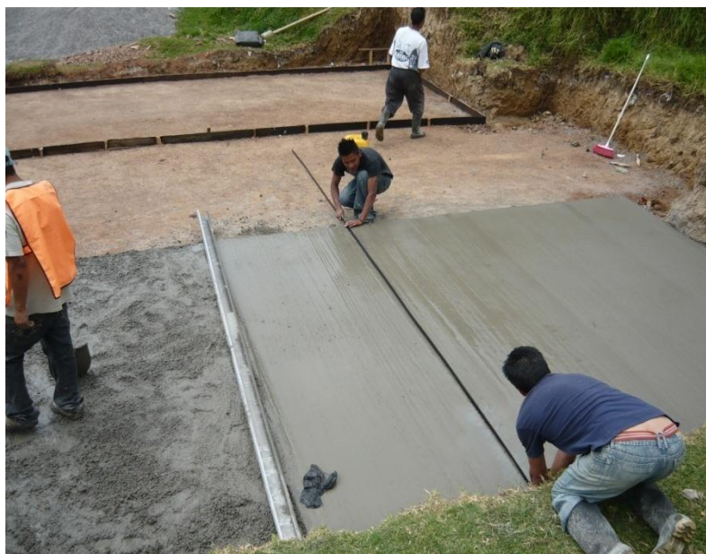
Figura 11. Colocación de platinas para formar las juntas transversales.
