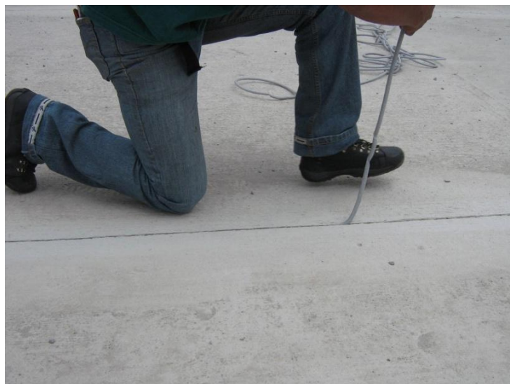
Figura 18. Colocación de la junta de expansión.
