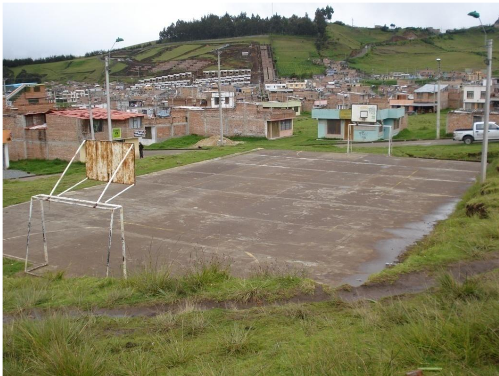
Figura 75. Estado inicial del polideportivo.
