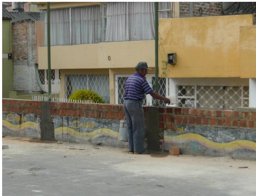
Figura 64. Proceso de curado del concreto en las columnas.
