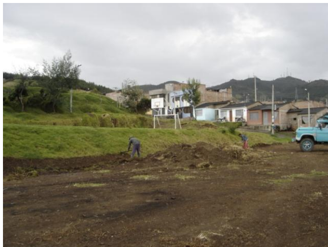
Figura 47. Labores de descapote y excavación del terreno.
