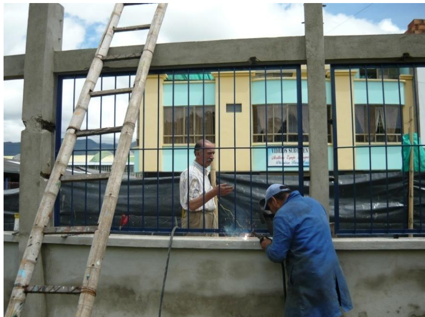
Figura 91. Instalación de rejas del cerramiento.
