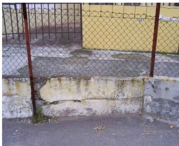
Figura 56. Estado inicial del polideportivo.
