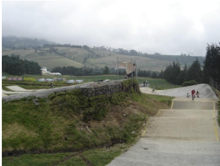
Figura 26. Ubicación del muro en gaviones.
