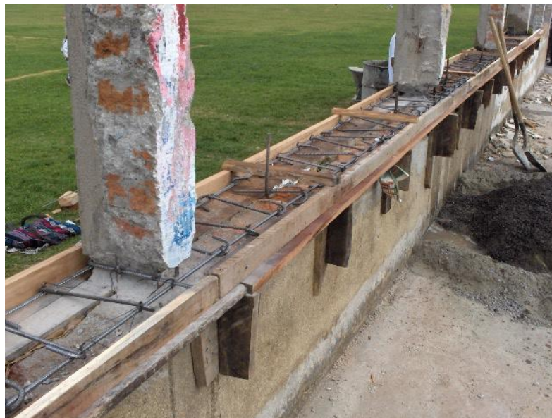
Figura 87. Alfajía encofrada y con refuerzo.
