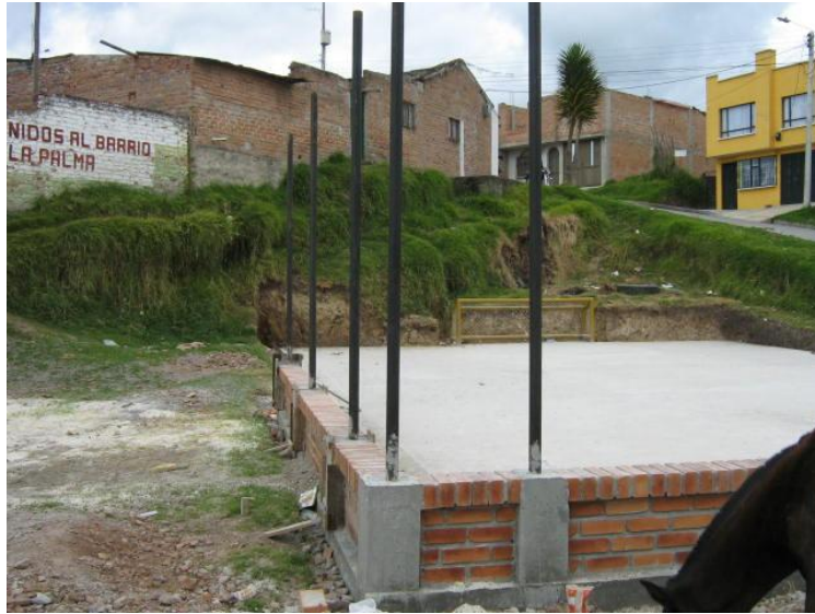
Figura 17. Tubos empotrados en las columnas.
