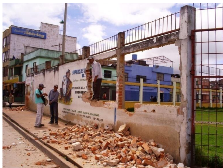
Figura 85. Inicio del proceso de demolición.
