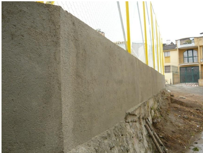
Figura 68. Repello de los muros internos y externos al polideportivo.
