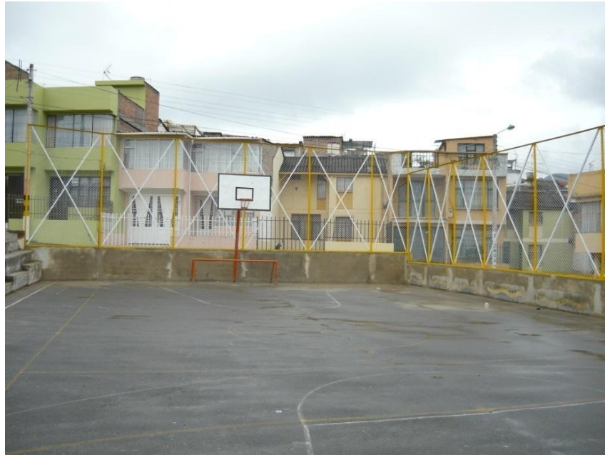
Figura 71. Cerramiento metálico pintado en su totalidad.
