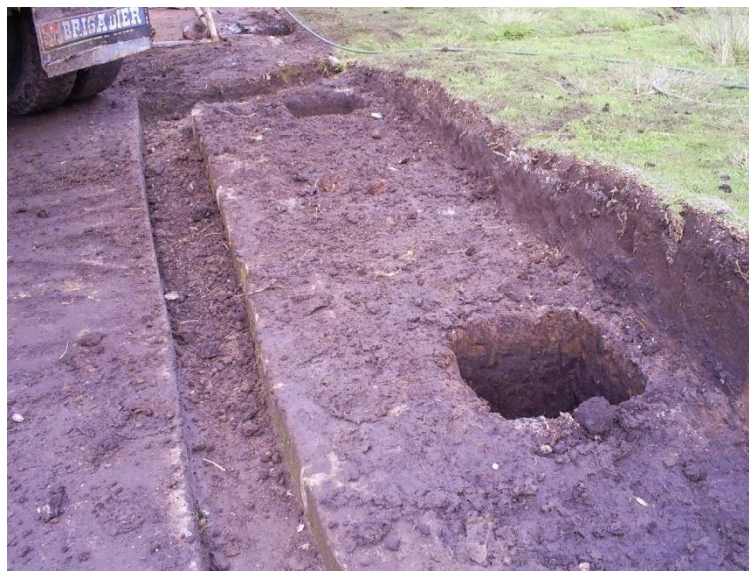
Figura 77. Excavación para cunetas y los dados de concreto.
