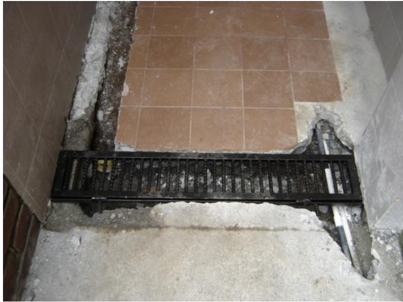
Figura 54. Proceso de instalación de la rejilla.
