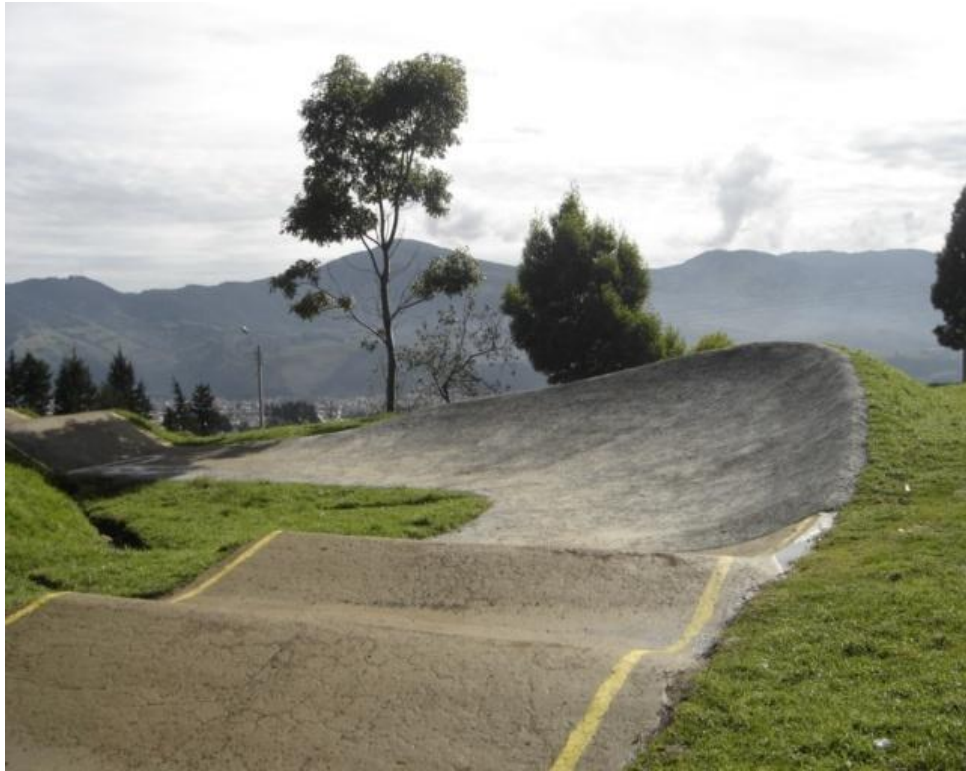
Figura 36. Obra terminada en la curva 5.
