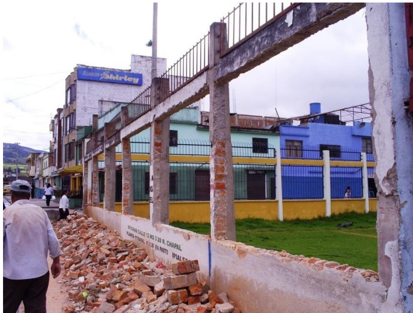
Figura 86. Proceso de demolición terminado.
