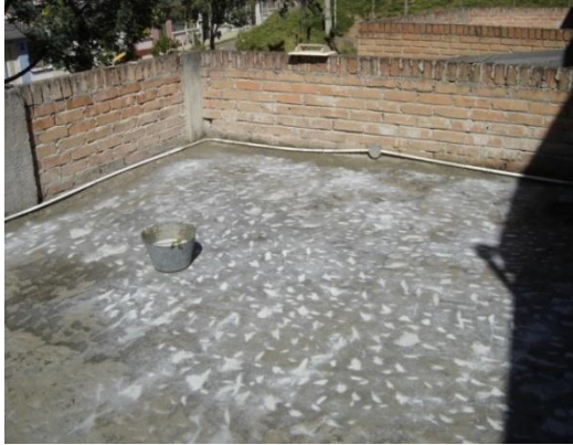
Figura 45. Puente de adherencia.
