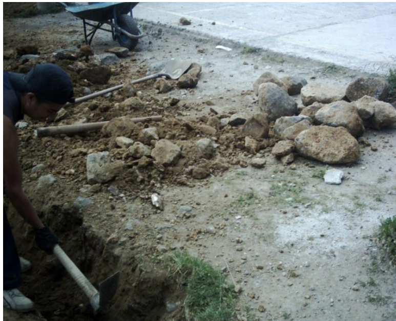
Figura 97. Material extraído de la excavación.
