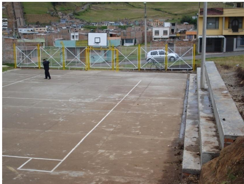
Figura 83. Polideportivo adecuado y terminadas las obras.
