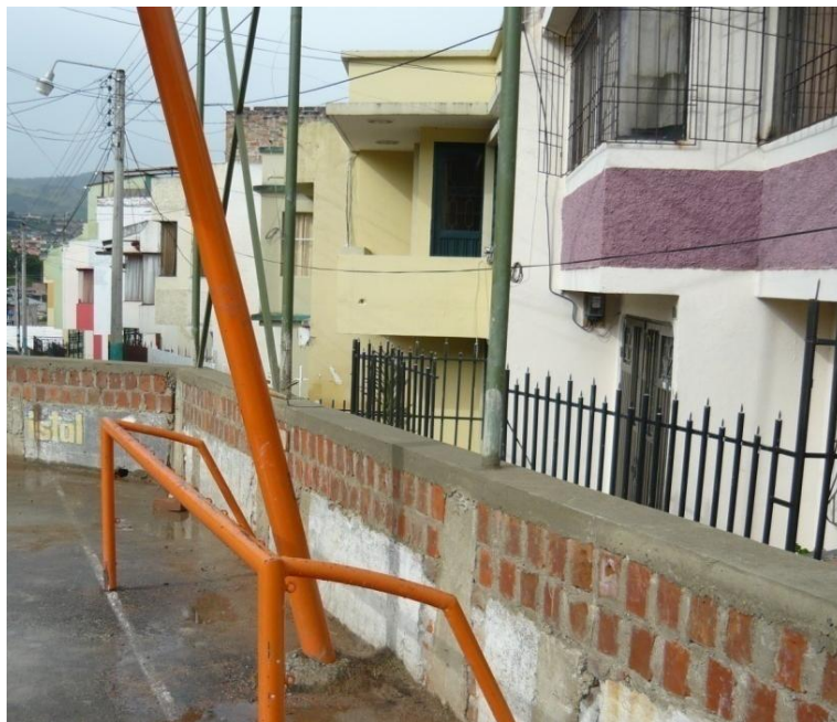
Figura 66. Alfajía fundida y terminada.
