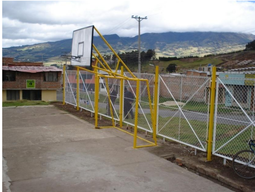
Figura 82. Cerramiento instalado y canchas pintadas y arregladas.
