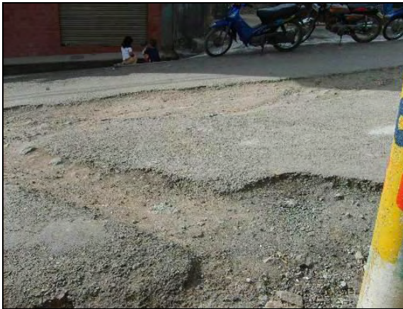
Foto 44: Zanjas en la vía principal.
