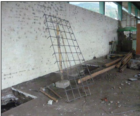
Foto 39: Parrillas para zapata.
