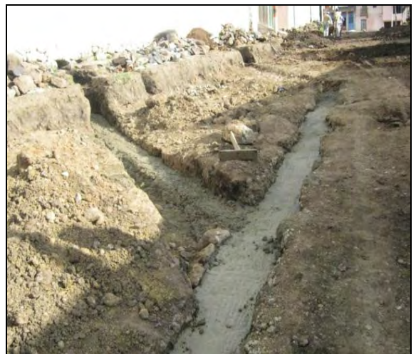
Foto 81: Estado final de la actividad realizada.
