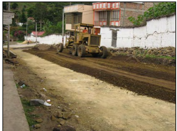
Foto 89: Extendida del material para la base.
