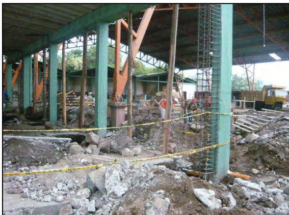
Foto 29: Demolición piso y cerramiento preventivo.
