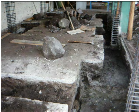
Foto 31. Excavación para zapatas y vigas de cimentación.
