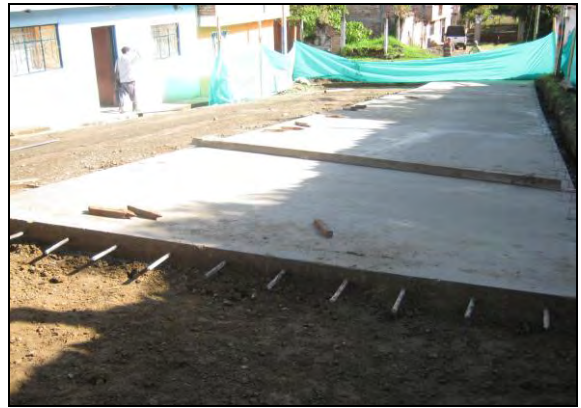
Foto 107: Al finalizar cada fundición se termina en paño completo.
