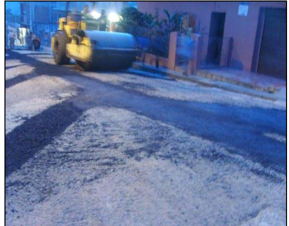
Foto 61: Fin de la pavimentación.
