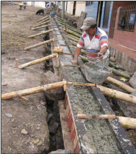
Foto 86: Colocación del concreto variando la altura libre con el nivel vial.
