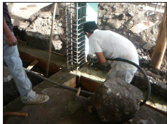
Foto 36: Construcción de vigas de cimentación.
