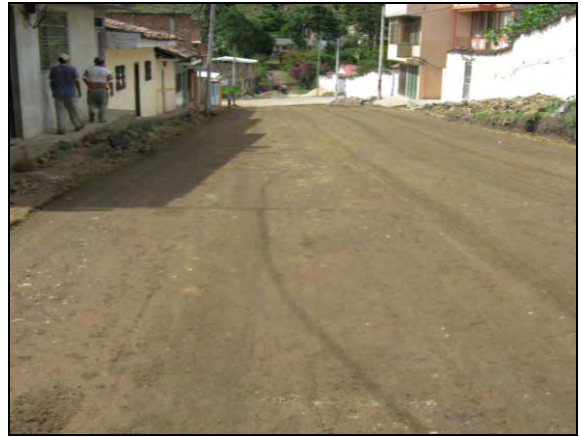
Foto 91: Instalación de la base granular terminada.
