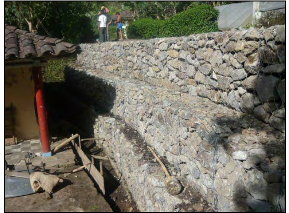
Foto 67: Terminado tercera hilera.
