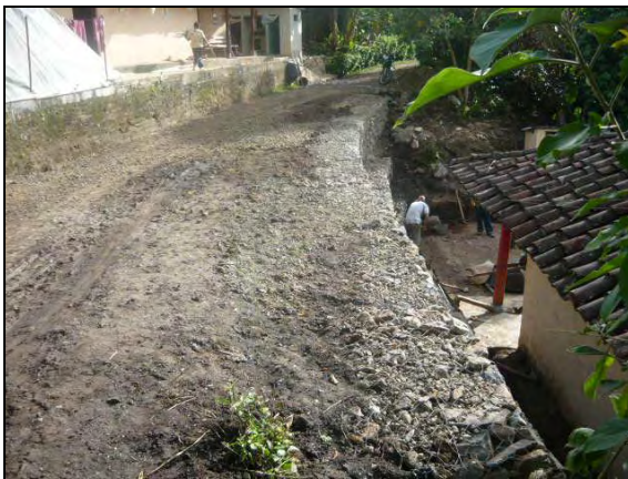
Foto 68: Ampliación de la banca.
