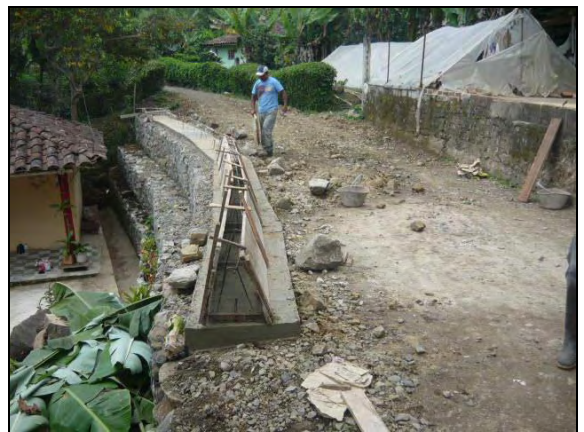
Foto 69: Construcción sardinel anclado.
