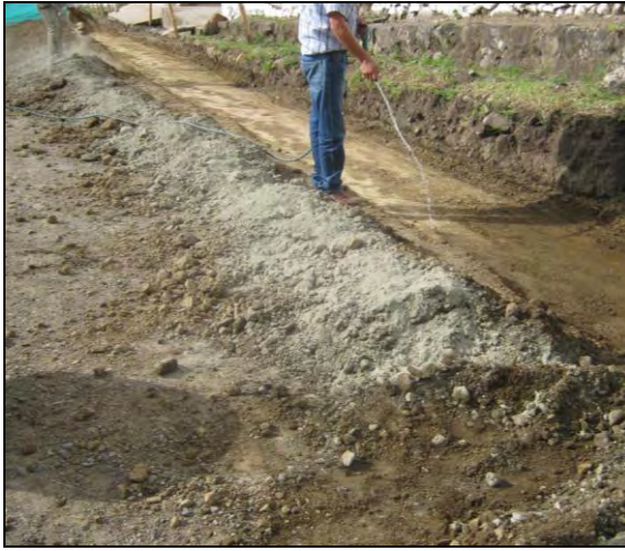
Foto 94: Humedecimiento del área y mejora con mezcla suelo-cemento.
