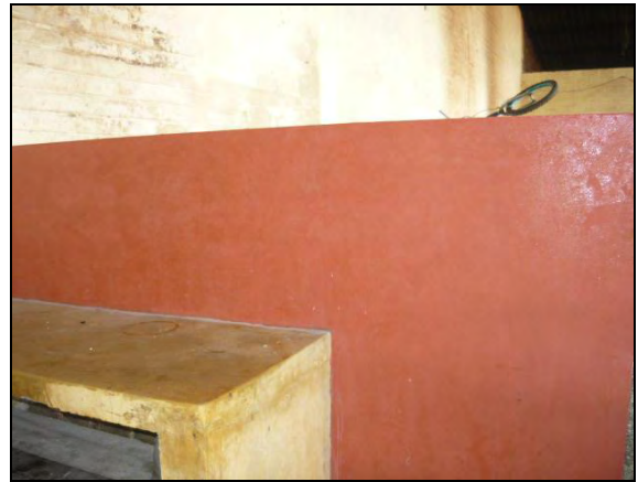
Foto 28: Terminado de muros divisorios aplicando color mineral.
