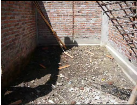
Foto 21: Evacuación de escombros.
