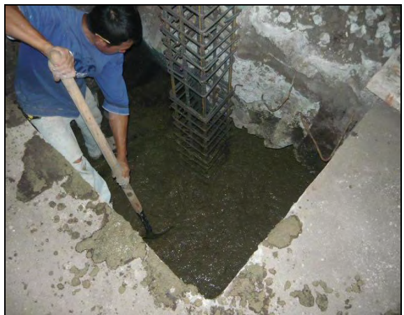
Foto 34: Colocación de solado.
