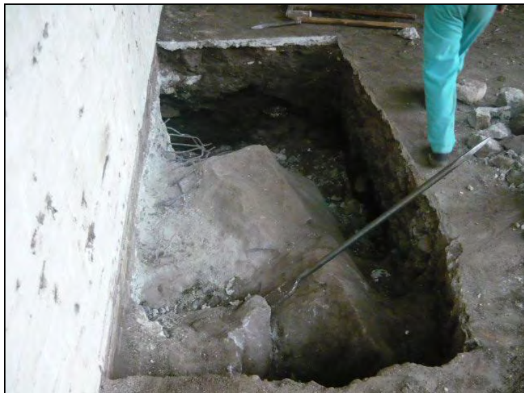
Foto 41. Demolición de piedra.
