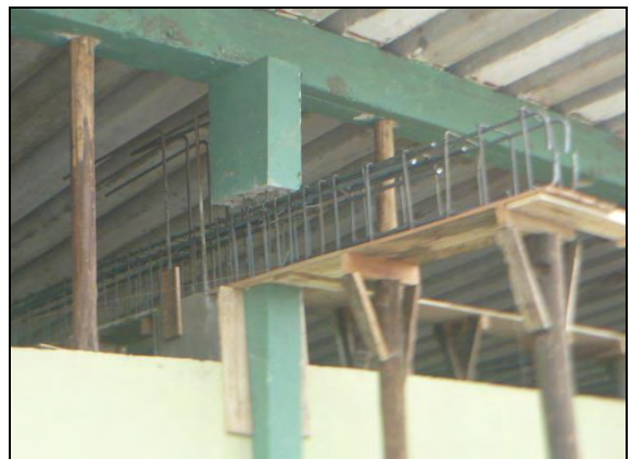
Foto 30: Demolición de columnas para prolongación de vigas.
