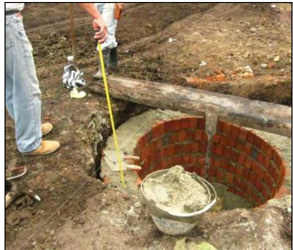
Foto 77: Chequeo de alturas y desniveles.
