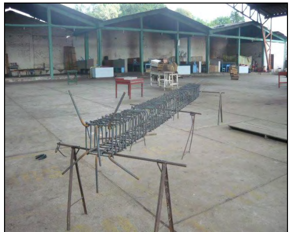
Foto 40: Armado de acero de refuerzo para columnas.
