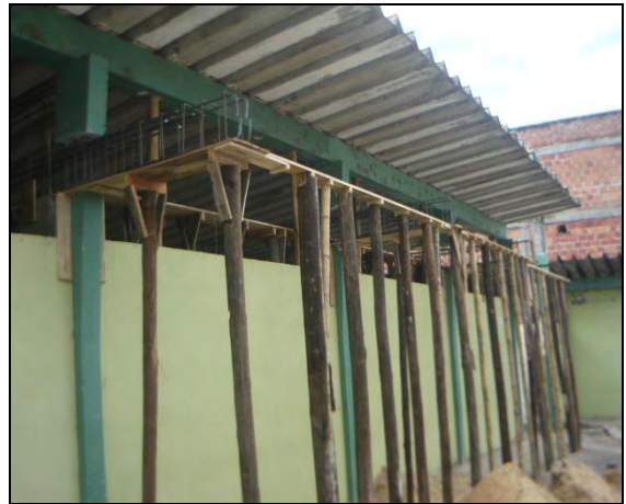
Foto 38: Apuntalamiento viga de borde
