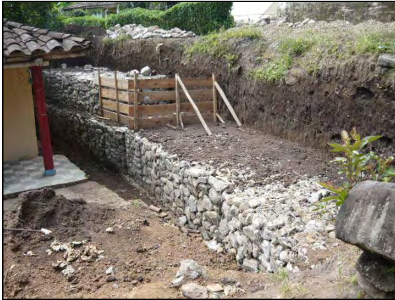
Foto 66: Colocación segunda hilera.
