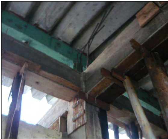
Foto 37: Construcción de vigas de entrecimso y aéreas.
