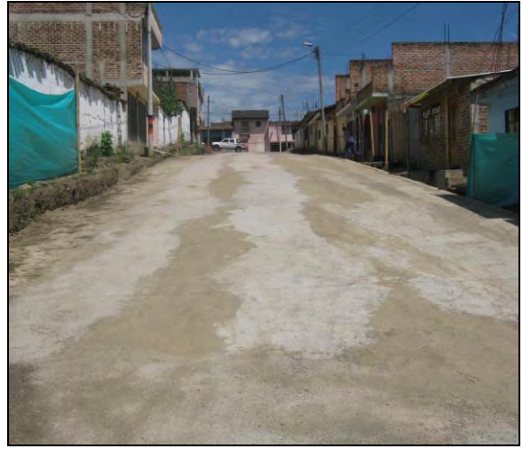
Foto 95: Estado final de la base con mezcla suelo-cemento.
