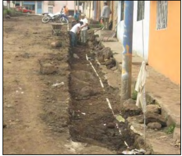
Foto 75: Excavación para muro de confinamiento.
