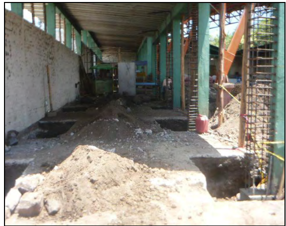
Foto 32. Material seleccionado para relleno.
