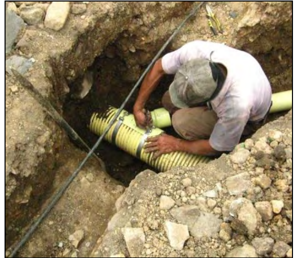
Foto 79: Instalación de las sillas yee para la conexión.
