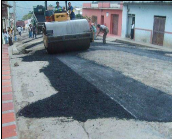
Foto 60: Acabado del pavimento.
