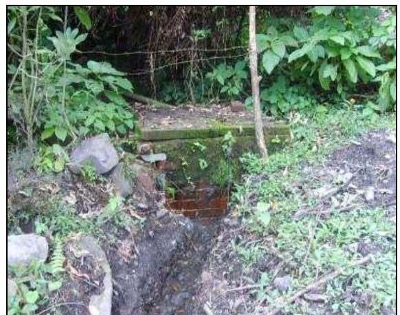
Foto 12: Adecuación de tanque.
