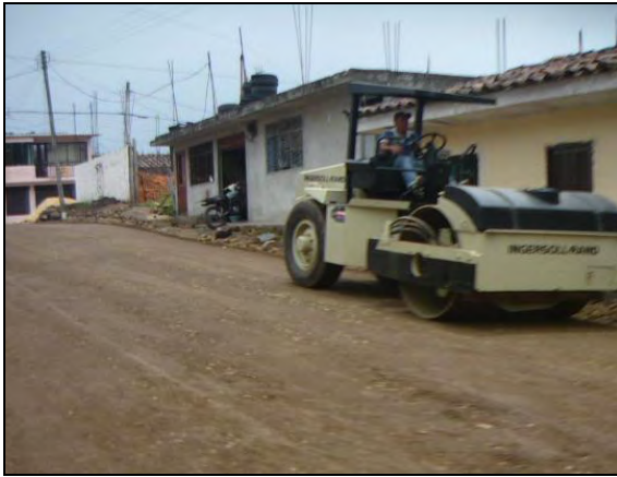
Foto 90: Compactación de la base.
