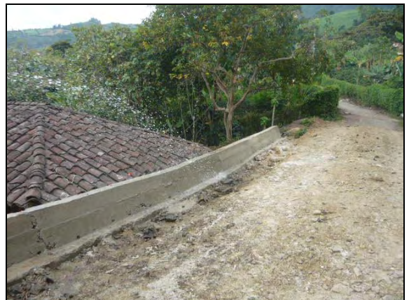
Foto 71: Estado final de la vía.
