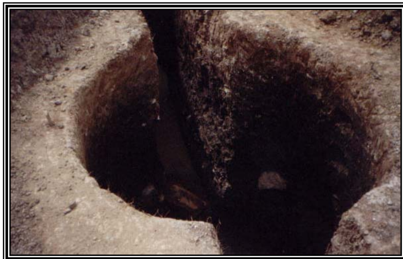
Figura 12. Excavación para cámara de inspección
