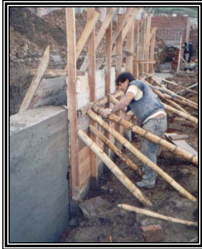
Figura 67. Desencofrado de muro de contención
