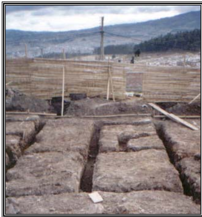
Figura 30. Excavaciones para cimentación de viviendas
