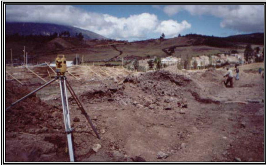
Figura 29. Localización y replanteo
