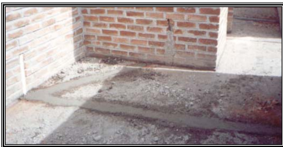
Figura 60. Relleno de regata con mortero de pega
