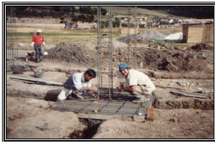
Figura 40. Amarre de los pelos de la columna a la parrilla de la zapata
