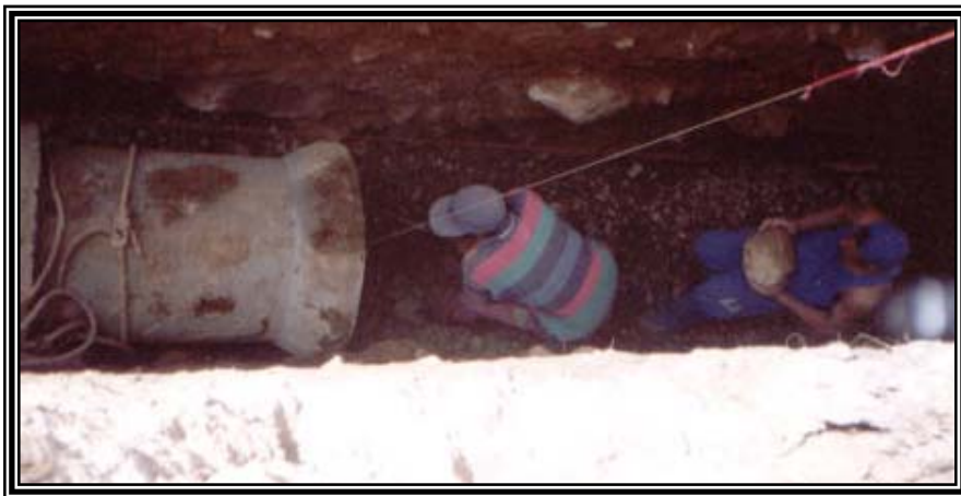
Figura 26. Verificación del eje del tubo
