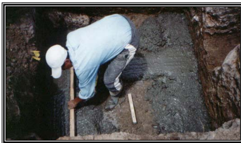
Figura 38. Puesta en obra del solado de zapata
