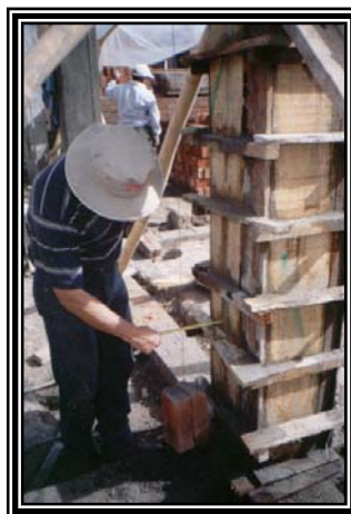
Figura 45. Verificación del plomo de la columna
