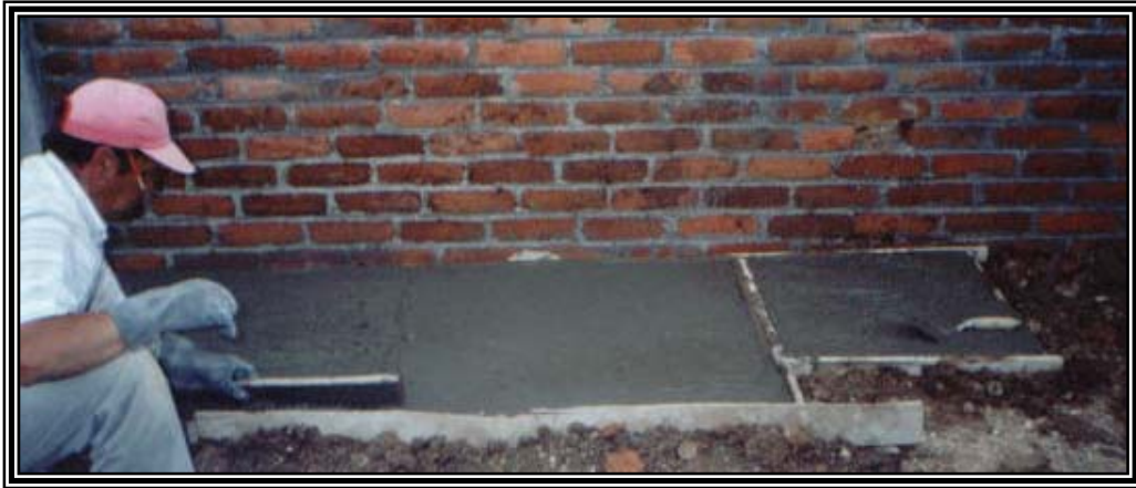
Figura 54. Fundición de tapas para cámaras de inspección
