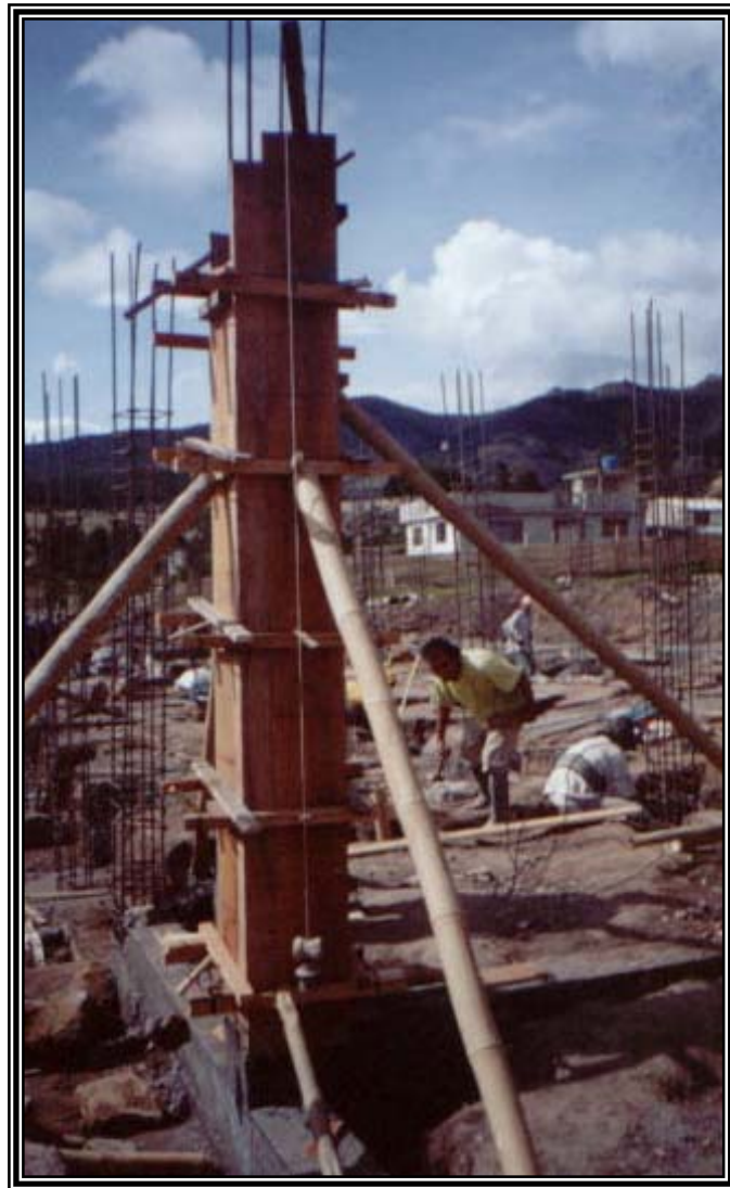
Figura 43. Formaleta de columna apuntalada
