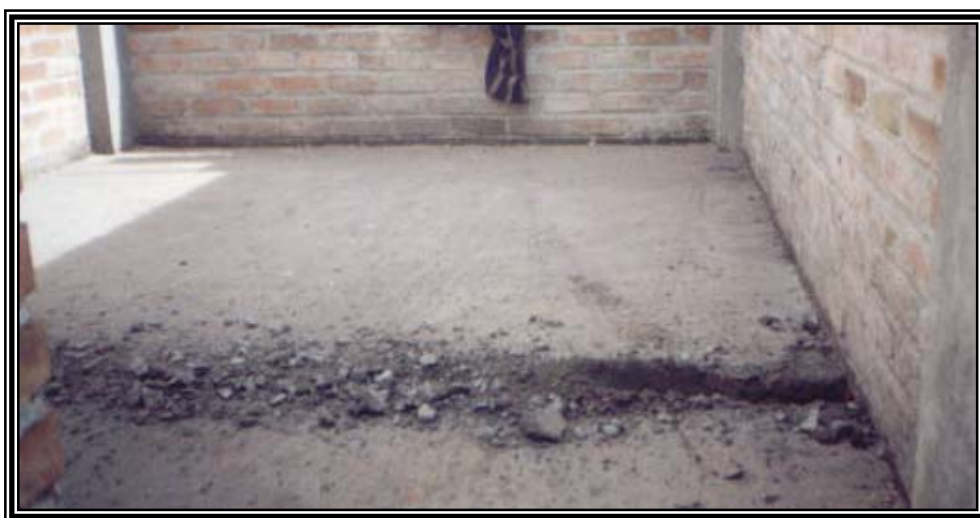
Figura 61. Regata en la losa de piso
