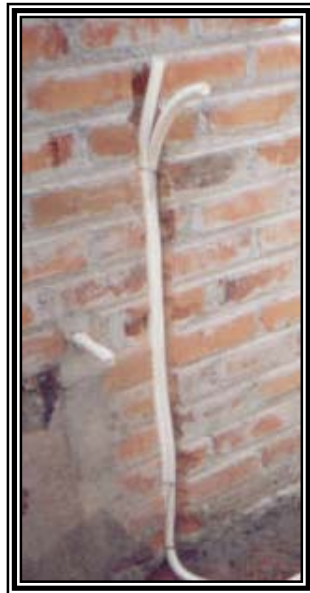
Figura 59. Regata con instalación eléctrica
