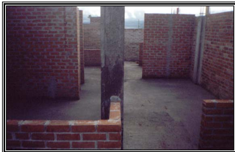
Figura 63. Vivienda con primera planta terminada
