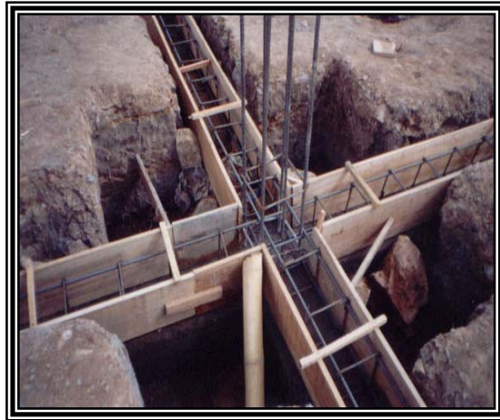
Figura 35. Intersección de vigas de cimentación con columna
