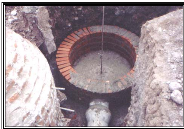
Figura 13. Cámara en construcción
