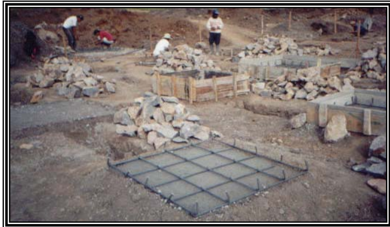
Figura 39. Emparrillado de la zapata
