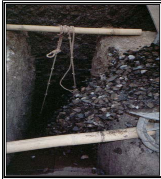
Figura 18. Colocación del triturado en la excavación
