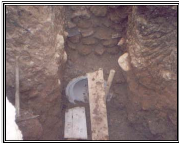
Figura 28. Relleno compactado del tramo
