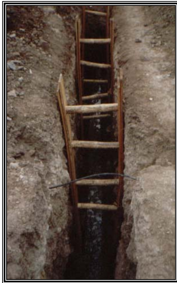
Figura 10. Entibado de excavaciones superiores a 2.6 Mts
