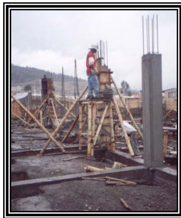
Figura 44. Vaciado y vibrado de columnas
