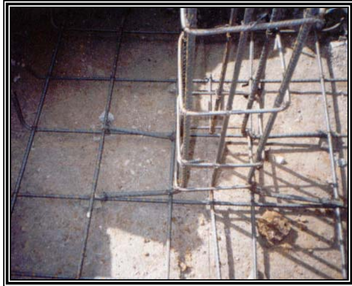
Figura 41. Conjunto del refuerzo de columna y zapata
