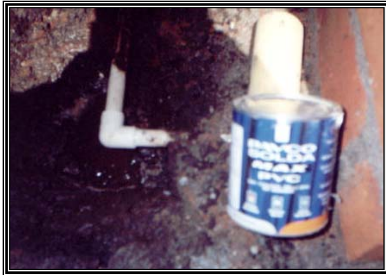
Figura 56. Detalle de tubería y soldadura para su unión
