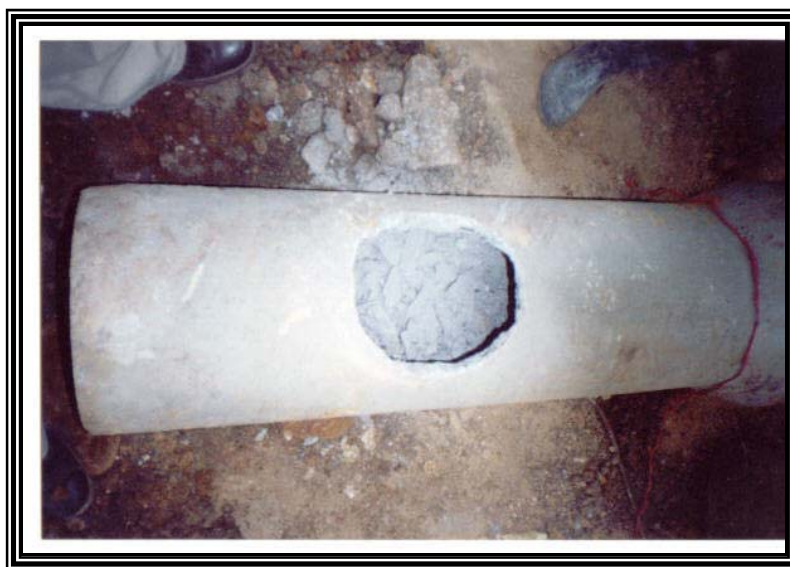
Figura 17. Perforación para aditamento en cámara de caída
