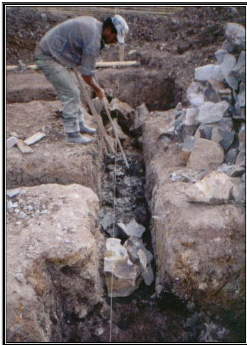
Figura 32. Puesta en obra de concreto ciclópeo
