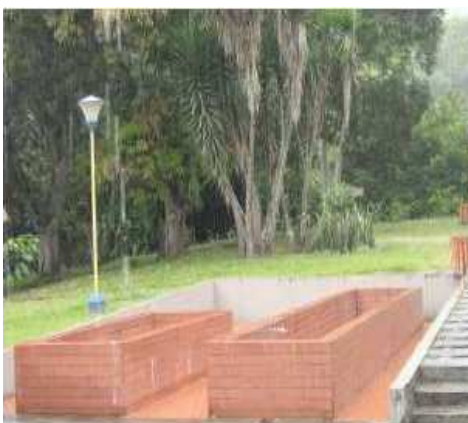
Figura 10. Tanques de inmunizado
