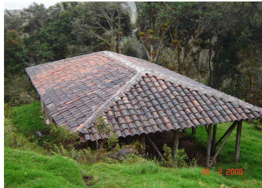
Fotografía 5. Casa embrujada. Abandonada
