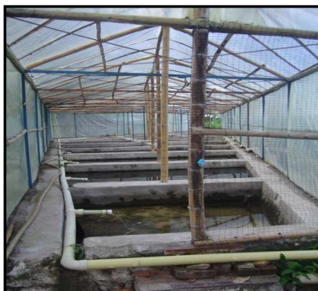
Figura 4. Canaletas en cemento
