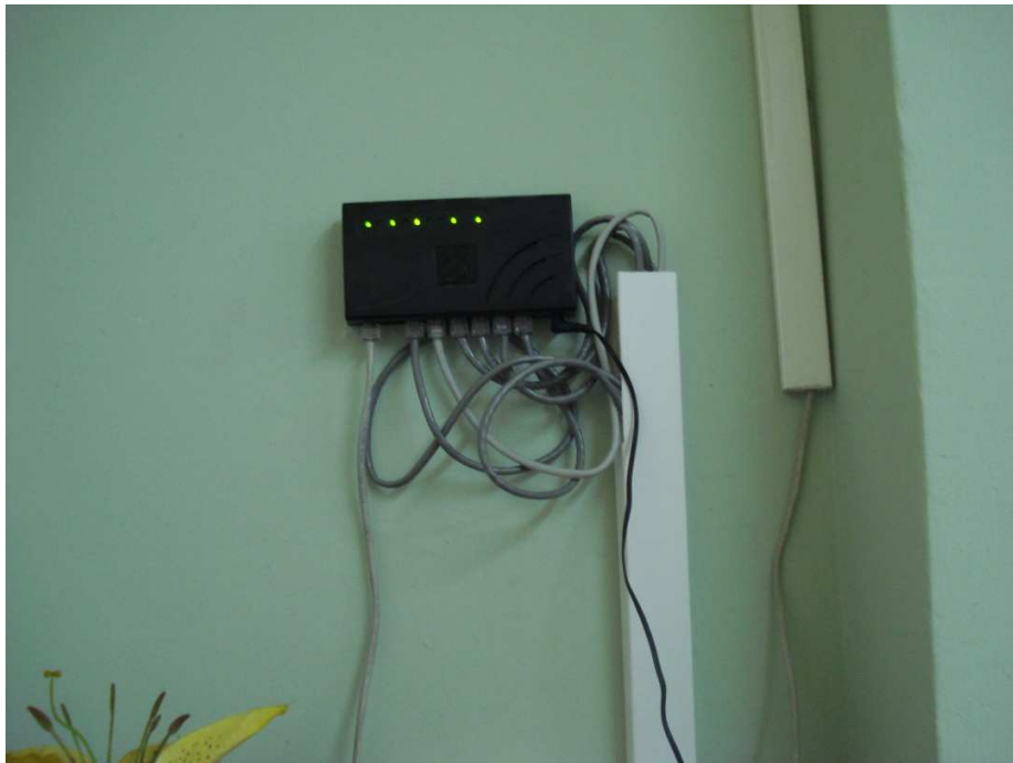
Figura 27. Fotografía Edificio Bienestar Social – Oficina Dirección
