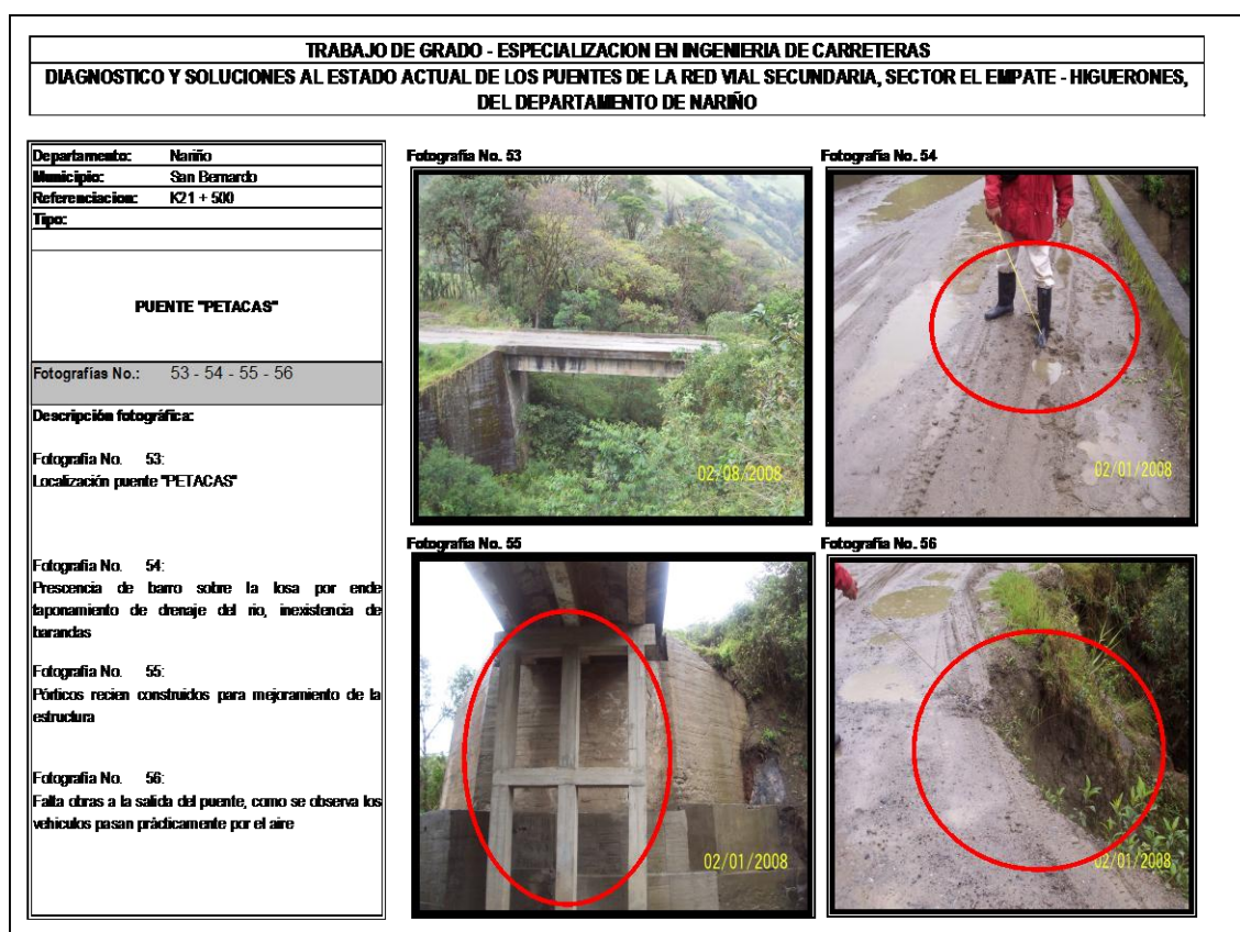
Figura 15. Registro fotográfico puente Petacas
