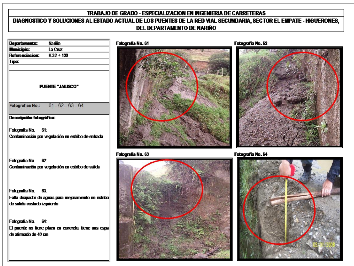
Figura 17. Registro fotográfico puente Jalisco
