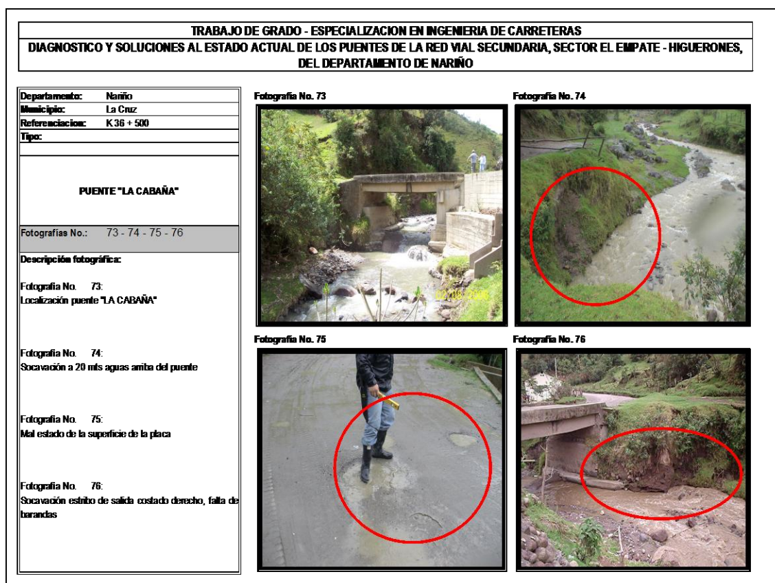
Figura 20. Registro fotográfico puente La Cabaña
