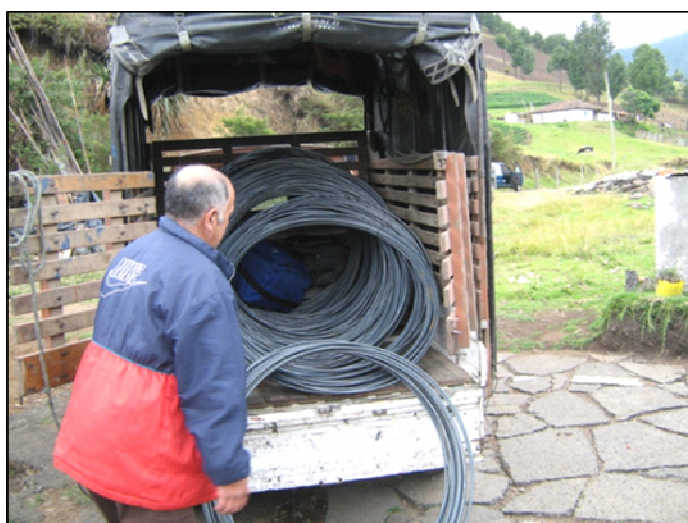
Figura 37. Llegada de acero de refuerzo de 3/8"
