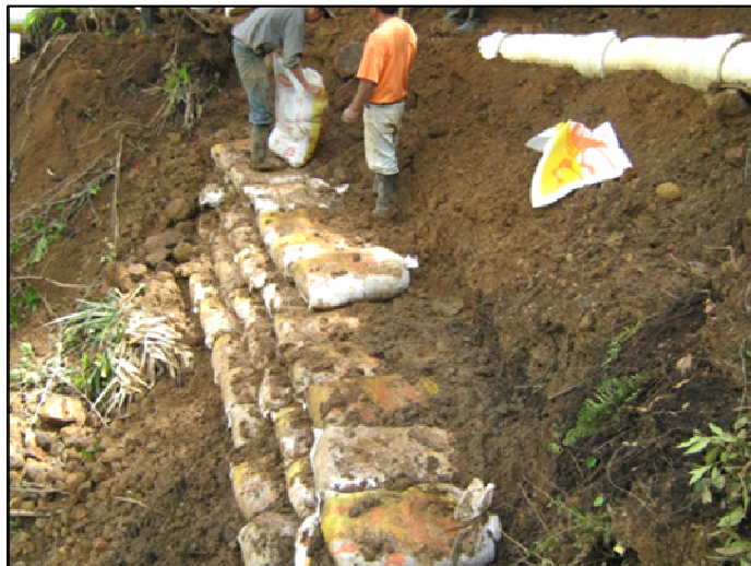
Figura 49. Terraplén con sacas de arena K1+235.38
