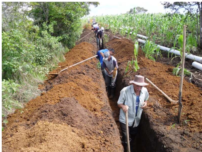
Figura 30. Excavaciones para tubería de 12”
