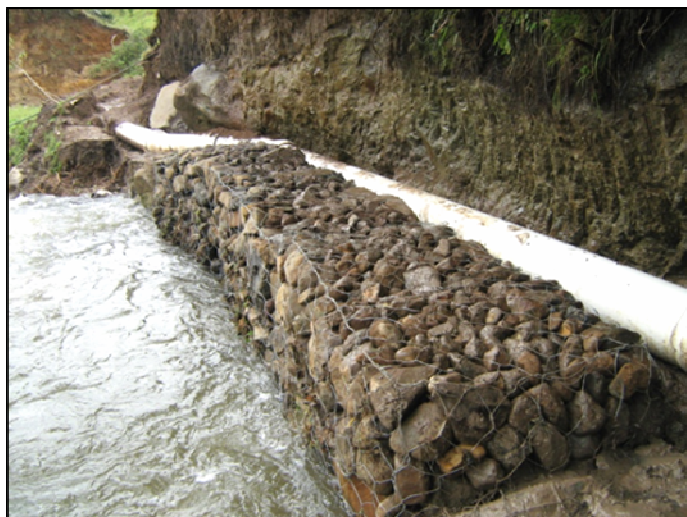
Figura 48. Muro en gavión en K0+046.30
