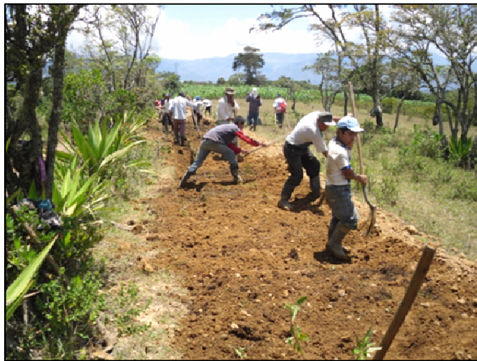
Figura 35. Relleno de excavación
