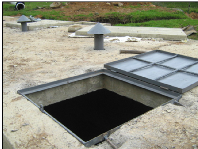
Figura 24. Instalación tapas de acceso y conos de ventilación
