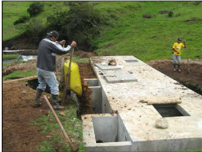
Figura 25. Relleno en el perímetro del desarenador
