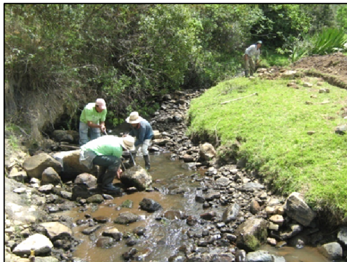
Figura 4. Retiro de piedras de área de bocatoma
