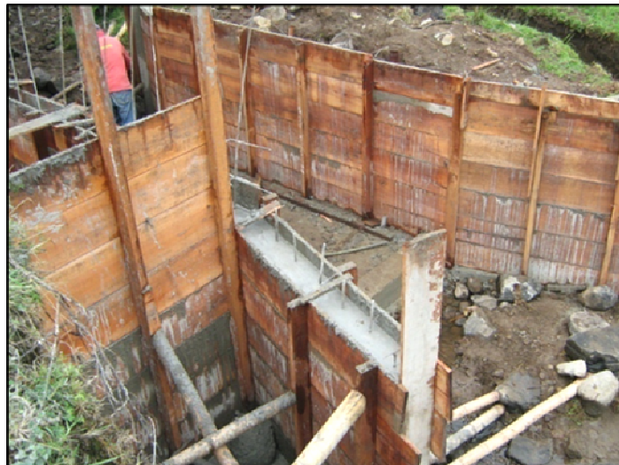
Figura 5. Fundición de aletas
