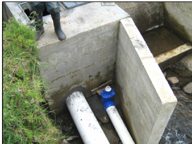
Figura 8. Instalación de válvula de lavado
