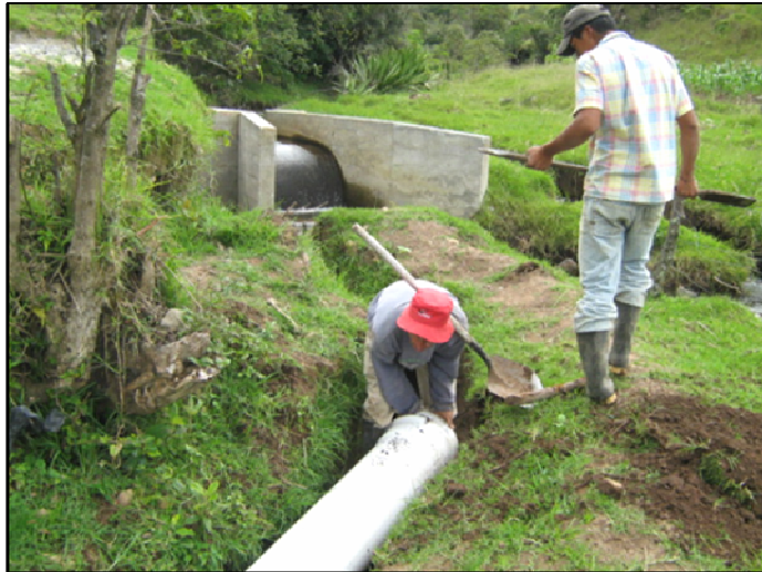
Figura 28. Instalación de tubería en aducción
