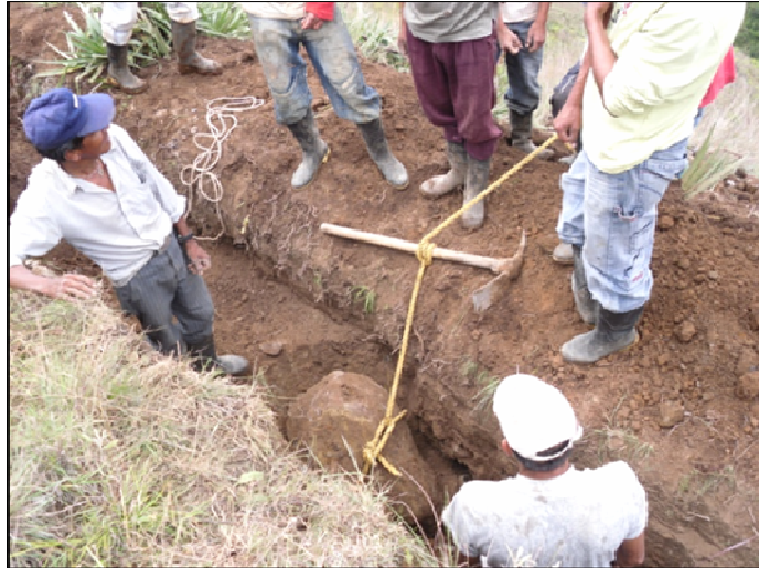
Figura 26. Extracción de rocas en la excavación de la aducción
