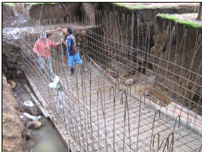
Figura 15. Armado de parrilla inferior y muros
