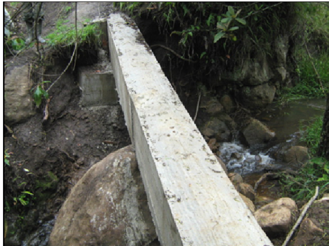
Figura 47. Viaducto en concreto reforzado en K0+817.45
