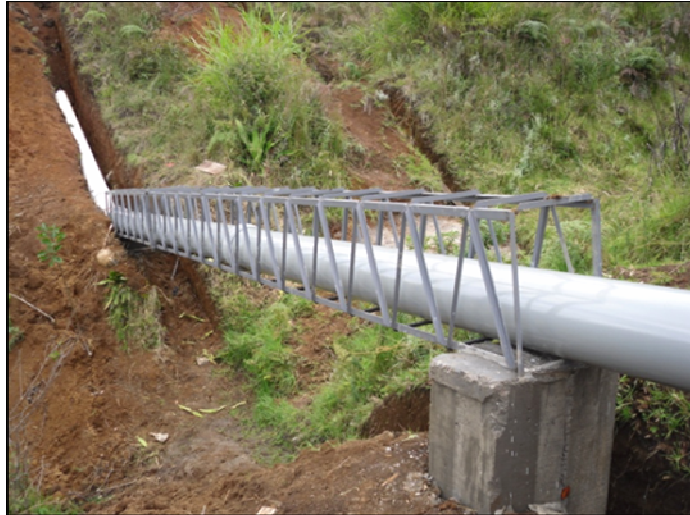
Figura 50. Viaducto en cercha metálica K3+258.92
