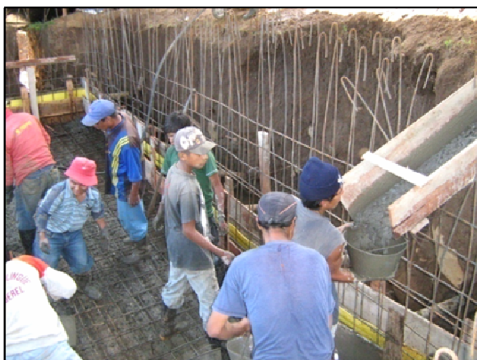
Figura 16. Fundición de desarenador - Fase 1
