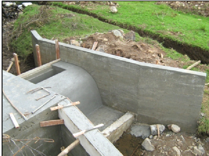
Figura 6. Fundición de presa
