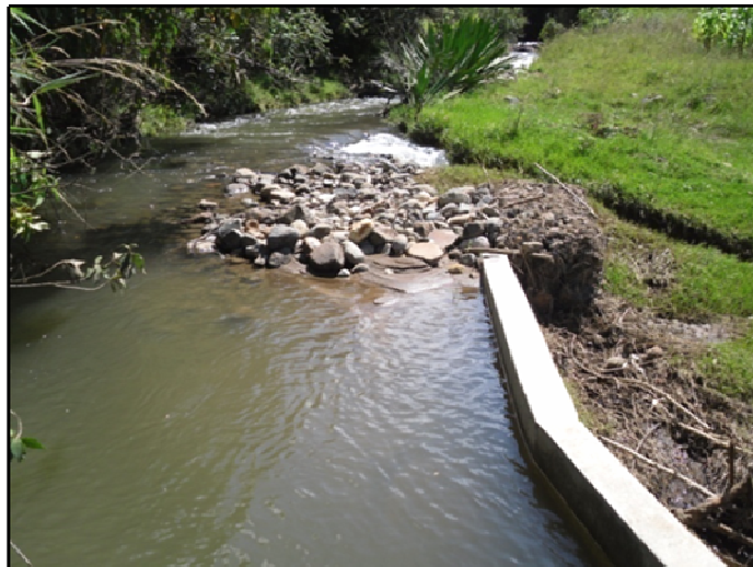
Figura 9. Ampliación para correcto encausamiento
