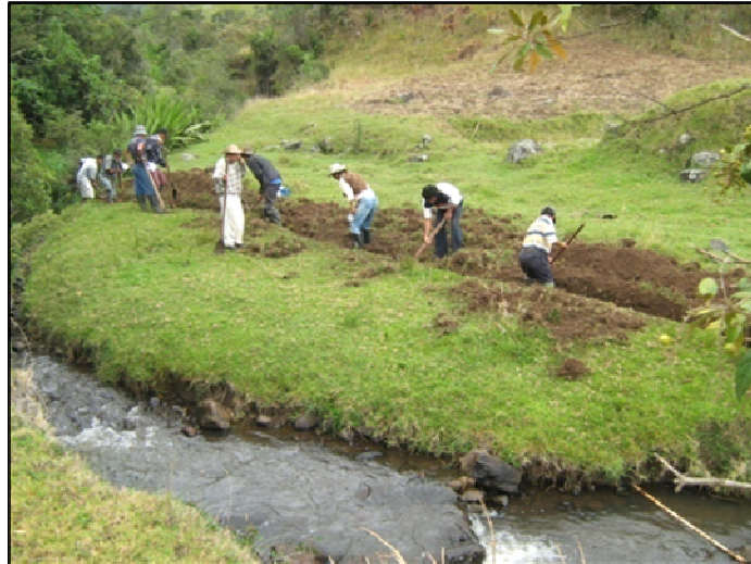
Figura 3. Excavación para desvío de Quebrada Meneses
