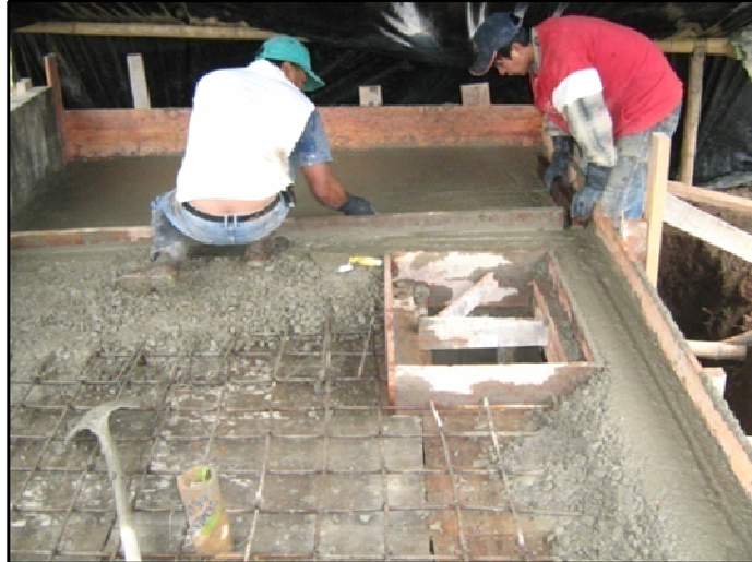
Figura 18. Fundición de desarenador - Fase 3
