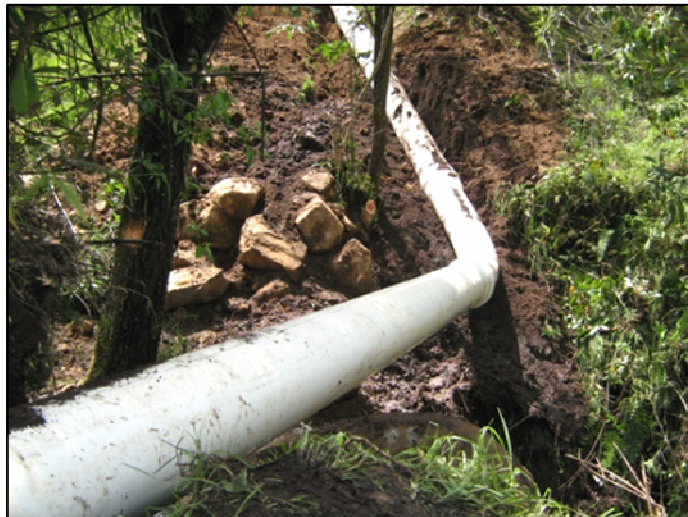
Figura 46. Paso elevado en K0+817.45
