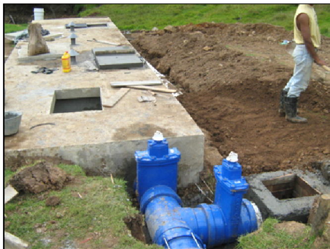
Figura 29. Revoque en la entrada al desarenador
