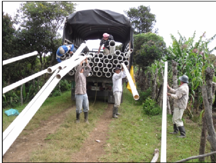
Figura 41. Almacenamiento de tubería
