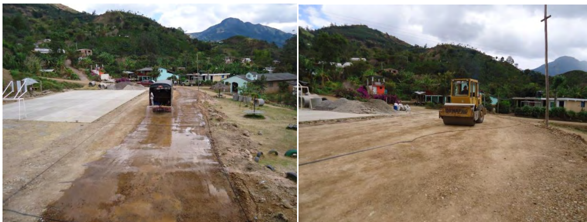
Figura 8. Proceso de compactación. Construcción cancha de “chaza”, en la Vereda “La Comunidad”, en el Municipio de San Pedro de Cartago, Departamento de Nariño.
