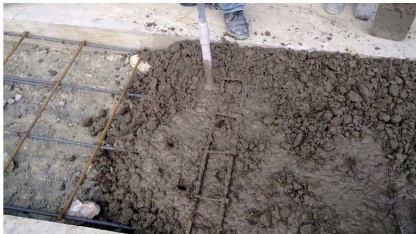
Figura 20. Vibrado y fundido de placa huella. Mantenimiento y mejoramiento de la vía Martín - La Estancia, en el Municipio de San Pedro de Cartago, Nariño
