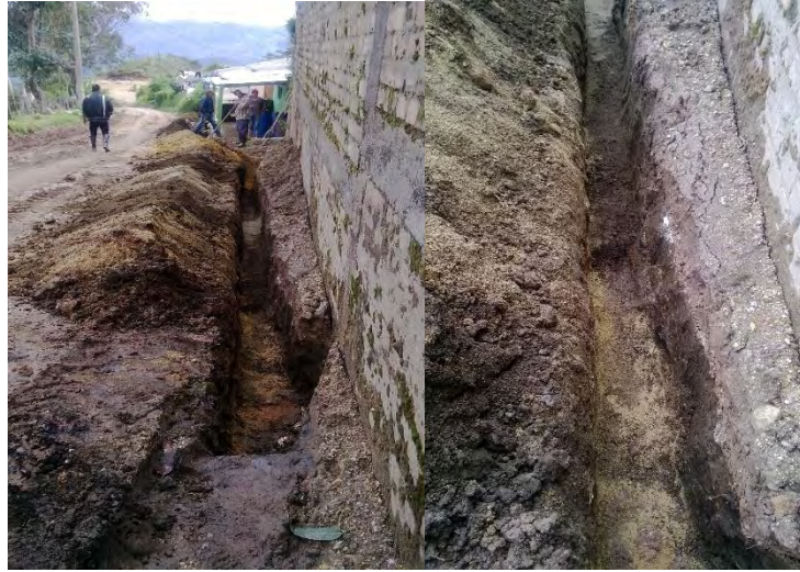
Figura 17. Excavaciones para tubería. Mantenimiento y mejoramiento de la vía Martín - La Estancia, en el Municipio de San Pedro de Cartago, Nariño.
