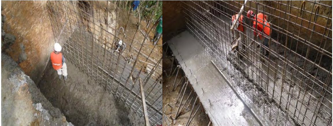
Figura 13. Fundición de Zarpa. Mantenimiento y mejoramiento de la vía Martín - La Estancia, en el Municipio de San Pedro de Cartago, Departamento de Nariño
