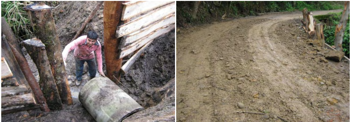
Figura 30. Construcción de un terraplén en la vía que conduce de la cabecera municipal hacia la Vereda “El Salado”, Municipio de San Pedro de Cartago, Departamento de Nariño.
