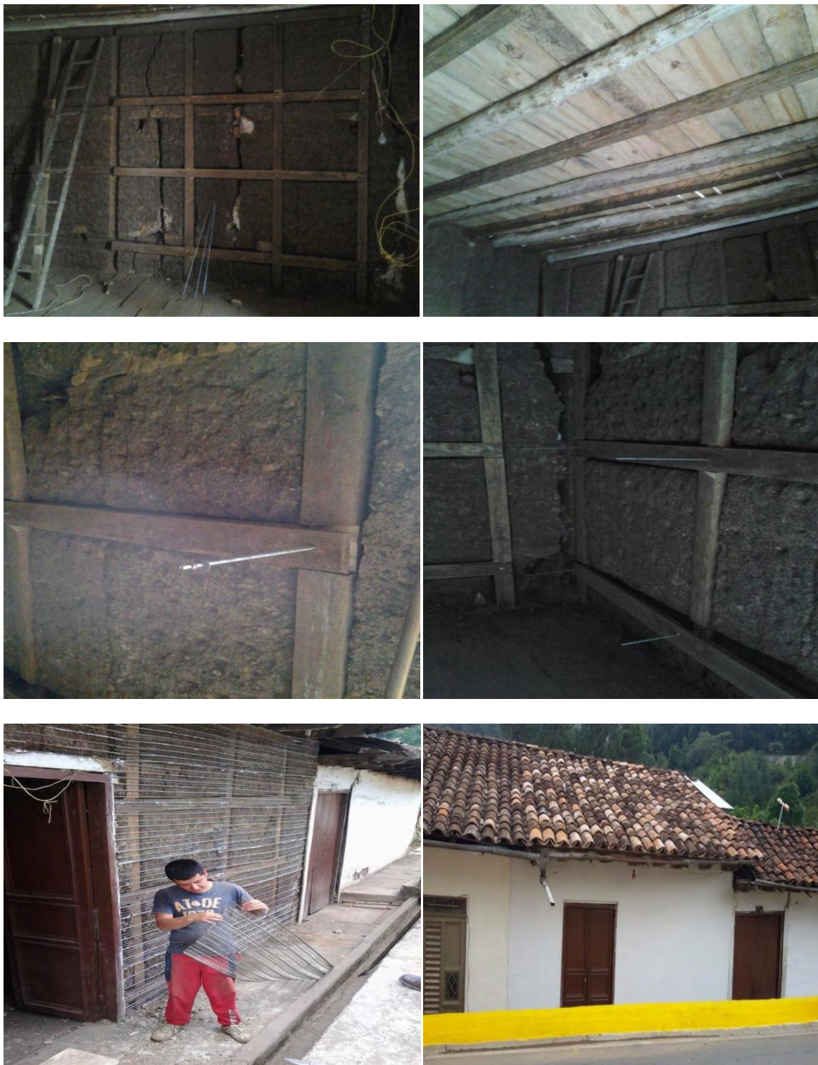
Figura 4. Adecuación y mantenimiento de la casa de habitación del señor Luis Enrique Rosero
