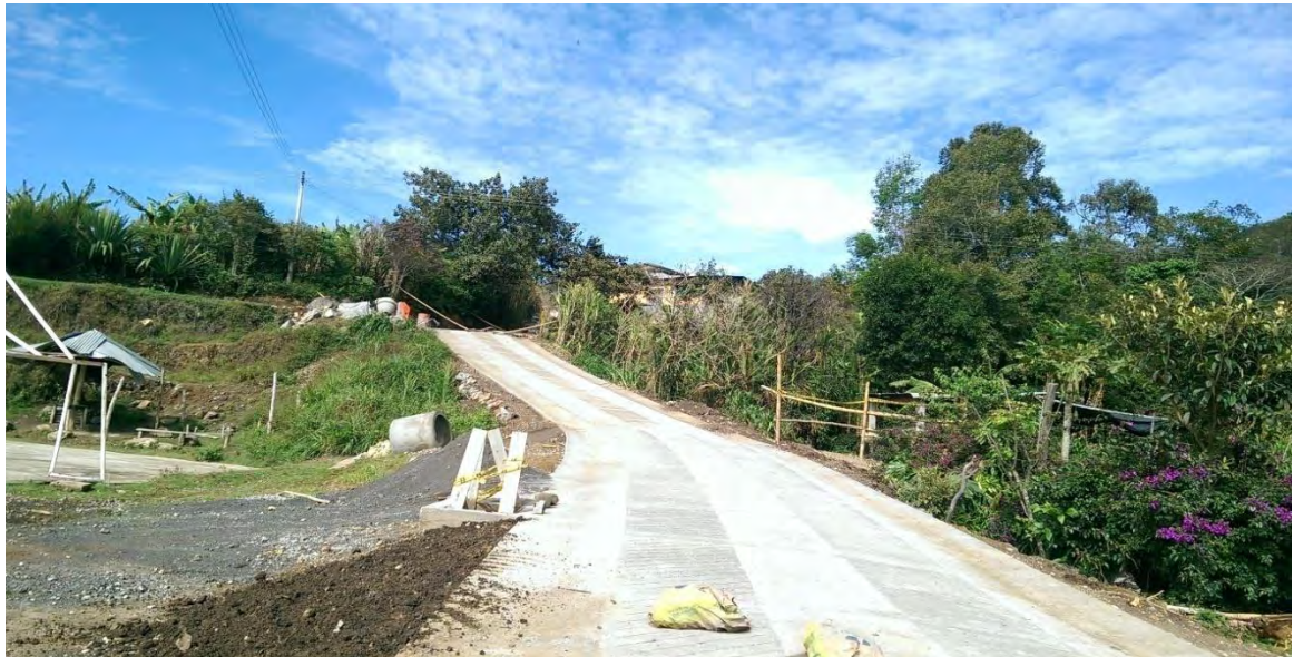
Figura 12. Finalización de obra. Construcción placa huella en la Vereda “La Comunidad”, Municipio de San Pedro de Cartago, Departamento de Nariño.
