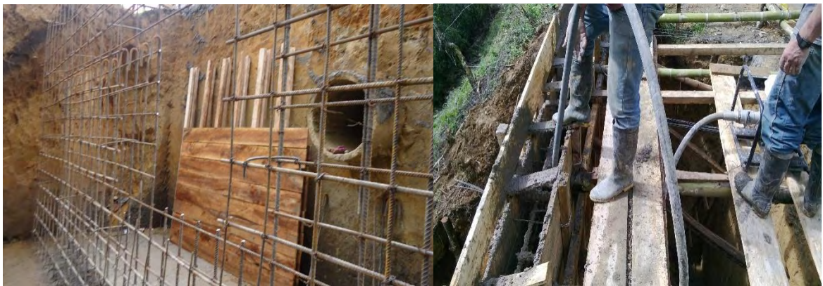
Figura 14. Fundición de muro. Mantenimiento y mejoramiento de la vía Martín - La Estancia, en el Municipio de San Pedro de Cartago, Departamento de Nariño
