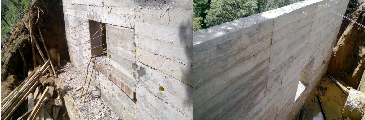
Figura 15. Muro de contención. Mantenimiento y mejoramiento de la vía Martín - la estancia, en el municipio de San Pedro de Cartago, Departamento de Nariño.
