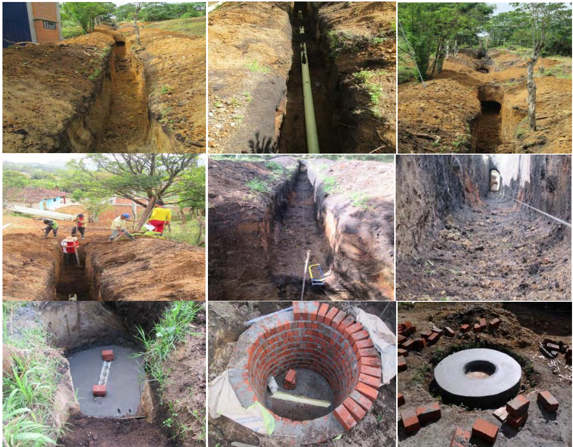
Figura 6. Construcción línea de alcantarillado sanitario del municipio de San Pedro de Cartago – departamento de Nariño.
