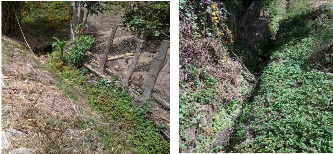
Figura 25. Descarga de aguas sobre un canal en tierra.
