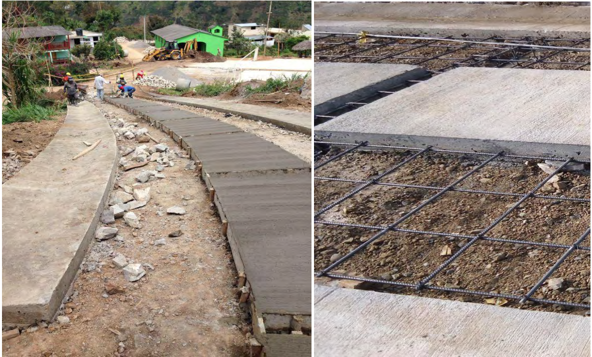
Figura 11. Proceso constructivo. Construcción placa huella en la Vereda “La Comunidad”, Municipio de San Pedro de Cartago, Departamento de Nariño.
