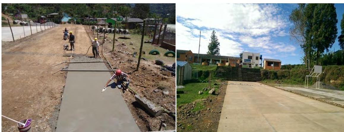
Figura 9. Fundida y terminación. Construcción cancha de “chaza”, en la vereda “la comunidad”, en el municipio de san pedro de Cartago, departamento de Nariño
