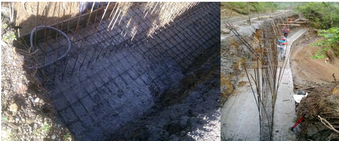
Figura 16. Fundición de zarpa. Mantenimiento y mejoramiento de la vía Martín - La Estancia, en el Municipio de San Pedro de Cartago, Departamento de Nariño
