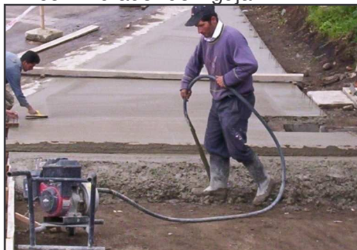
Foto 20. Compactación del Concreto con Vibrador de Aguja
