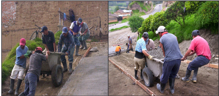
Foto 35. Transporte de Concreto.
