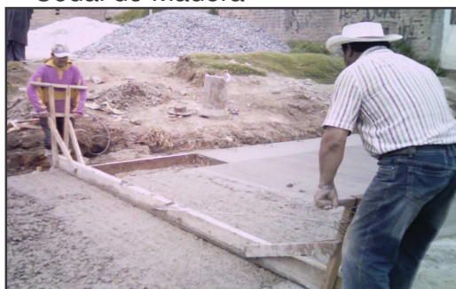
Foto 21. Compactación haciendo uso de Codal de Madera
