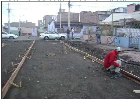
Foto 16. Colocación de Formaleta
