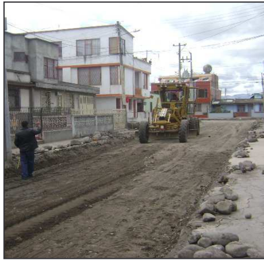
Foto 8. Conformación de Base (Tendido de Material)
