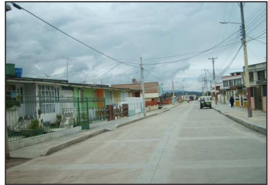
Foto 56. Estado final de la vía (Clle 17 entre Cra 5N y 7N)
