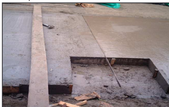
Foto 28. Elaboración de juntas sobre concreto fresco usando platina de 8mm de espesor.
