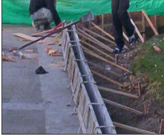
Foto 30. Fundición del Sardinel con Formaleta Metálica
