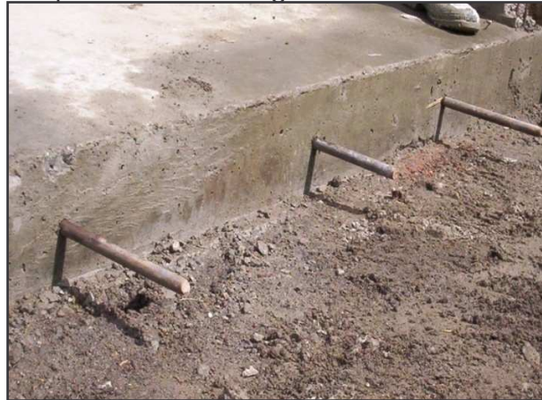
Foto 13. Junta Transversal de Contracción con pasadores de carga en acero liso de 3/4"
