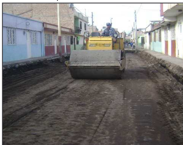
Foto 9. Compactación de Base
