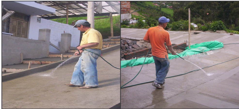
Foto 26. Curado del Concreto
