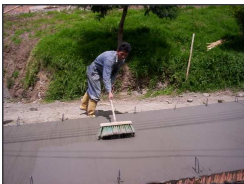
Foto 25. Macrotexturizado de la superficie
