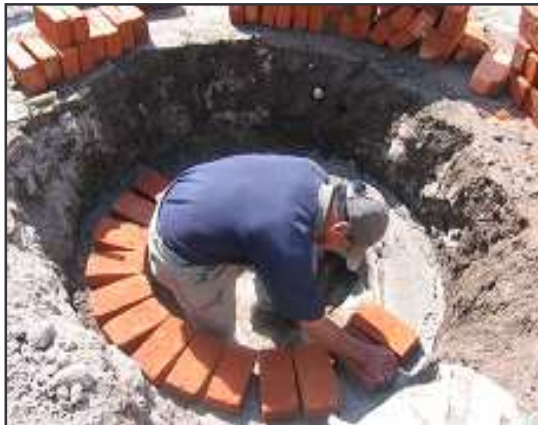
Foto 5. Cámara de Inspección
