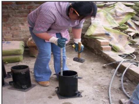
Foto 40. Toma de Ensayos Cilindros
