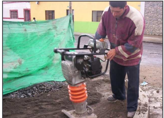
Foto 66. Compactación con saltarín.
