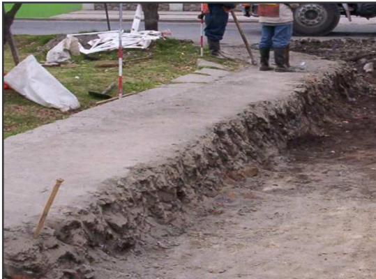
Foto 65. Estado inicial de andenes.
