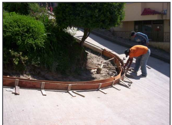
Foto 74. Construcción de Bordillos.
