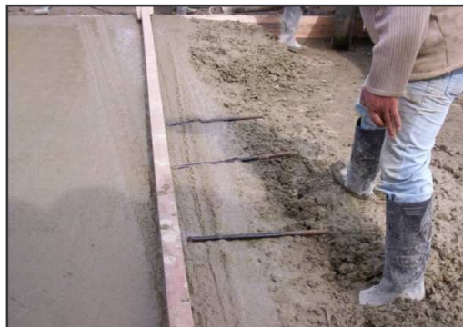
Foto 18. Colocación de Barras Pasajuntas
