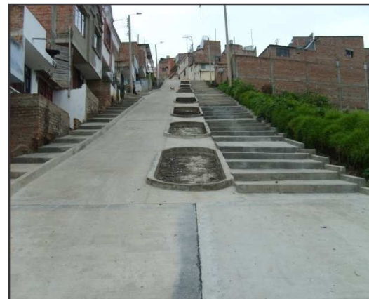
Foto 90. Estado Final Cra 14
