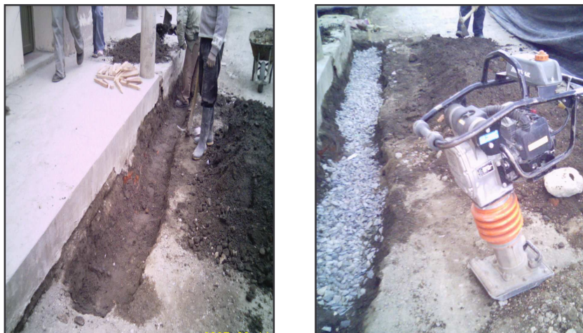
Foto 33. Resane y Compactación de Fallos
