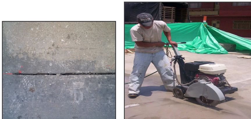
Foto 27. Elaboración de juntas sobre concreto semi – endurecido, usando cortadora de disco de diamante
