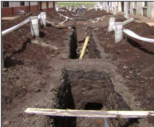
Foto 4. Reposición de Acueducto y Alcantarillado
