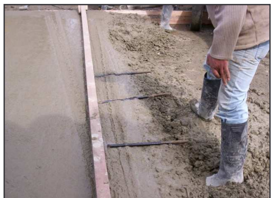
Foto 62. Instalación de pasadores de transferencia de carga acero liso \frac{3}{4} "
