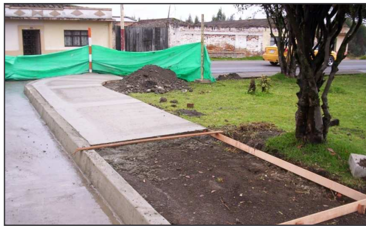
Foto 31. Fundición de Andenes
