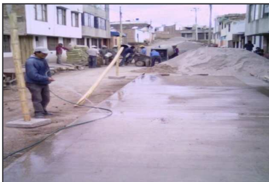
Foto 45. Curado de Losas.
