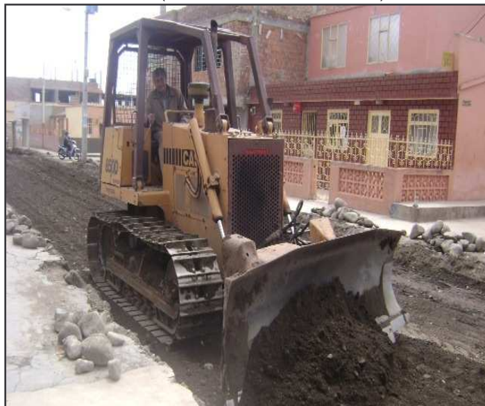
Foto 3. Corte (Movimiento de Tierras)
