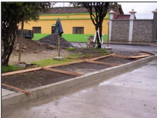
Foto 67. Instalación de formaleta en andenes.
