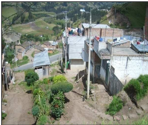
Foto 87. Estado Inicial Cras 14A y 14B
