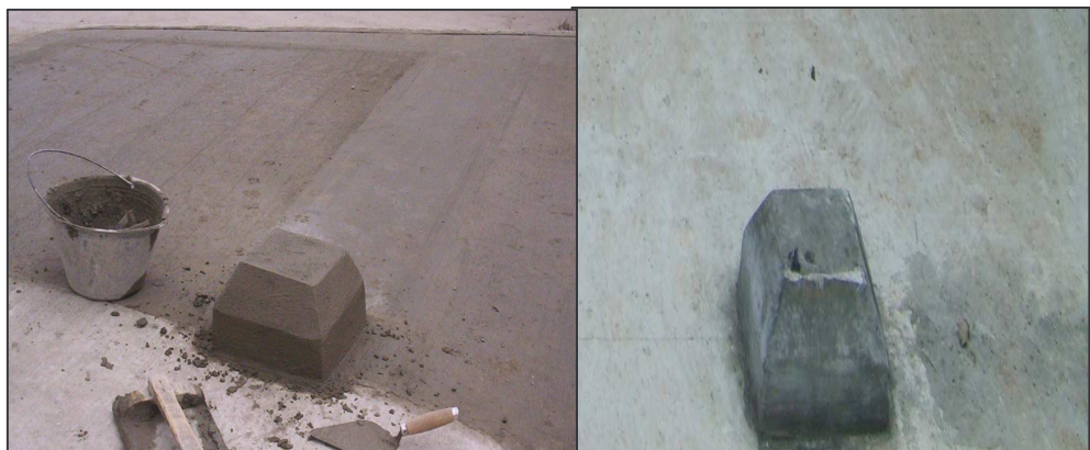
Foto 36. Construcción de Volardos.
