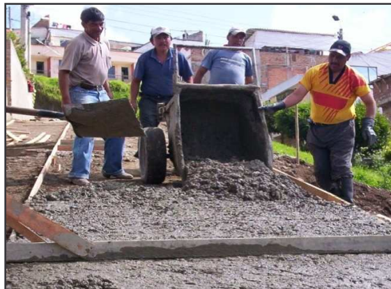
Foto 19. Colocación del Concreto
