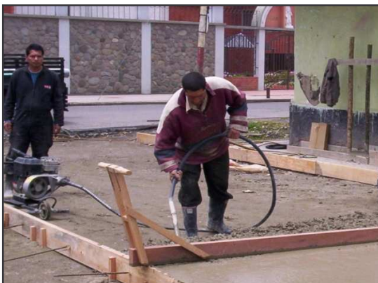
Foto 61. Vibrado de Losas.
