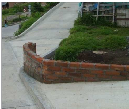
Foto 38. Construcción de Muros
