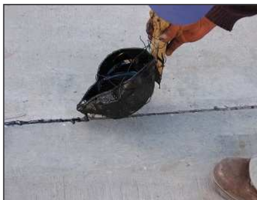
Foto 29. Sellado de Juntas
