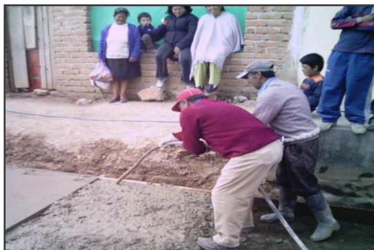
Foto 46. Vibración del Concreto
