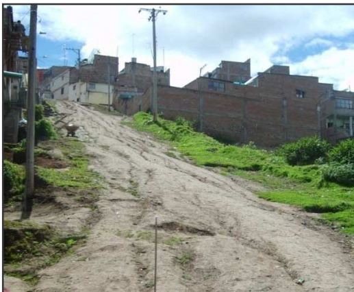
Foto 89. Estado Inicial Cra 14
