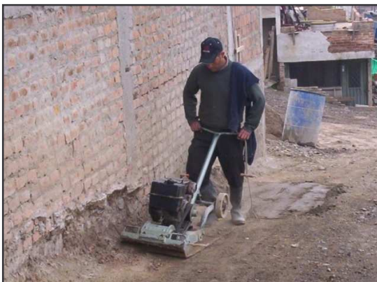
Foto 73. Adecuación de Andenes.
