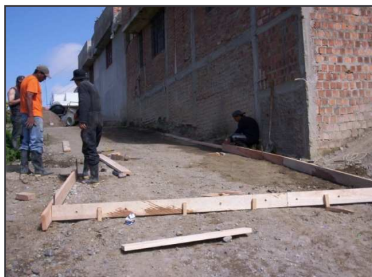
Foto 79. Formaleta de Losas.
