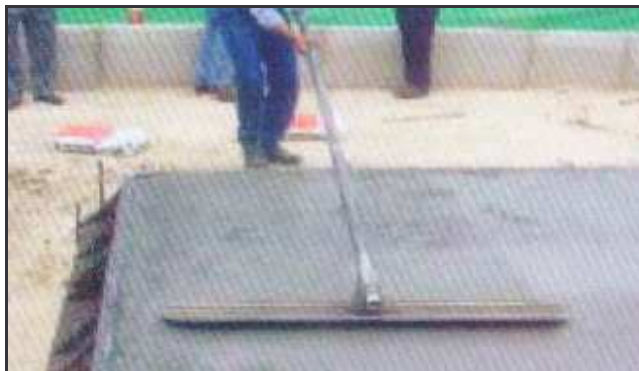
Foto 22. Flotado del Concreto
