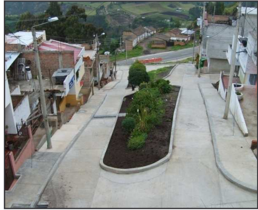
Foto 88. Estado Final Cras 14A y 14B
