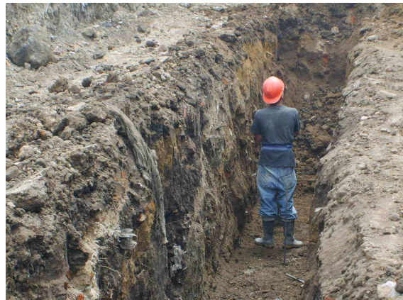
Fotografía 9. Excavación para alcantarillado pluvial
