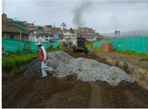
Fotografía 18. Elaboración de la Base granular en el sitio
