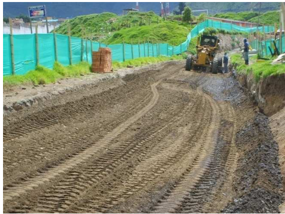
Fotografía 19. Conformación de la Base granular
