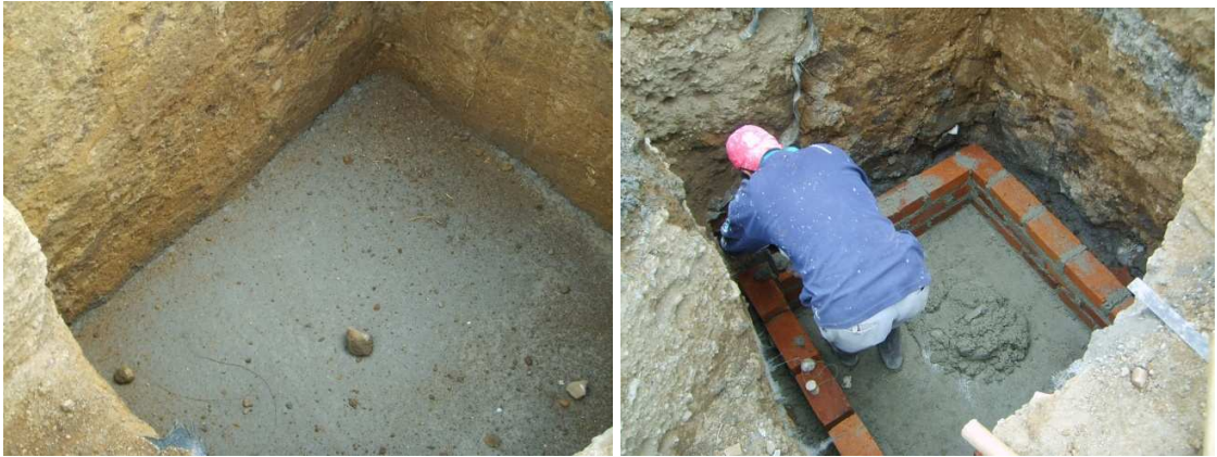
Fotografía 56. Base en concreto para sumidero
