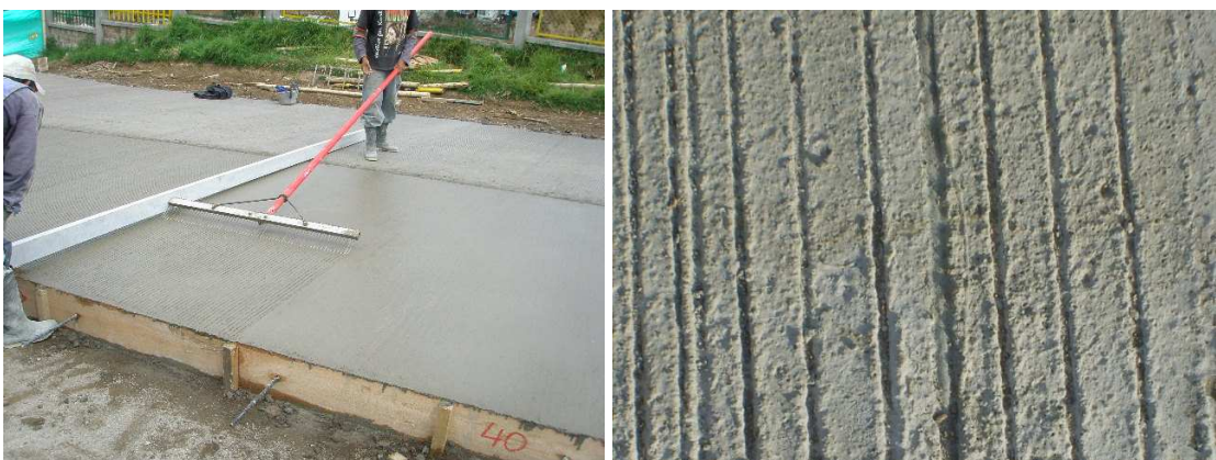
Fotografía 31. Macrotextura con cepillo metálico
