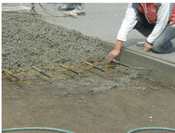
Fotografía 28. Colocación de pasadores en las juntas
