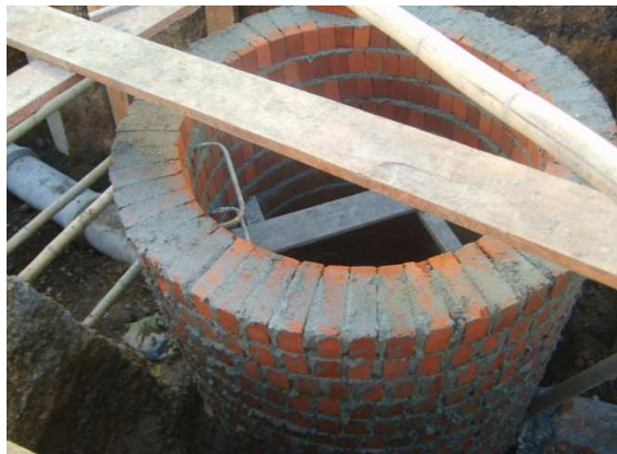
Fotografía 51. Construcción cámara de inspección
