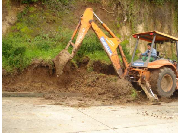
Fotografía 74. Desmante y limpieza andenes Ciudad Real
