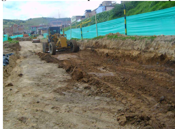
Fotografía 10. Perfilado de la Subrasante
