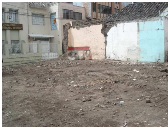
Fotografía 73. Área de demolición limpia carrera 28 entre calles 20 Y 20A
