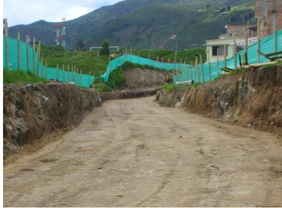
Fotografía 12. Subrasante con capa granular de 15 cm antes de extendido del Geotextil
