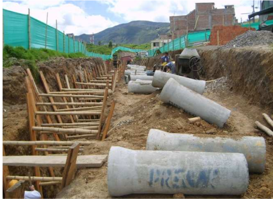
Fotografía 45. Tubería acordonada para instalación
