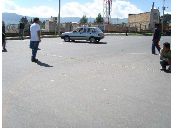
Fotografía 80. Localización y replanteo Glorieta Sector VIPRI
