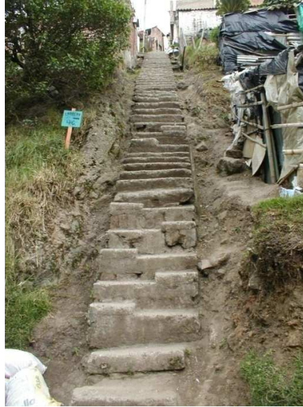
Fotografía 78. Escaleras sector el polvorín Pandiaco
