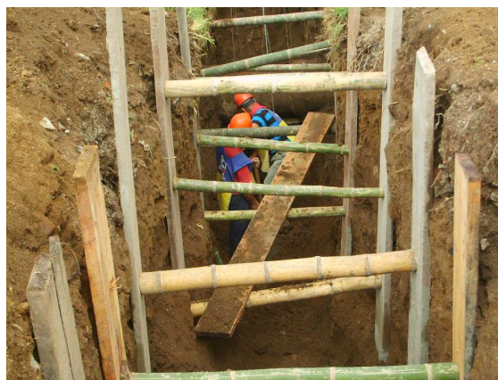
Fotografía 44. Excavación y entibado para tubería de alcantarillado
