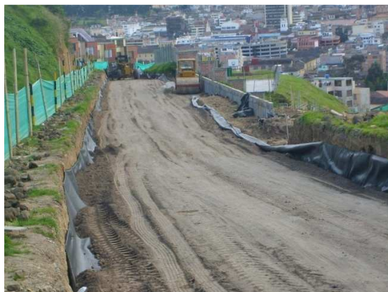
Fotografía 16. Compactación del mejoramiento
