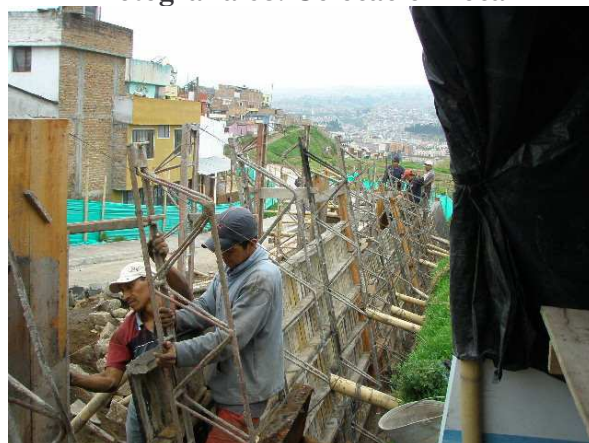
Fotografía 69. Formaleta cuerpo del muro
