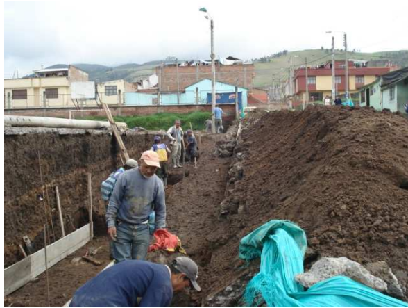
Fotografía 65. Excavación para zarpa del muro
