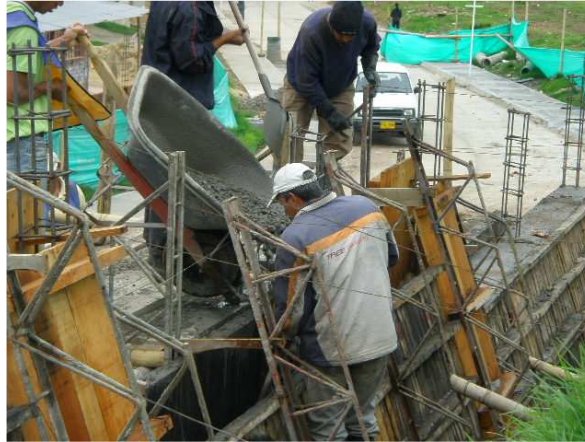
Fotografía 70. Vaciado del concreto en cuerpo del muro
