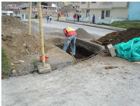
Fotografía 38. Excavación a mano para andenes
