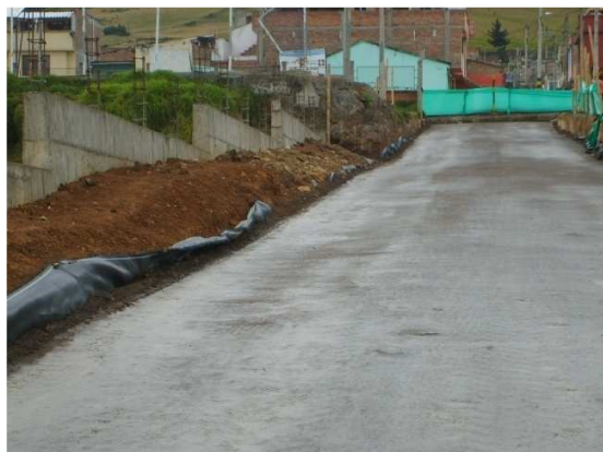
Fotografía 21. Base granular terminada
