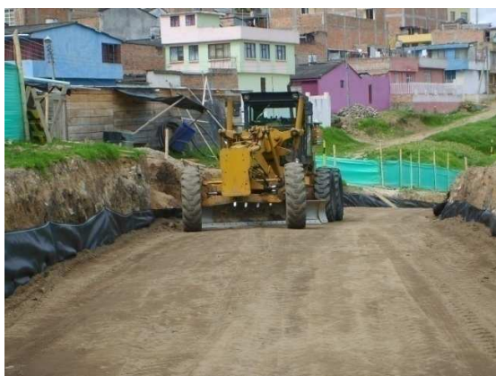
Fotografía 17. Perfilado y nivelación del mejoramiento
