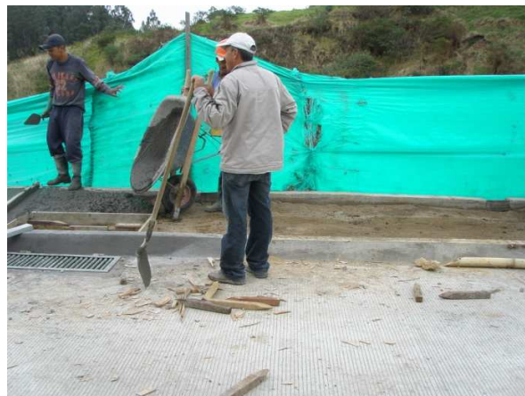
Fotografía 42. Vaciado del concreto
