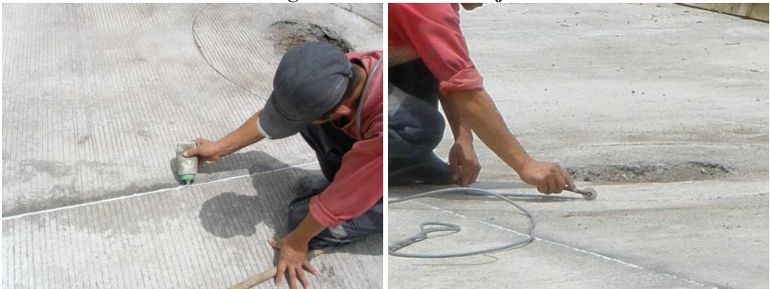
Fotografía 33. Sellado de las juntas
