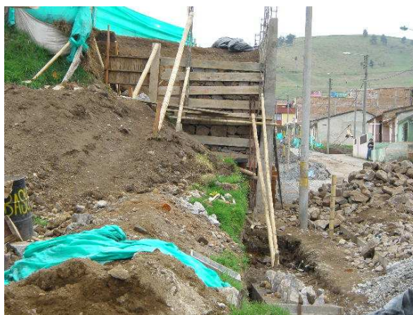
Fotografía 63. Apoyo para muro en gaviones
