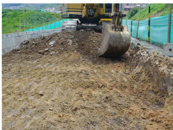
Fotografía 7. Excavación para cajero K0+120
