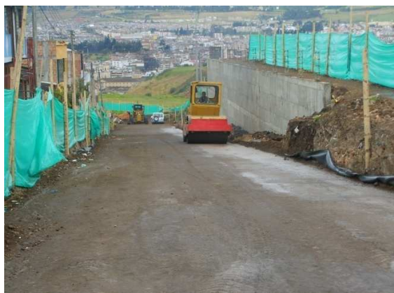
Fotografía 20. Compactación de la Base granular
