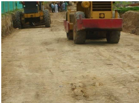
Fotografía 11. Compactación de la Subrasante
