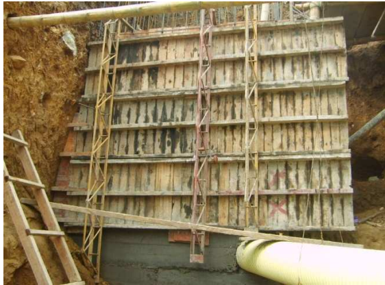
Fotografía 54. Formaleta cámara reforzada
