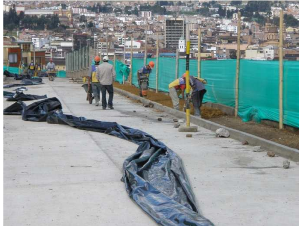
Fotografía 39. Transporte y colocación del material de base para andenes
