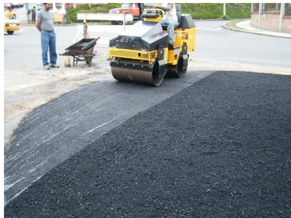
Fotografía 84. Reposición con pavimento asfáltico Sector VIPRI
