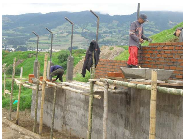
Fotografía 60. Muro de cerramiento en ladrillo
