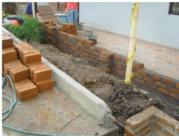
Fotografía 59. Construcción muro en ladrillo
