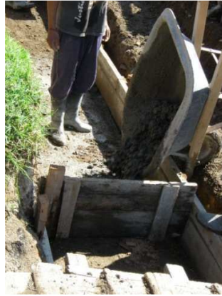
Fotografía 67. Fundición zarpa de concreto
