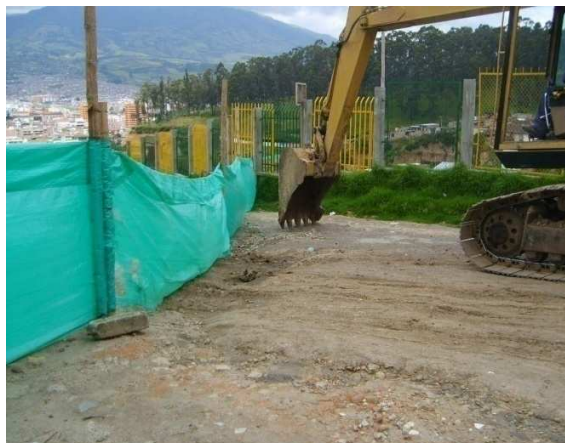
Fotografía 6. Inicio de la excavación para cajero K0+00
