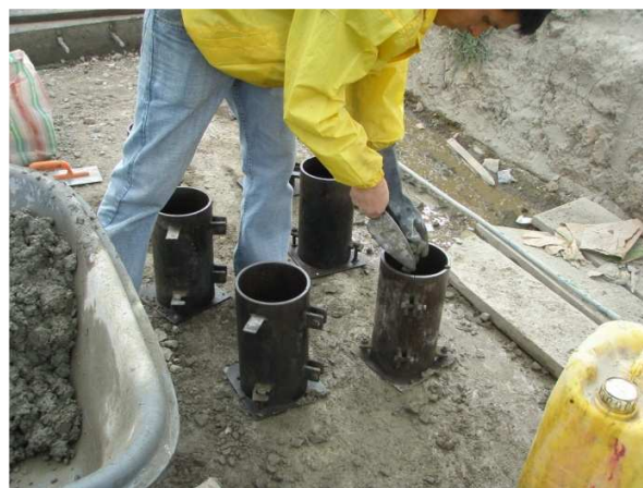
Fotografía 34. Toma de cilindros de concreto de losas de pavimento
