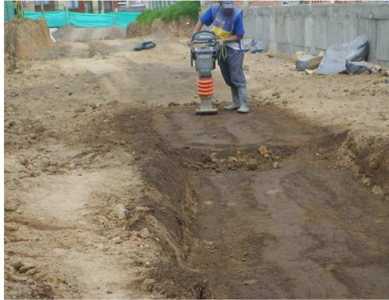
Fotografía 48. Compactación relleno de zanjas para alcantarillado
