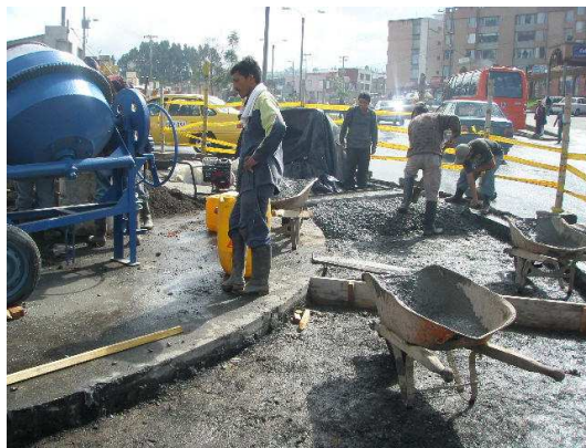
Fotografía 86. Fundición y elaboración concreto texturizado Glorieta Sector VIPRI
