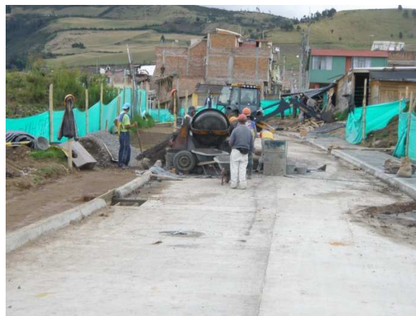
Fotografía 41. Elaboración del concreto para andenes en el sitio
