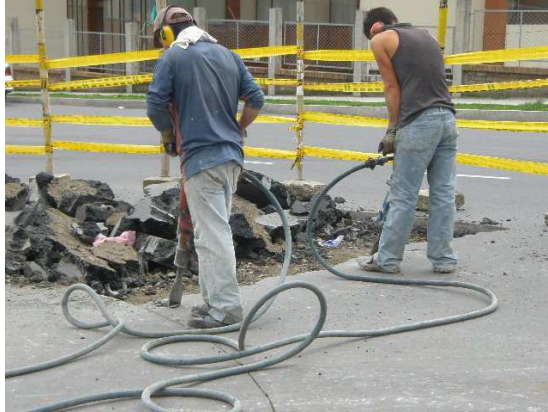
Fotografía 85. Demolición pavimento asfáltico Glorieta Sector VIPRI
