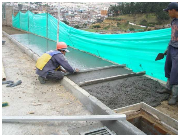
Fotografía 43. Alisado del concreto
