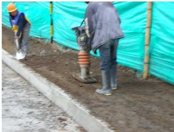
Fotografía 40. Compactación del material de base para andenes
