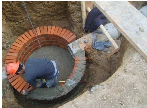
Fotografía 52. Empalme de tubería a cámara de inspección
