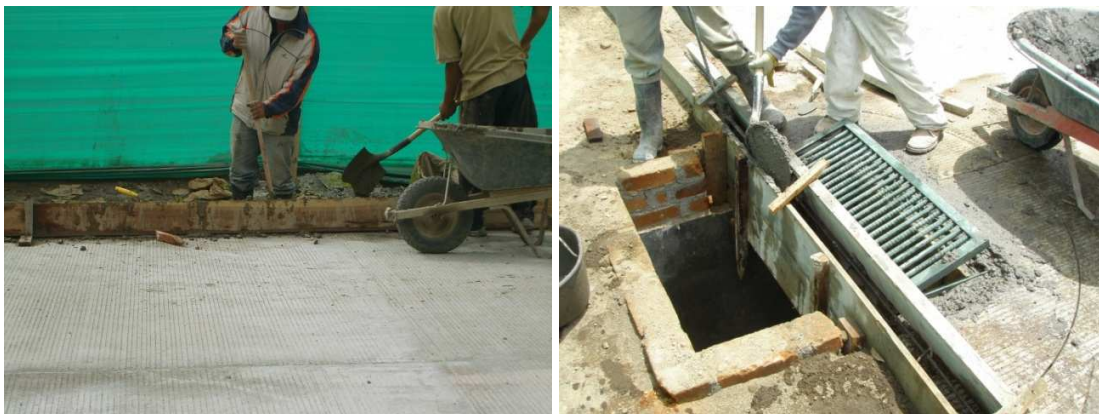
Fotografía 36. Vaciado del concreto para el sardinel
