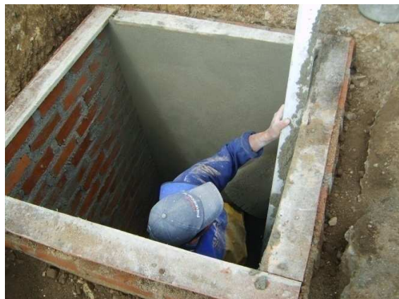
Fotografía 57. Repello parte interna sumidero
