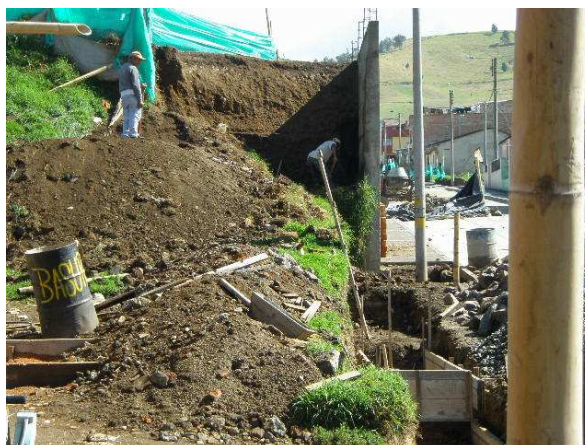
Fotografía 61. Desmonte y limpieza
