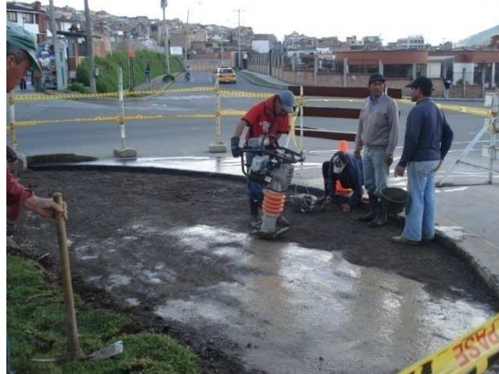
Fotografía 83. Base para reposición de pavimento Sector VIPRI
