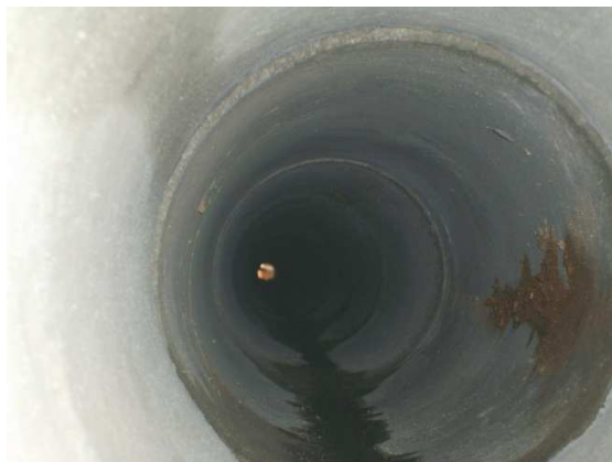
Fotografía 50. Prueba de alineamiento de tubería
