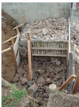
Fotografía 62. Colocación roca en formaleta
