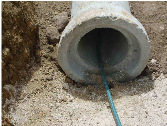
Fotografía 49. Prueba de infiltración de tubería
