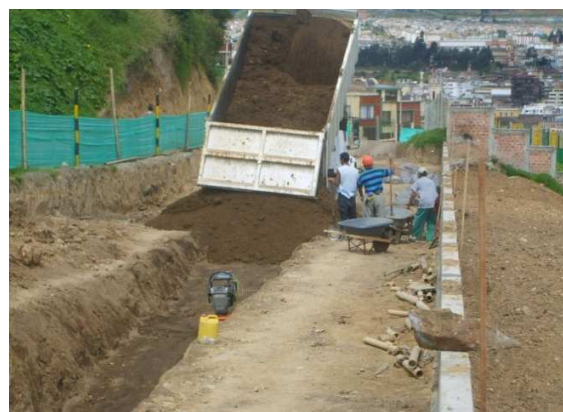
Fotografía 47. Relleno de zanjas para alcantarillado con recebo
