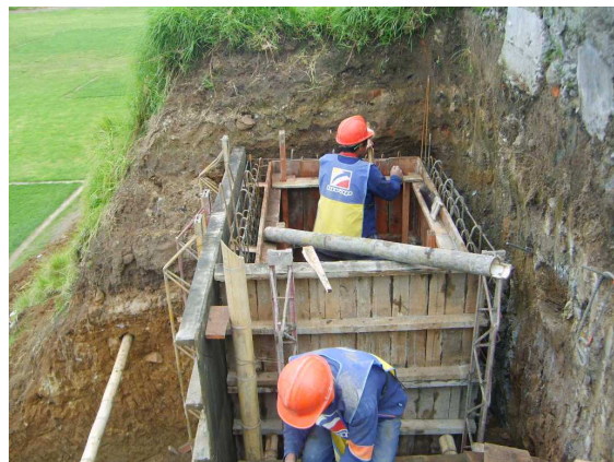
Fotografía 55. Construcción cámara reforzada
