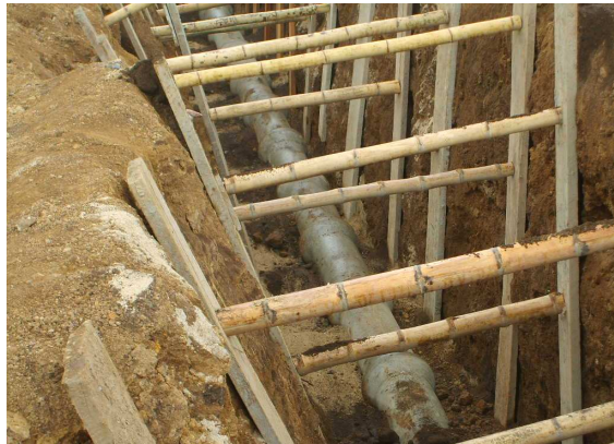
Fotografía 46. Instalación de tubería
