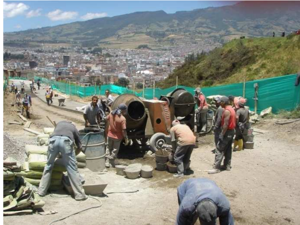
Fotografía 23. Mezclado del concreto en el sitio de la obra
