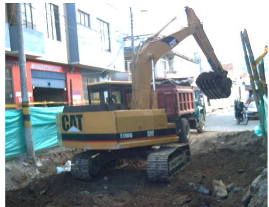
Imagen 149. Retiro material excavado.
