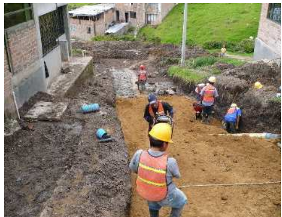
Imagen 8. Mejoramiento Calle 30C.
