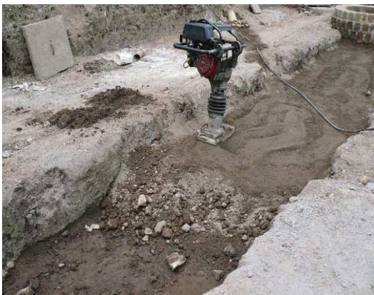
Imagen 164. Relleno compactación RC.
