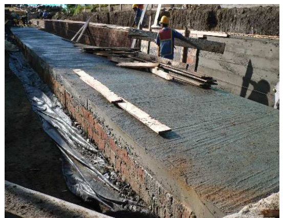
Imagen 110. Encamisado mampostería fundición losa.
