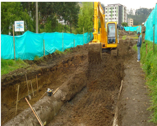
Imagen 99. Excavación a maquina.
