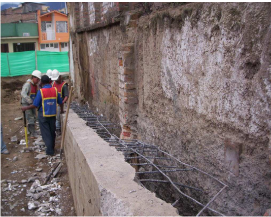
Imagen 69. Demolición muro andén.
