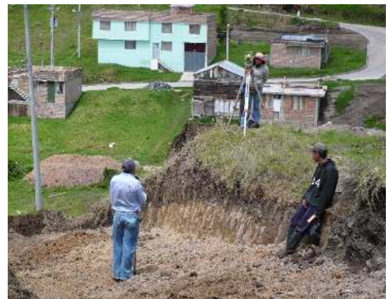
Imagen 2. Localización y replanteo.
