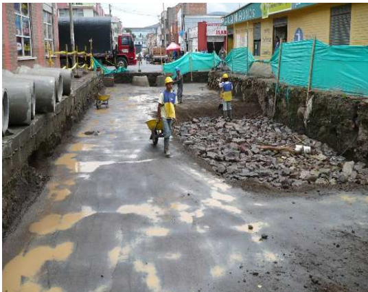
Imagen 217. Mejoramiento sector 2 rajón y recebo.
