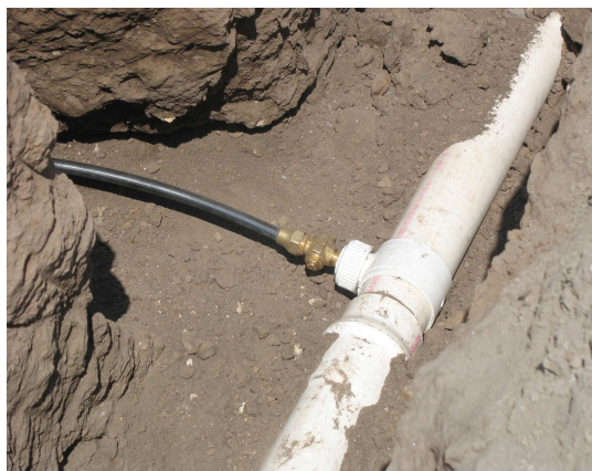
Imagen 61. Instalación galápago y llave incorporación.
