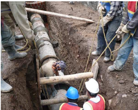
Imagen 54. Instalación tubería \varnothing= 20'' .
