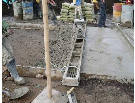
Imagen 132. Placa vibración regla.
