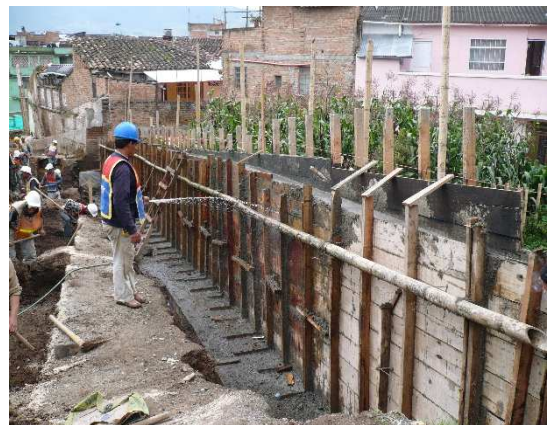
Imagen 64. Cuerpo muro reforzado.
