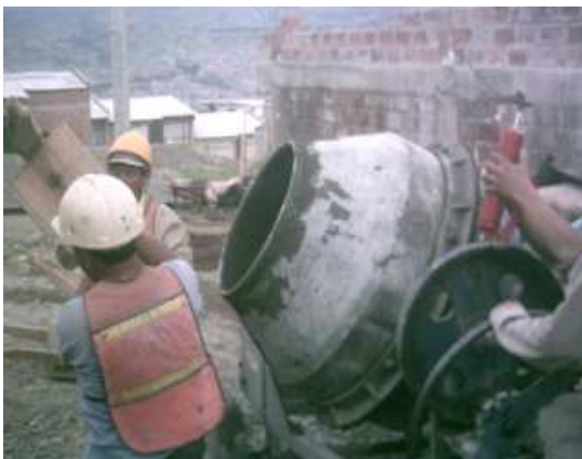
Imagen 15. Placa de concreto cuadrilla.
