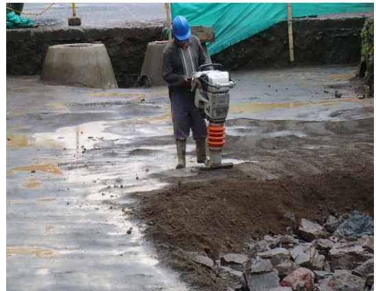
Imagen 218. Mejoramiento sector 2 compactación.
