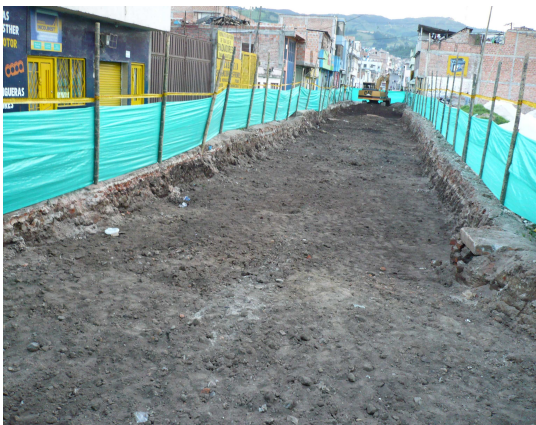
Imagen 148. Excavación a máquina.
