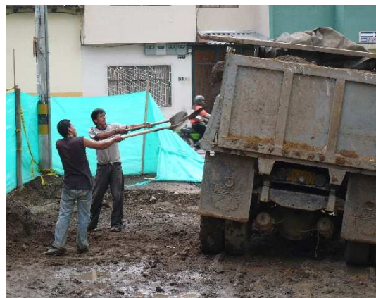
Imagen 50. Retiro de sobrantes.
