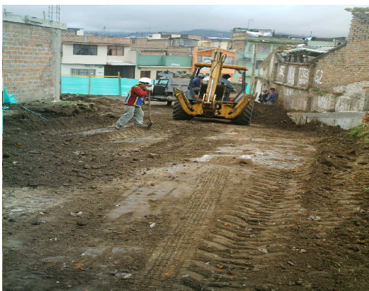
Imagen 49. Excavación a máquina.
