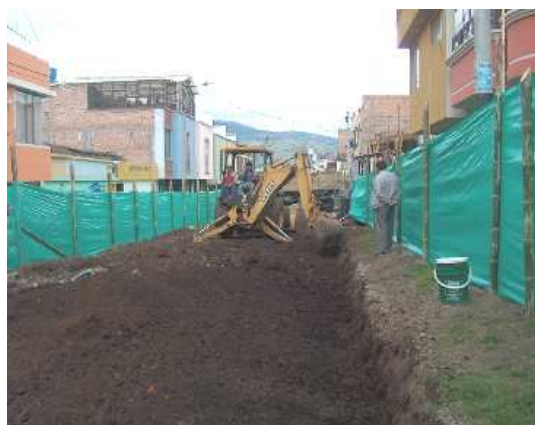
Imagen 29. Excavación a máquina.
