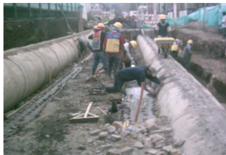
Imagen 106. Base encamisado y revoque anillos.
