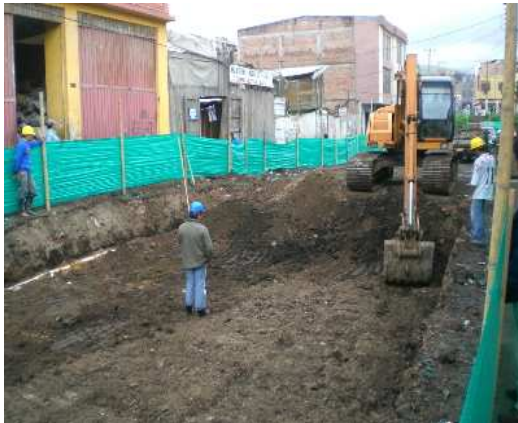
Imagen 180. Excavación a máquina.
