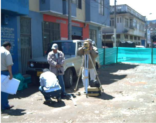
Imagen 146. Localización y replanteo - Sector Villa del Río.
