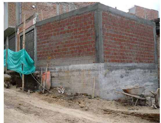
Imagen 66. Pórtico y mampostería.
