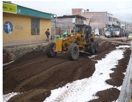
Imagen 220. Mejoramiento geotextil conformación.
