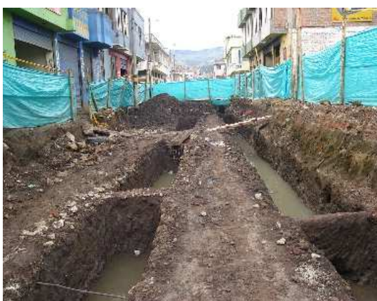
Imagen 150. Excavación manual alcantarillado sanitario y pluvial.
