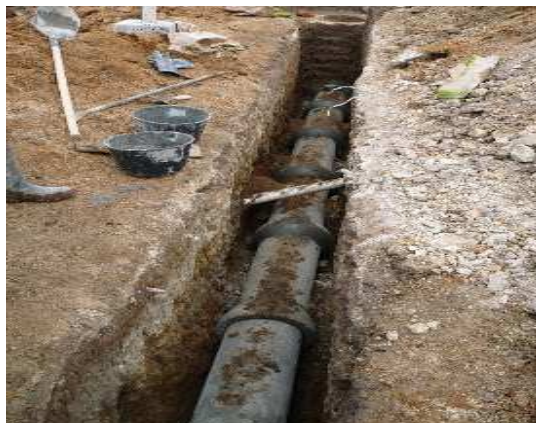
Imagen 6. Instalación tubería 10" concreto y atraque.
