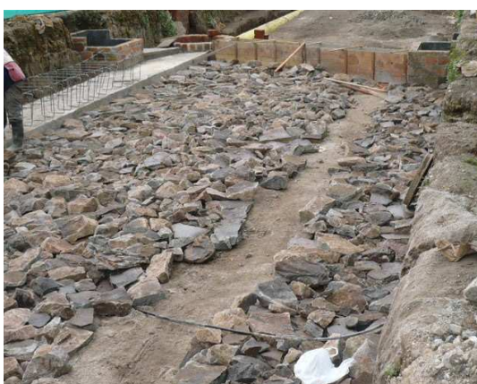
Imagen 173. Mejoramiento subrasante rajón e=25cm.
