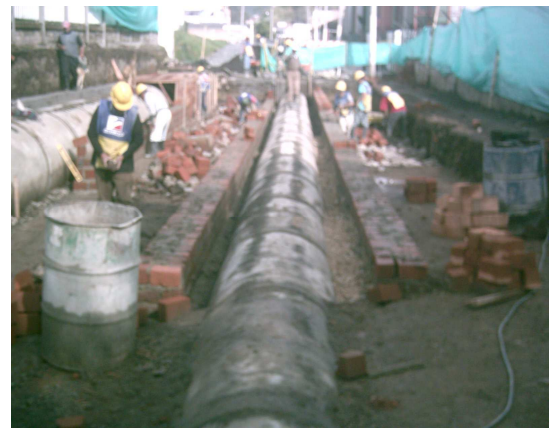
Imagen 108. Encamisado mampostería pega.
