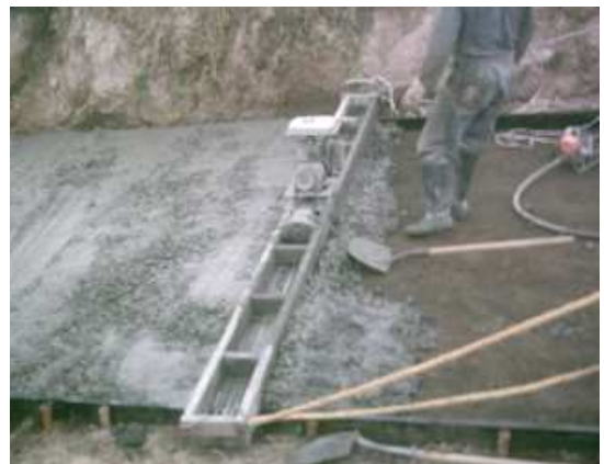
Imagen 16. Placa de concreto vibración
