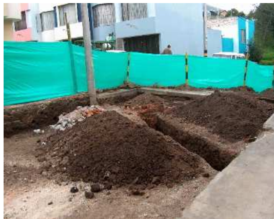
Imagen 31. Excavación a mano
