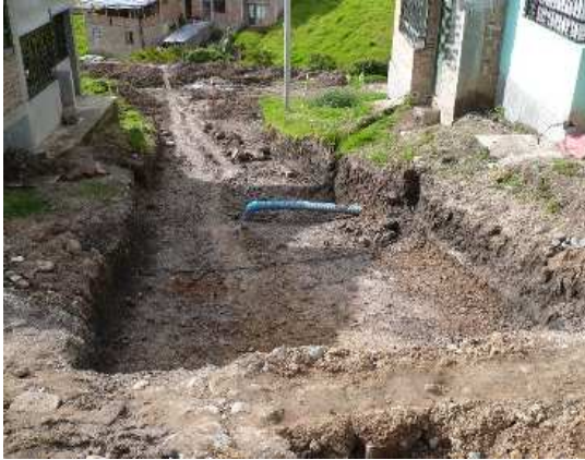
Imagen 4. Excavación a mano.
