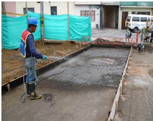
Imagen 83. Base humedecida y malla.
