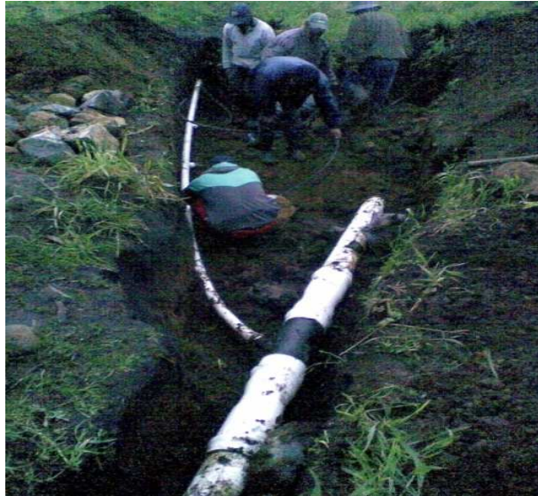
Fotografía No. 59. Instalación de ramal de 2" para los Lirios.
