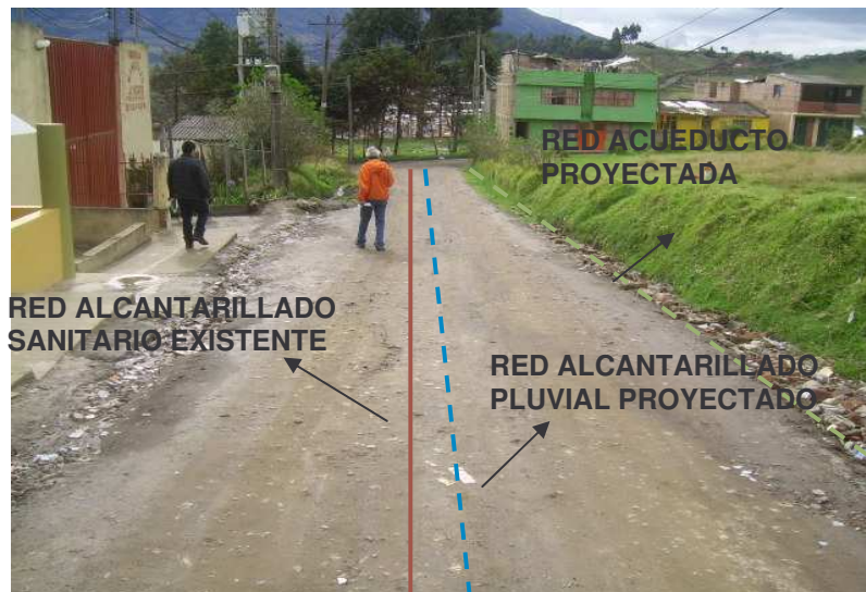
FIGURA N° 29. INSPECCIÓN DE CAMPO URBANIZACIÓN TORRE LADERA (CARRERA 29 CON CALLE 34).
