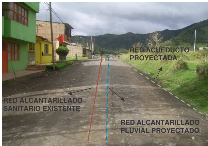
FIGURA N° 28. INSPECCIÓN DE CAMPO URBANIZACIÓN TORRE LADERA (CALLE 34).
