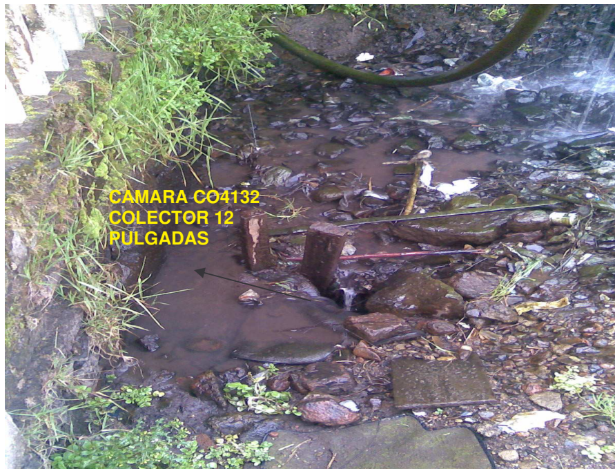
FIGURA N° 39. INSPECCIÓN DE CAMPO CÁMARA CO4132 CANALIZACIÓN QUEBRADA LOS CHANCOS.
