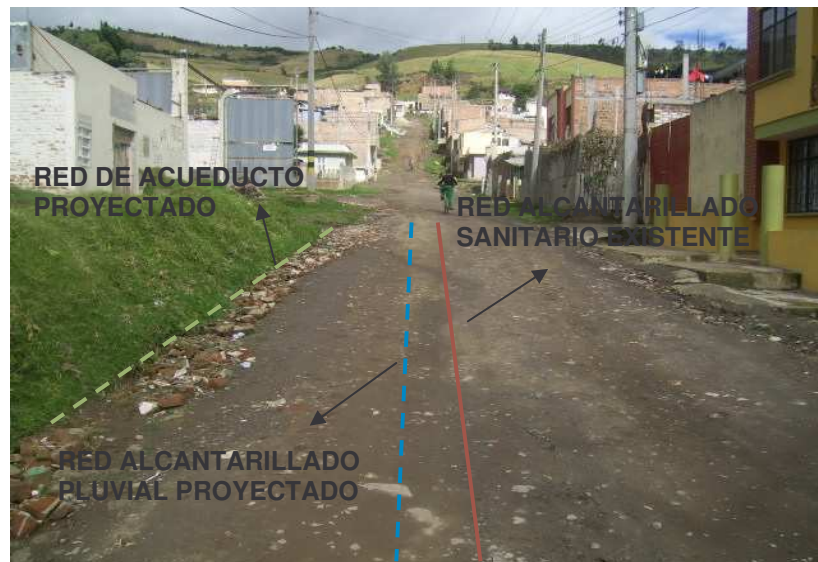
FIGURA N° 31. INSPECCIÓN DE CAMPO URBANIZACIÓN TORRE LADERA (CARRERA 29).
