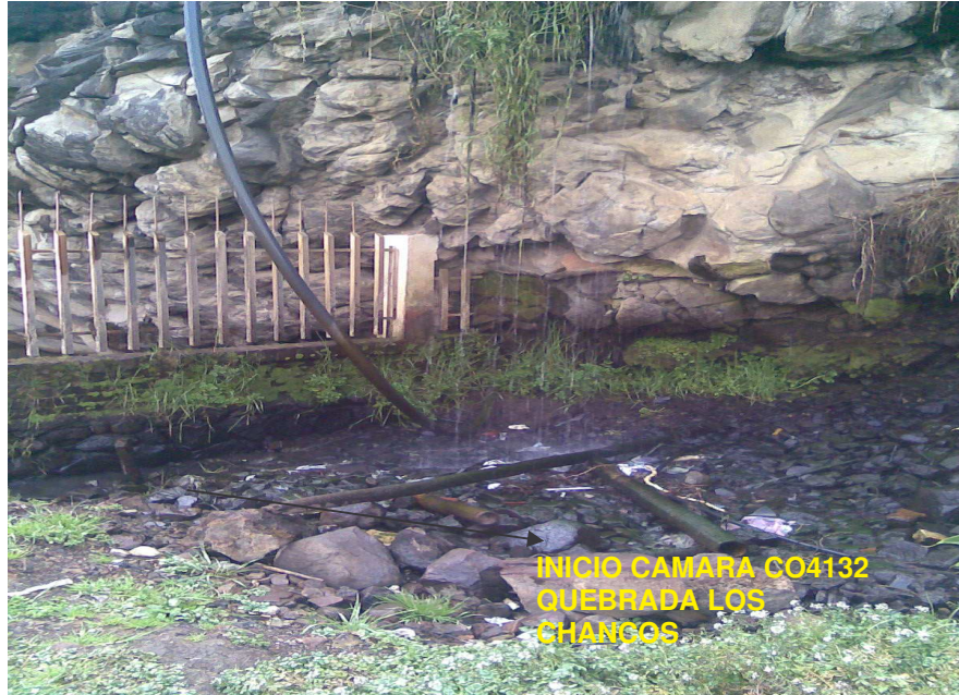
FIGURA N° 38. INSPECCIÓN DE CAMPO CÁMARA CO4132 (CAÍDA DE AGUA) CANALIZACIÓN QUEBRADA LOS CHANCOS.
