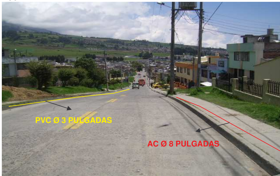
FIGURA N° 10. LOCALIZACIÓN CALLE 6SUR CON CARRERA 22ª (TAMASAGRA).
