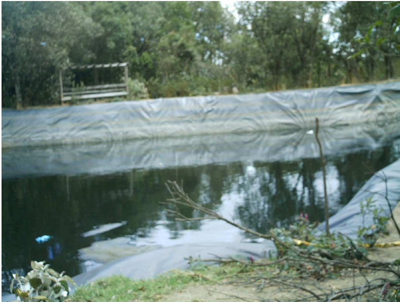
Figura No. 16.: Lixiviado relleno sanitario Antanas
