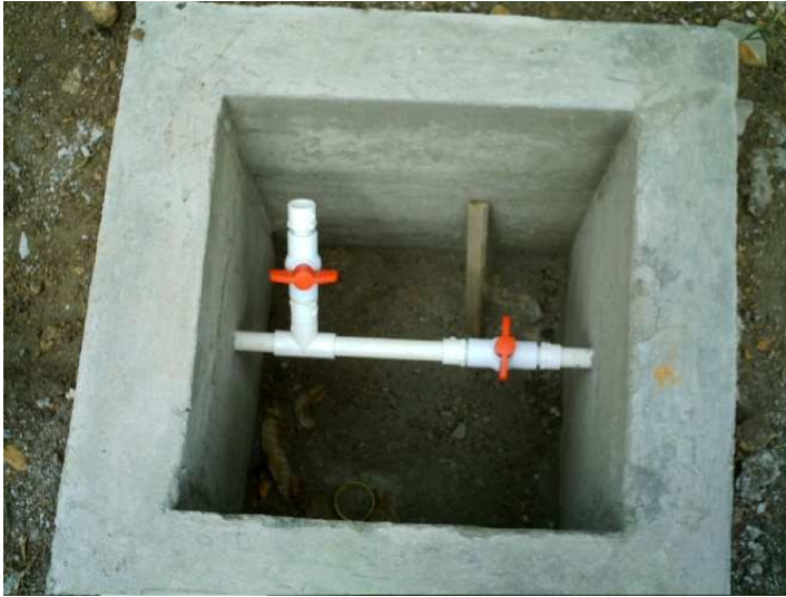
Figura No 30 Cajilla de control de caudal y muestreo lixiviado de entrada construida
