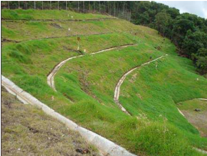
Figura No. 5: Canaletas recolección aguas lluvias
