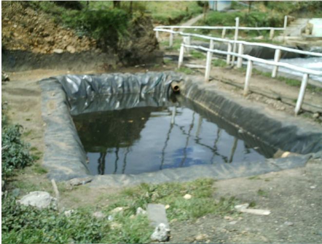
Figura No 26. : Laguna anaerobia excesos
