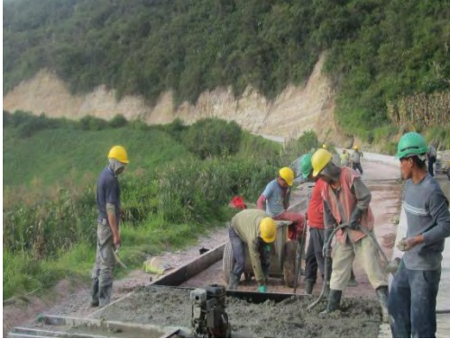
Figura 69. Vibración del concreto
