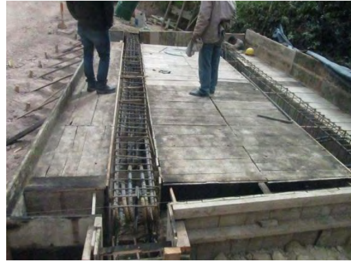
Figura 111. Acero vigas pontón 1
