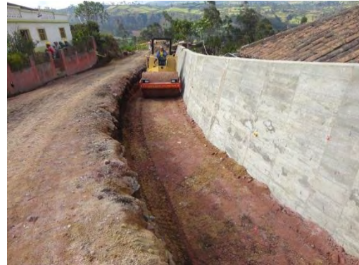
Figura 41. Relleno muro 1 k0+250
