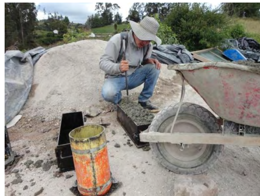
Figura 79. Toma de vigas
