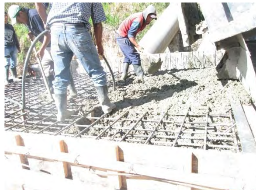
Figura 115. Fundición losa pontón 2
