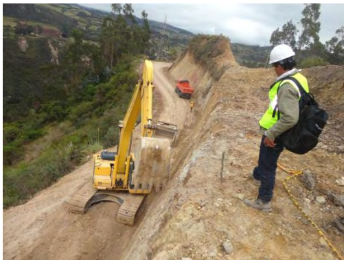
Figura 4. Corte de talud
