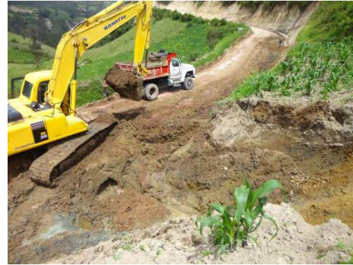
Figura 18. Desalojo de derrumbes
