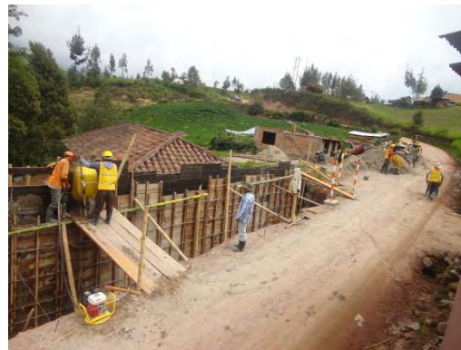
Figura 45. Fundición vástago muro
