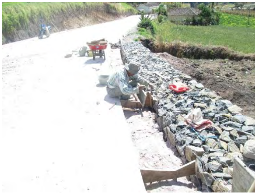
Figura 87. Construcción de gaviones
