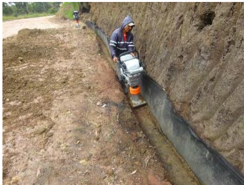
Figura 91. Relleno compactado geodrén
