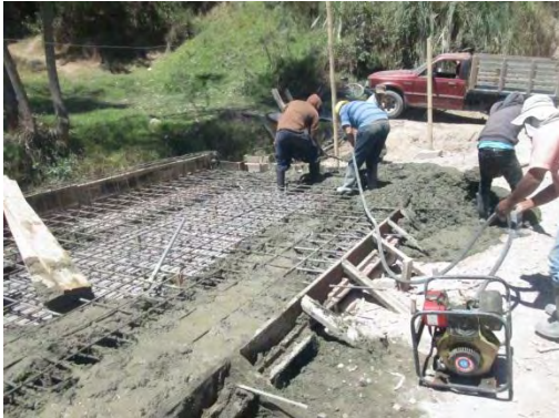
Figura 112. Fundición de losa pontón1
