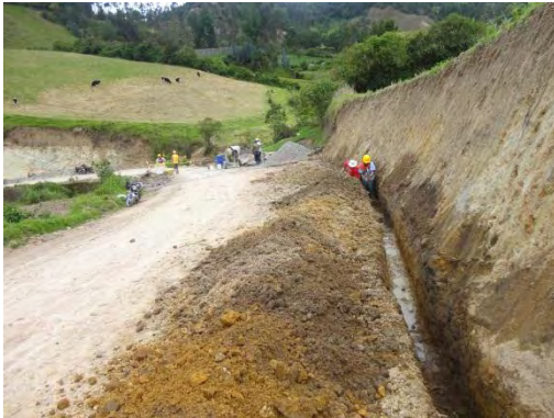
Figura 89. Excavación para geodrén
