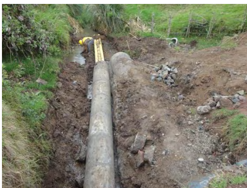
Figura 98. Alcantarilla paralela a 36"
