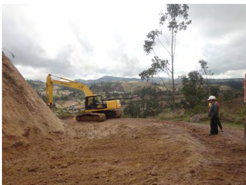
Figura 12. Ampliación de calzada
