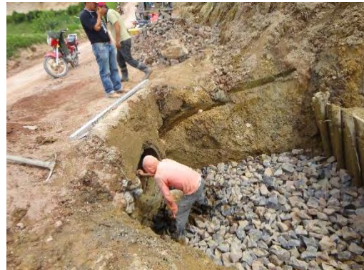
Figura 84. Demolición de caja Alcantarilla
