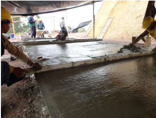
Figura 71. Nivelación con codal
