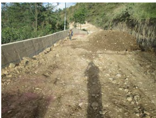
Figura 14. Material para terraplén
