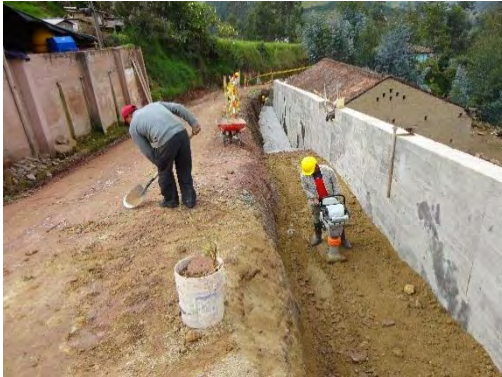
Figura 40. Relleno muro 2 k1+880
