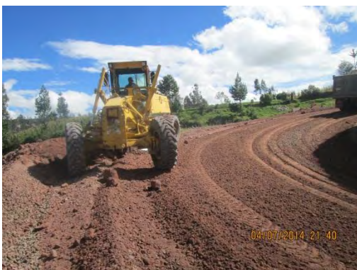
Figura 85. Extendido para terraplen
