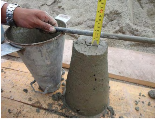
Figura 46. Prueba de asentamiento
