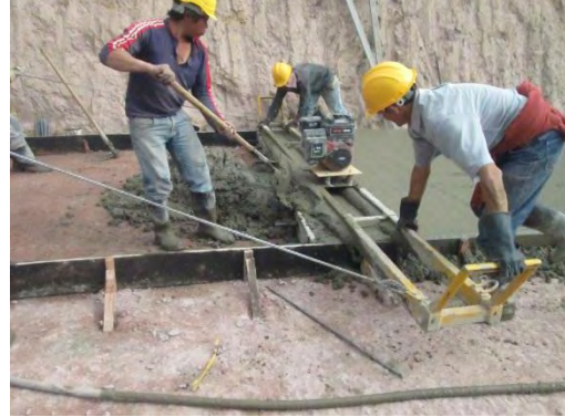
Figura 70. Vibración externa (regla vibratoria)
