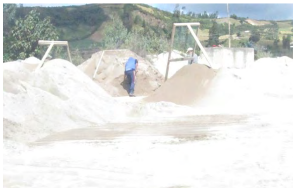
Figura 80. Tamizado de arena en la planta
