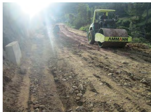
Figura 86. Compactación de terraplén
