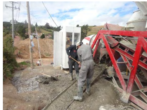
Figura 64. Producción concreto en planta
