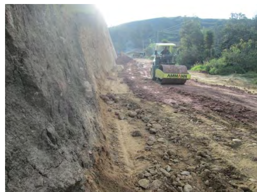
Figura 15. Compactación de terraplén
