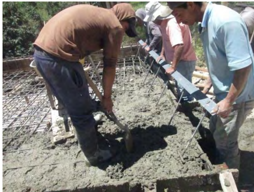
Figura 118. Colocación de ángulos para juntas
