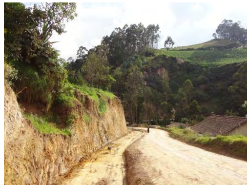
Figura 5. Cajeo para mejoramiento
