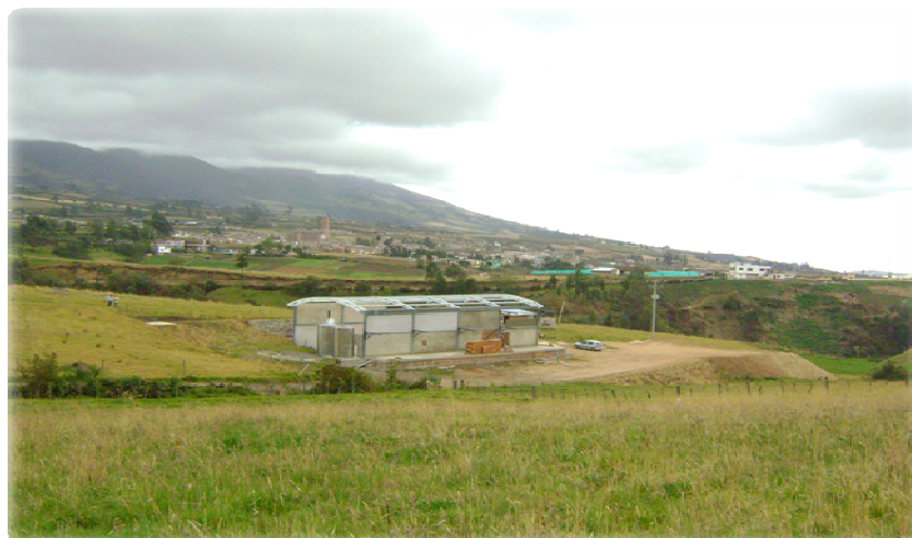
Planta en Construcción – COLENA
