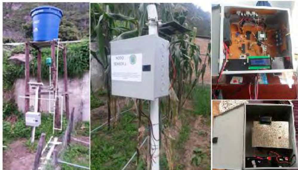
Figura 59. Instalación de los nodos en el sitio de prueba
