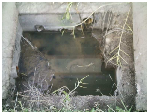
Figura 16. Desarenador Laboratorios de Ingeniería (L1)
