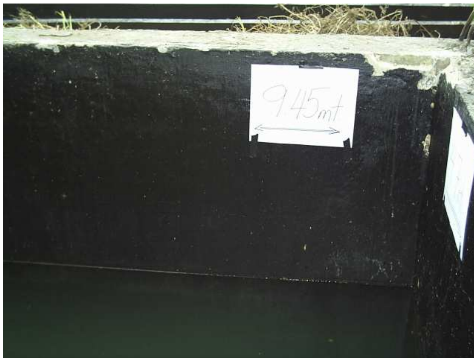
Figura 14. Medición del tanque.
