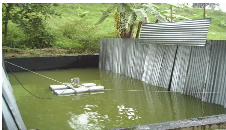
Figura 24. Recubrimiento del tanque.
