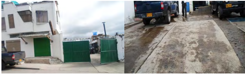
Figura 2. Área externa de la planta
