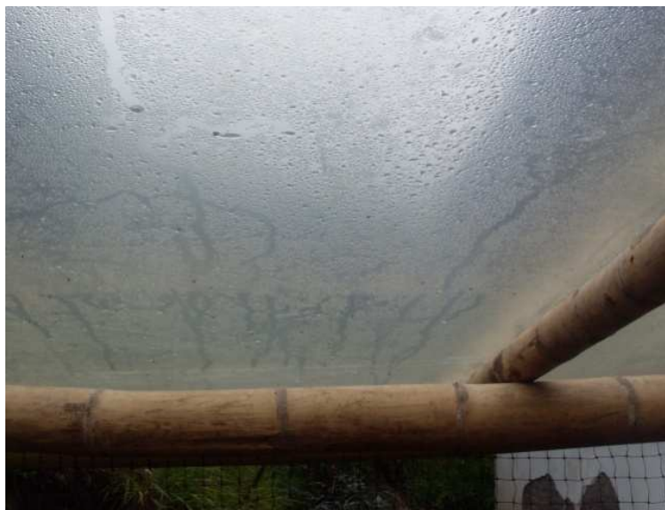
Fotografía 15. Agua condensada en el plástico de invernadero
